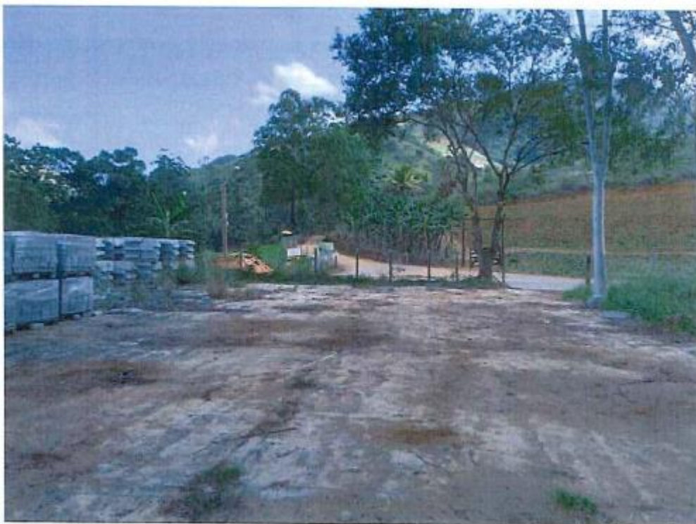
Área onde será implantado o canteiro de obras
