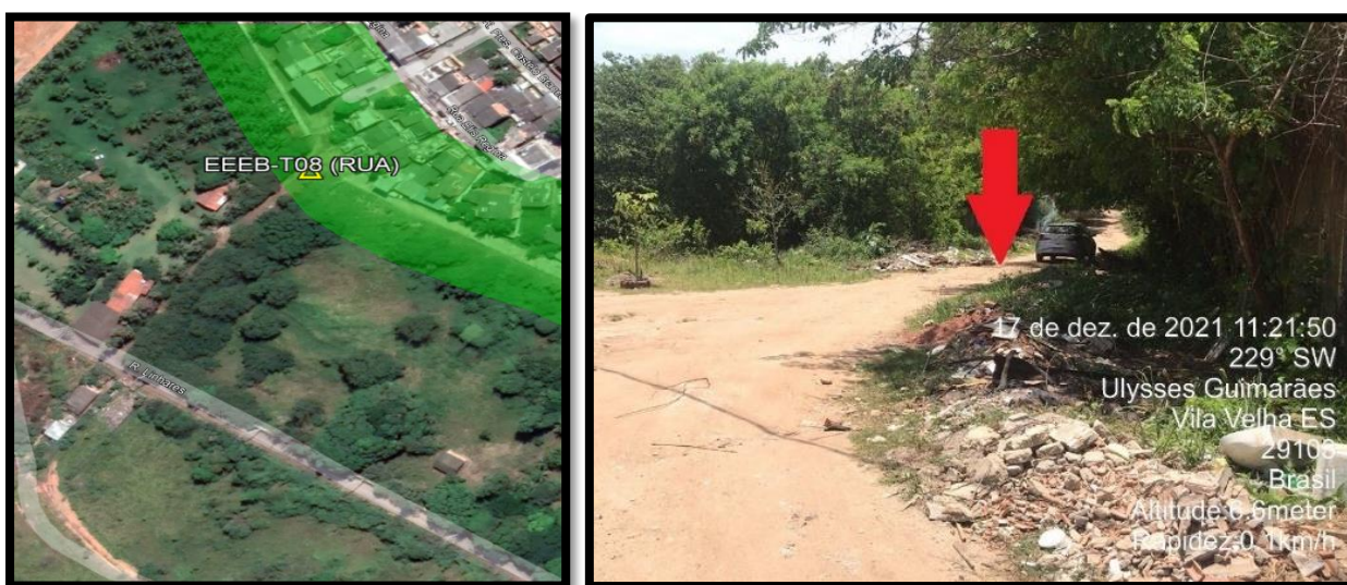
Figura 3.28. Localização da estação elevatória EEEB-T08.
