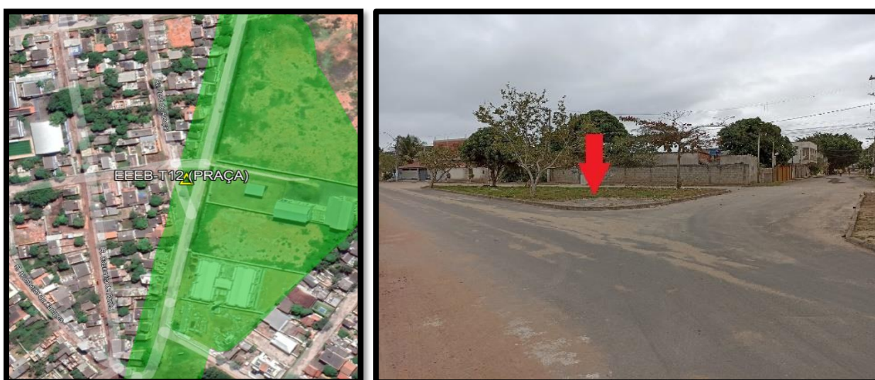
Figura 3.32. Foto aérea e térrea da estação elevatória EEEB-T12.
