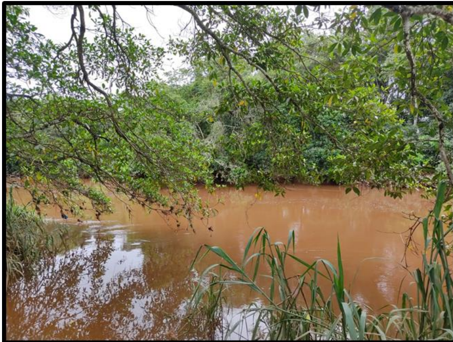
Figura 3.56. Ponto de Lançamento Final do Emissário.
