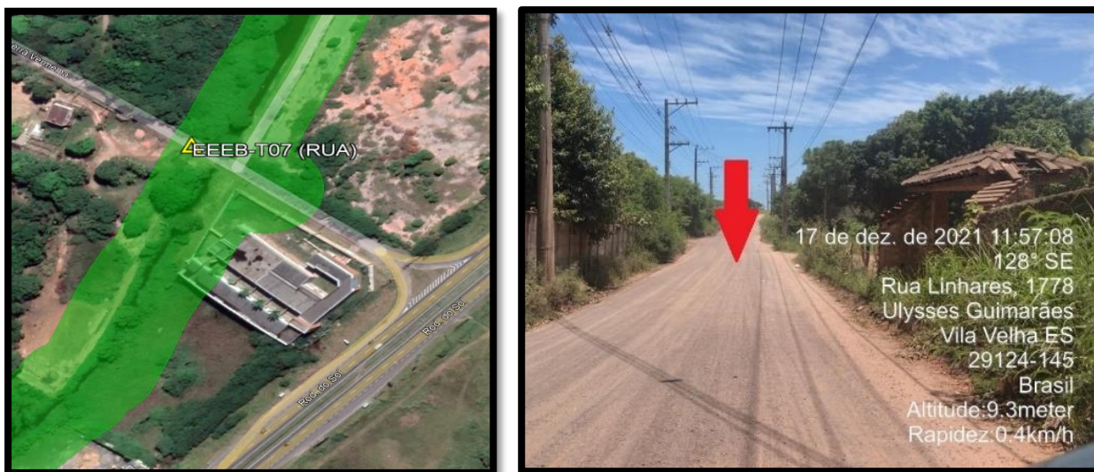
Figura 3.27. Localização da estação elevatória EEEB-T07.
