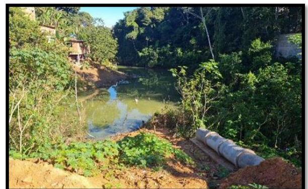
Figura 1.10. Lagoa represada é responsável por receber demanda de esgoto e águas pluviais.
