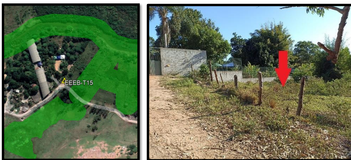
Figura 3.35. Localização da estação elevatória EEEB-T15.
