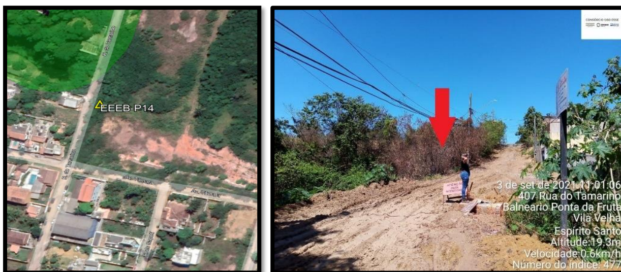
Figura 3.17. Localização da estação elevatória EEEB-P14.
