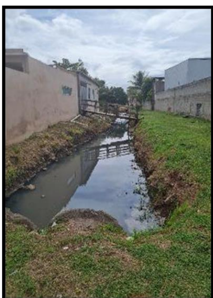
Figura 1.15. Acesso de moradias com transposição a vala de esgoto e canal de esgoto a céu aberto (Avenida Santa Leopoldina)
