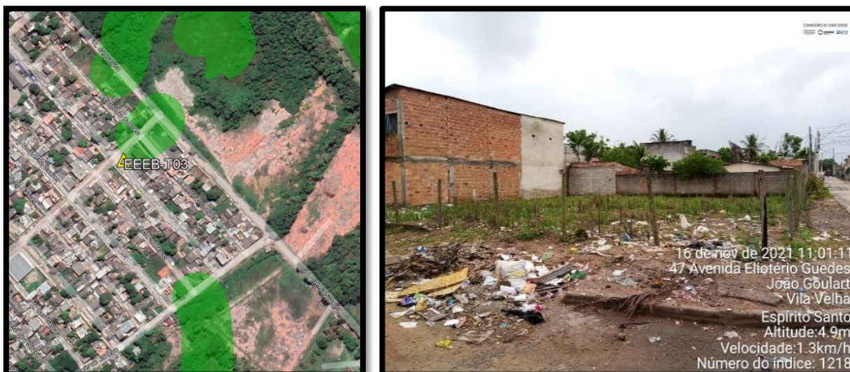
Figura 3.23. Localização da estação elevatória EEEB-T03.
