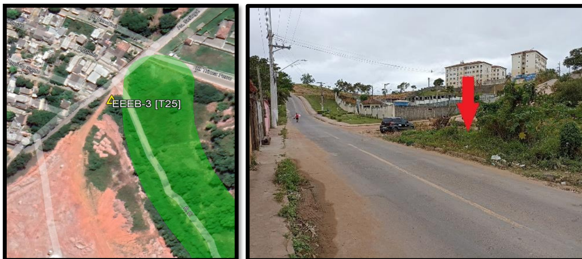
Figura 3.44. Localização da estação elevatória EEEB-3 (EEEE-T25).
