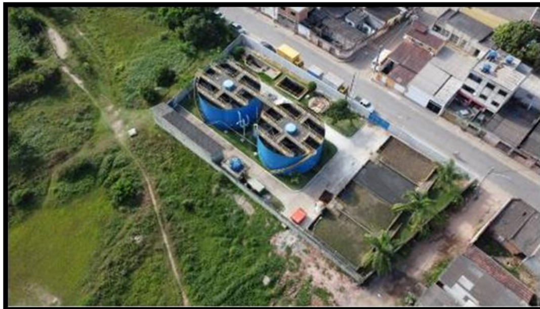
Figura 3.2. Vista da ETE Ulisses Guimarães existente, a ser desativada.
