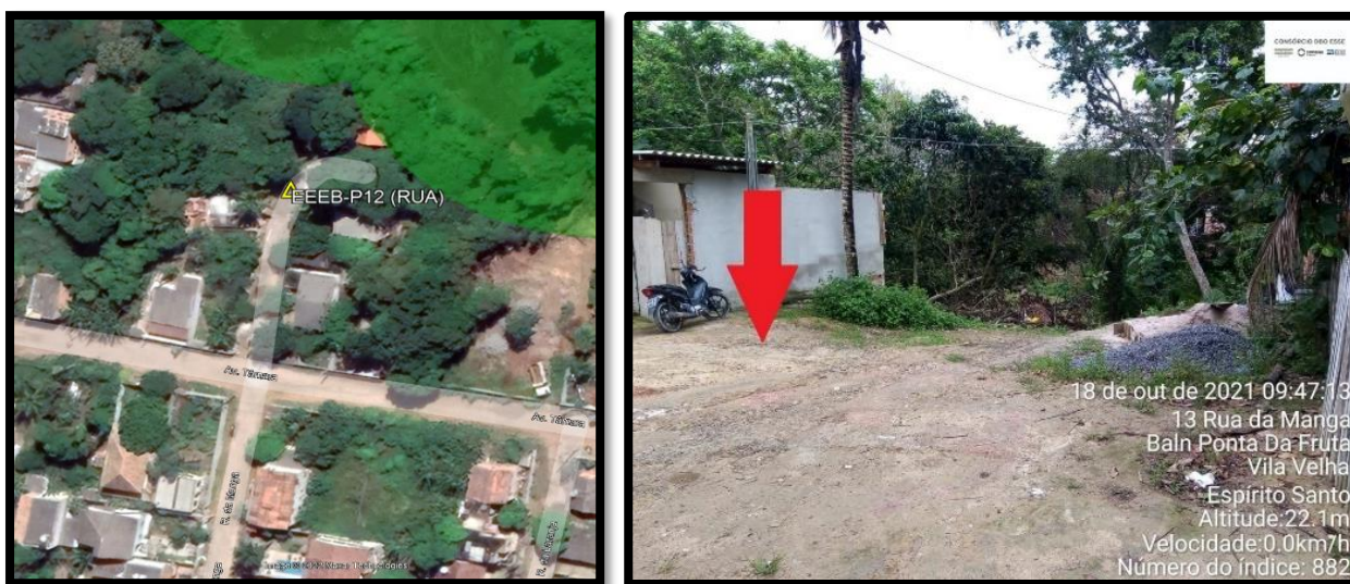
Figura 3.15. Localização da estação elevatória EEEB-P12.
