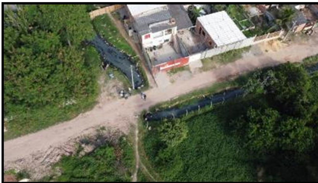
Figura 1.16. Escoamento de esgoto canalizado no entorno da ETE Ulisses Guimarães (Avenida Santa Leopoldina).
