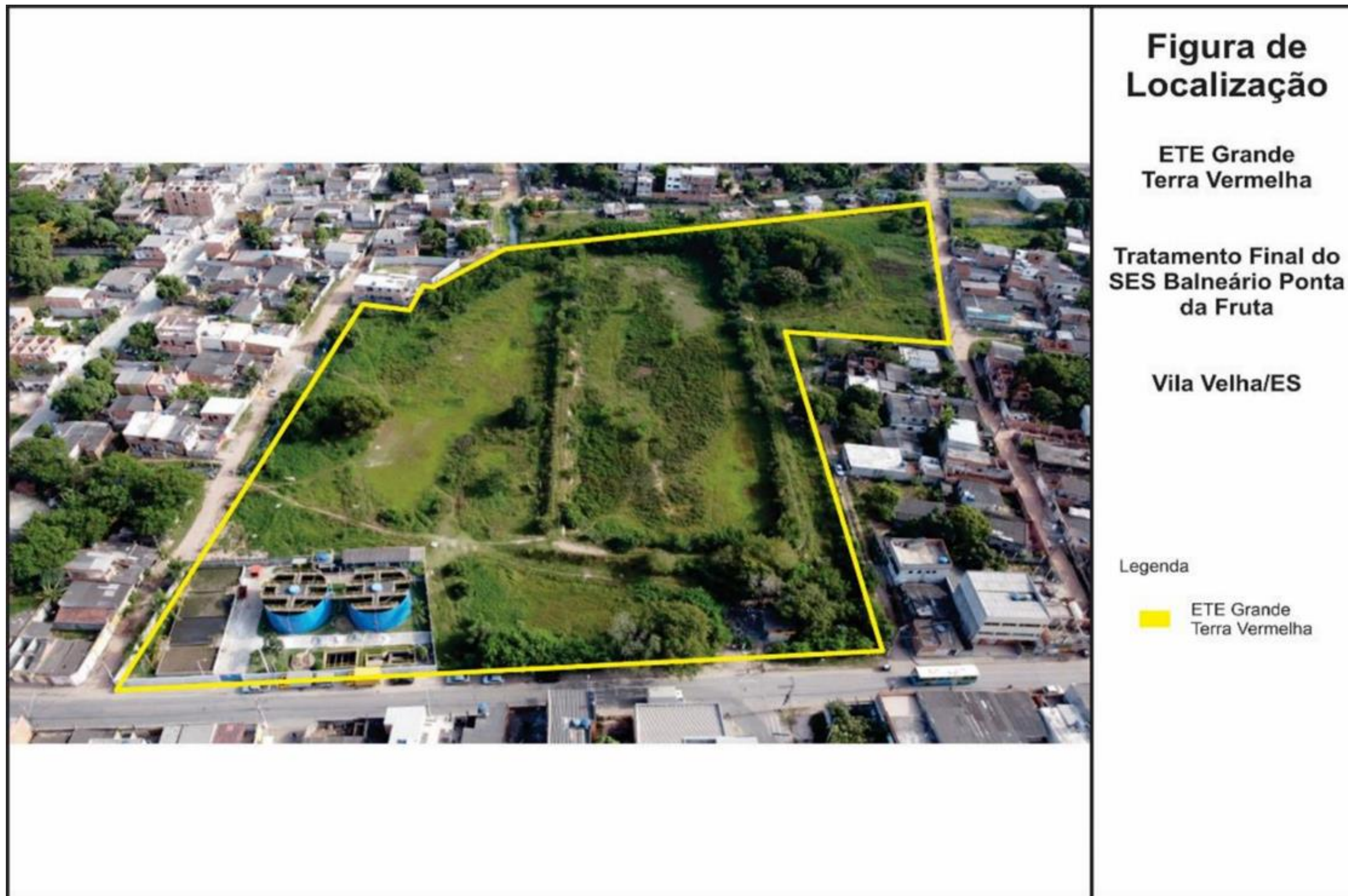
Figura 3.3. Vista da área de Implantação da ETE Grande Terra Vermelha.
