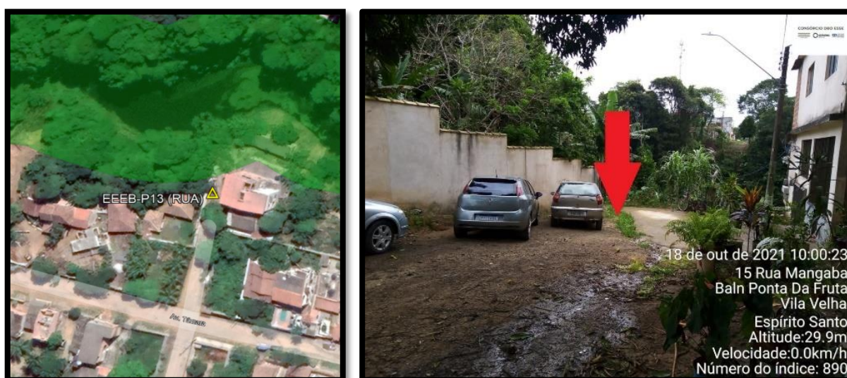
Figura 3.16. Localização da estação elevatória EEEB-P13.
