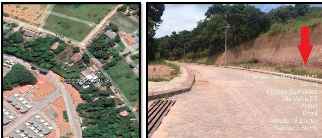
Figura 3.29. Localização da estação elevatória EEEB-T09.
