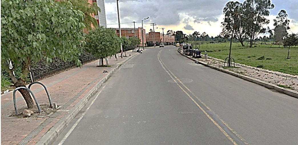
Fotografía 2. Situación actual diagonal 151 Fuente: UT MOVIUS 2022
