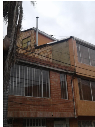
Fotografía 5. Fachada vivienda Fuente: UT Movius, 2022
