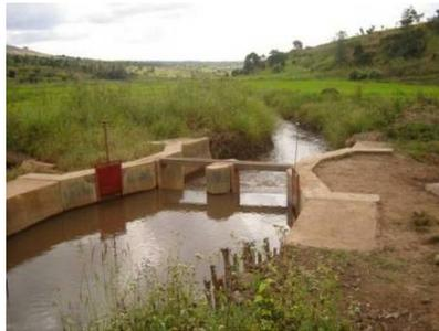
Barrage avec 2 prises et seuil avec batardeaux. C'est ce genre d'ouvrage qui est souvent placé dans des cours d'eau à faible débit et qui ne connaissent pas de dégâts de crue.
