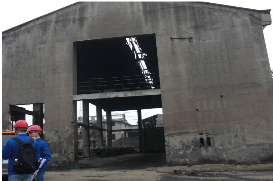
图片 6-3 鑫达冶化需要拆除的建筑物
