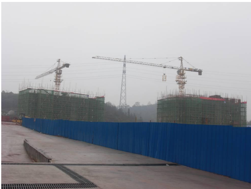
图片 6-2 正在建设中的霞湾新村安置房二期
