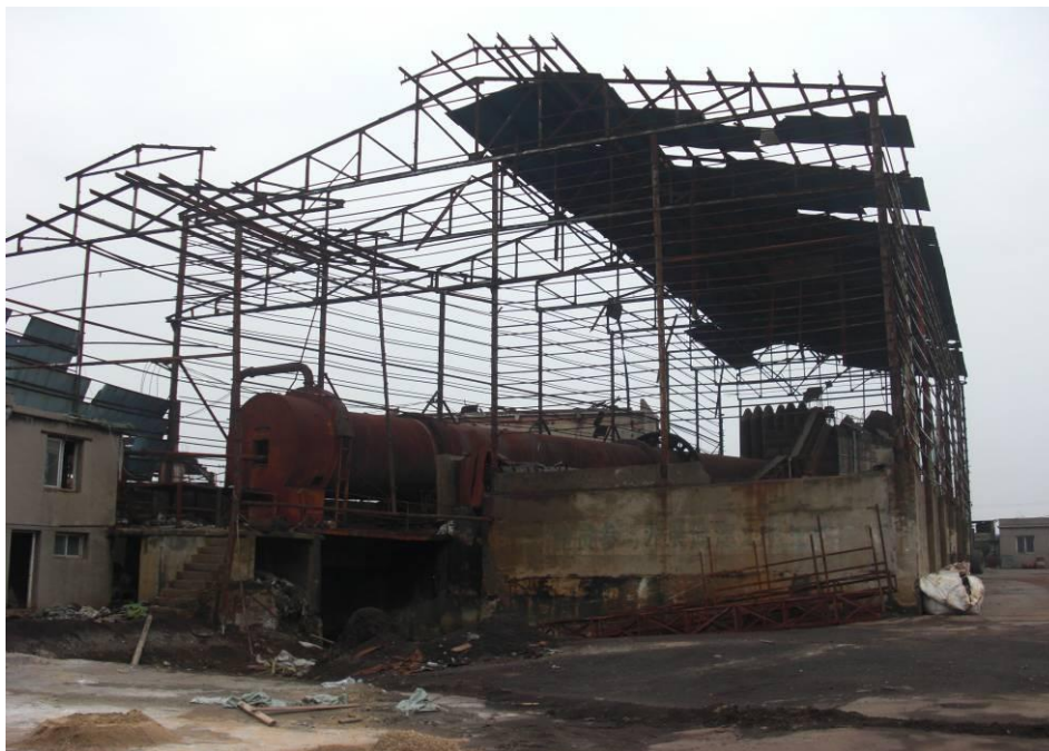
图片 6-1 永发提炼需要拆除的建筑物
