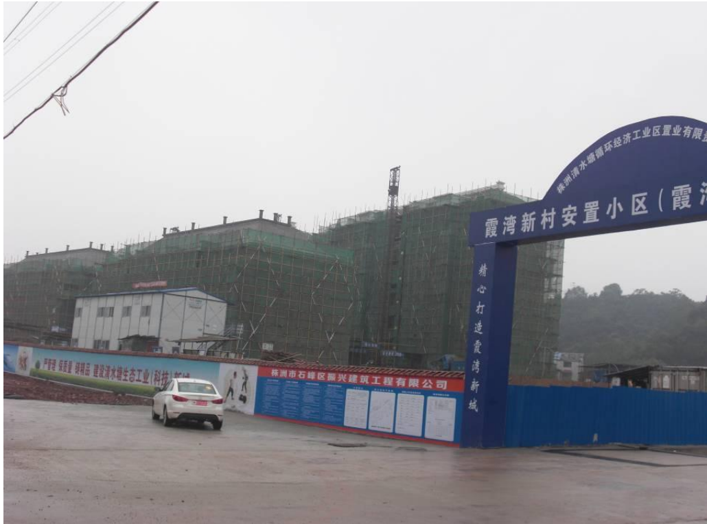
图片 6-1 霞湾新村一期安置房已经封顶
