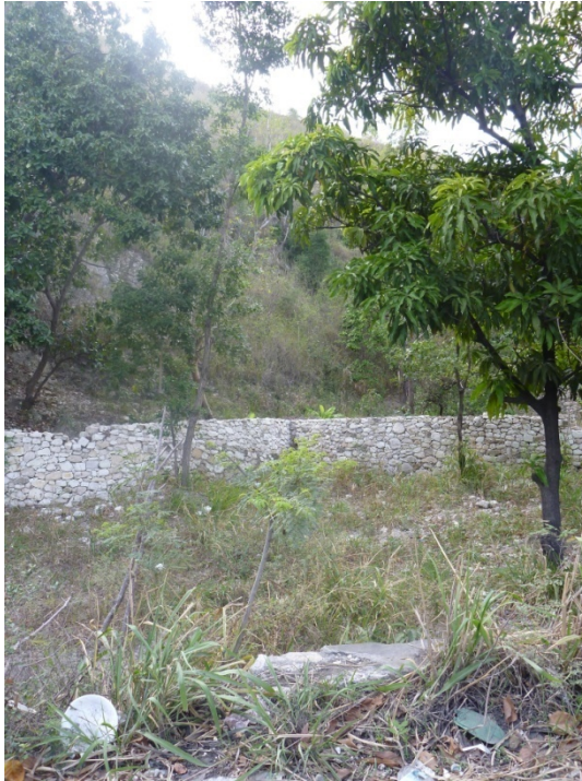
Photo 4-1 Ouvrage de retenue à la tête du bassin versant sud
