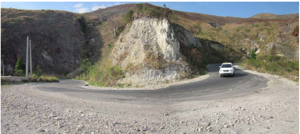
Photo 2-1 Section de route avec courbes multiples – versant sud de le morne de Puilboreau – Pk 3+075
