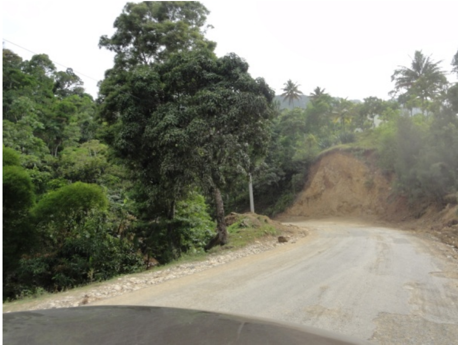
Photo 2-6 Talus non stabilisé en bordure de la route
