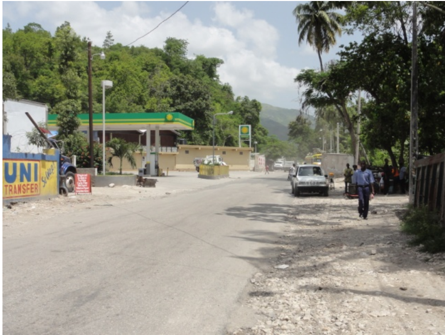
Photo 2-4 Route existante – secteur Ennery
