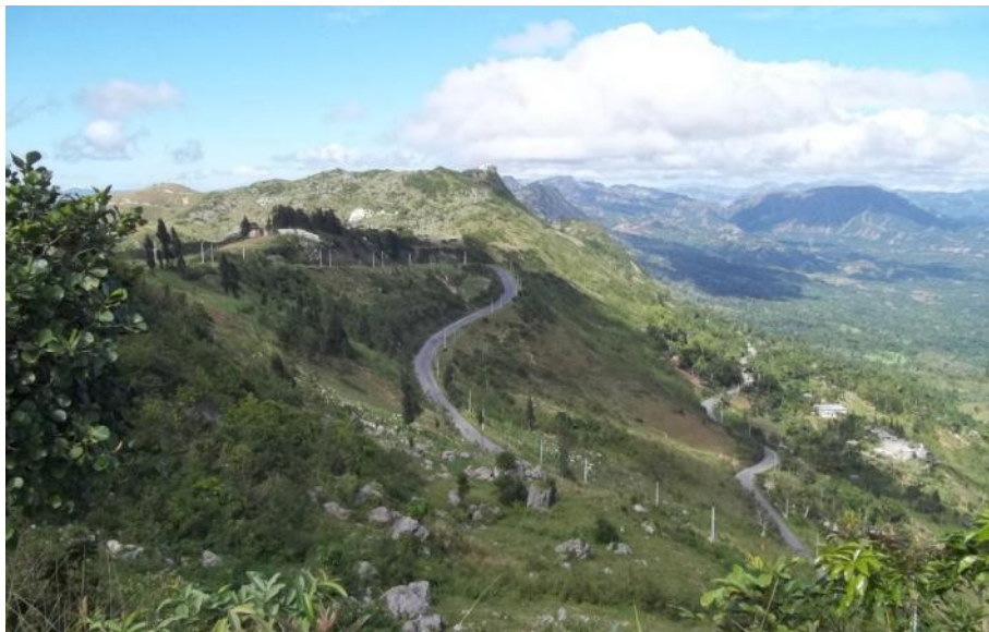
Photo 2-3 Section de route en lacet – versant nord de le morne de Puilboreau – Pk 10+100
