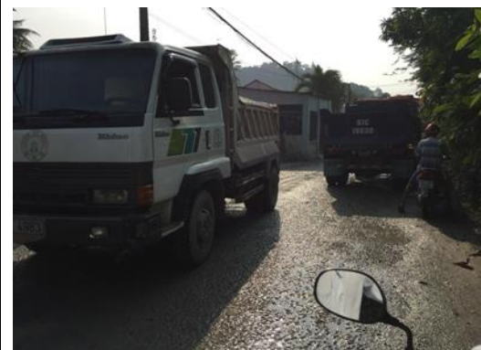
Tưới nước đường vận chuyển
