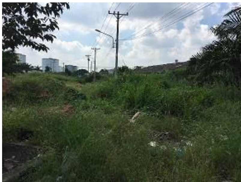
Hình 5. 1. Đường dây điện trên khu vực trạm bơm G1-1
