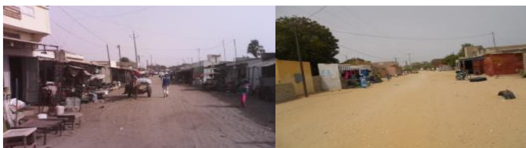
Photo 20 : Occupations diverses sur l'emprise des travaux
