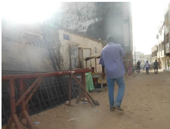
Photo 18 : Soudeur mécanique sur rue
