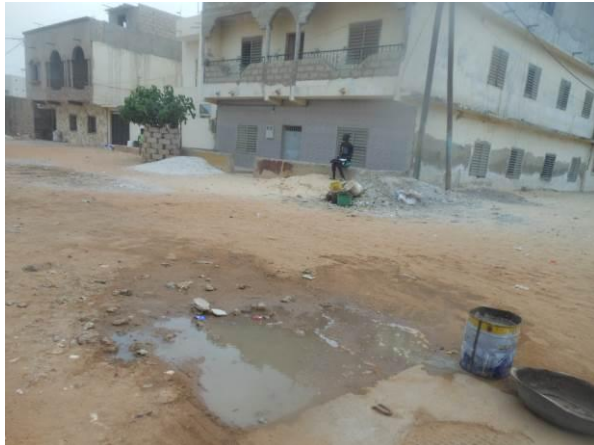
Photo 21 : Déversement d'eau usée
