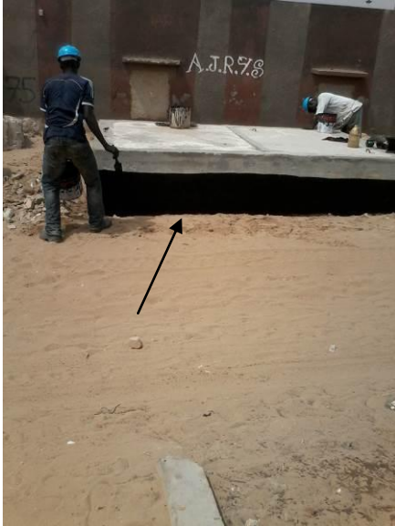
Photo 31 : Un des ouvrages SADE sur axe
