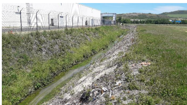
Fossé de drainage
