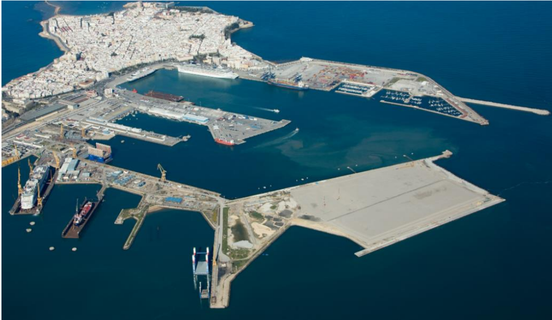
Imagen 3: Primera fase de la NTC ya ejecutada. Fuente: APBC
