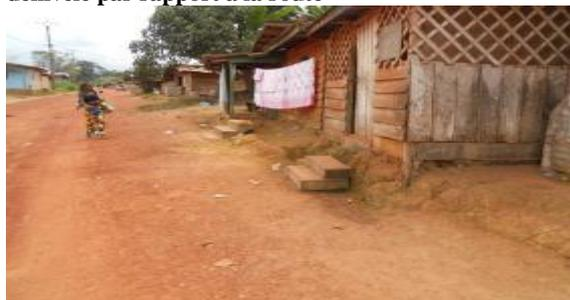
**Photo 17 : Rampe de franchissement sur un caniveau à ciel ouvert**
