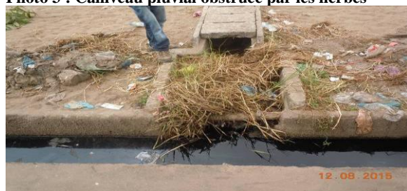
Photo 3 : Caniveau pluvial obstruée par les herbes
