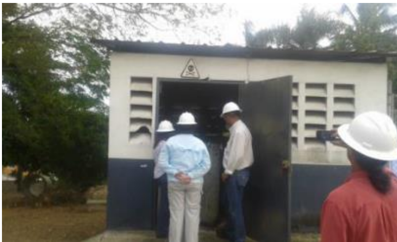
Figura 48 Punto Verde en Subestación Km 10 ½ de la Autopista Duarte, en EDESUR.
