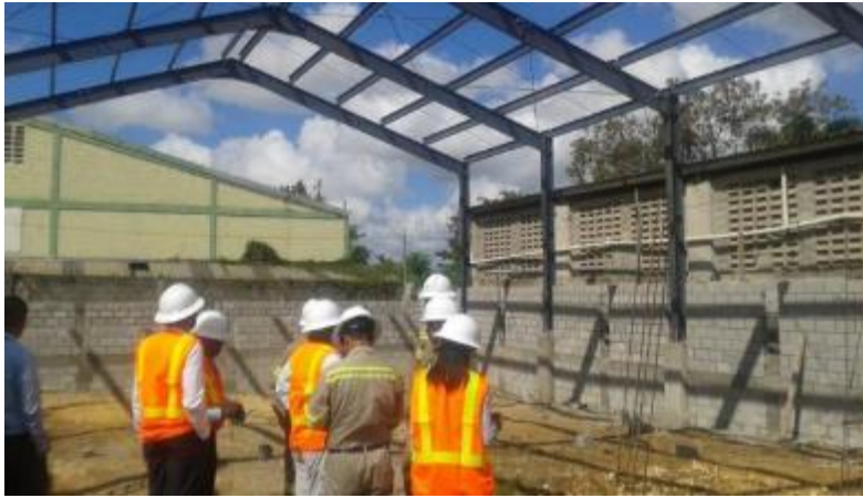
Figura 51. Construcción /adecuación del Taller en Hainamosa, EDEESTE..
