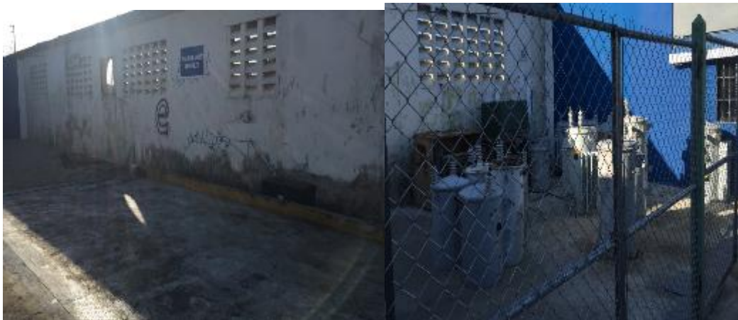
Figura 53. Área donde se colocan transformadores en tránsito, reparación o chatarra, en EDEESTE.
