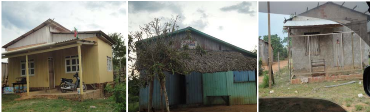
Figura 2.33: Viviendas: prefabricada (izq), techo duralit (centro), de hormigón (der) Fuente: Plan de Reasentamiento Involuntario de familias y actividades económicas (PRI) (García, Julio 2012)
