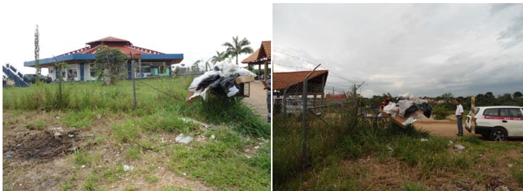
Figura 2.25: Contenedor en el sector frontal (de ingreso) de la terminal de pasajeros
