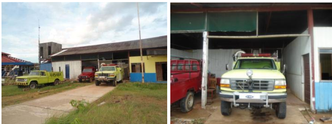
Figura 2.9: Vista frontal instalaciones SEI
