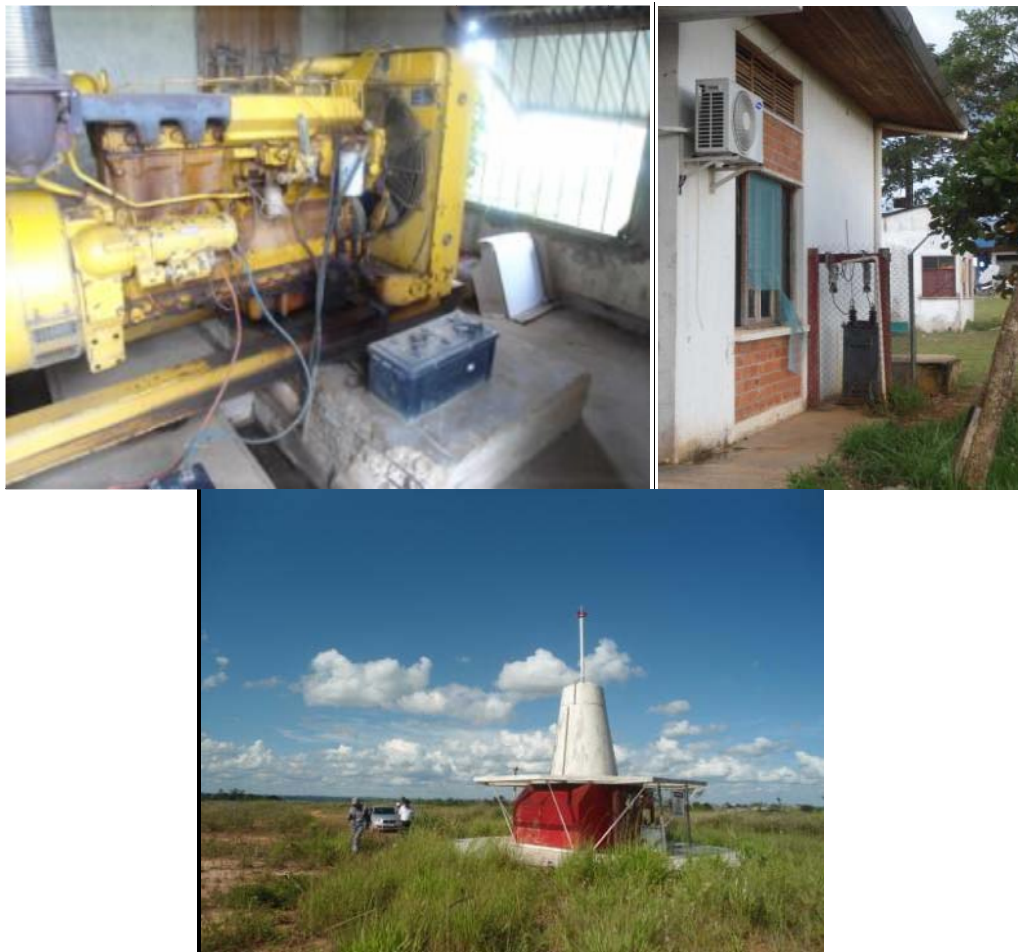
Figura 2.19: Superior: Grupo electrógeno (izq). Transformador (der). Inferior: Transformador del VOR
