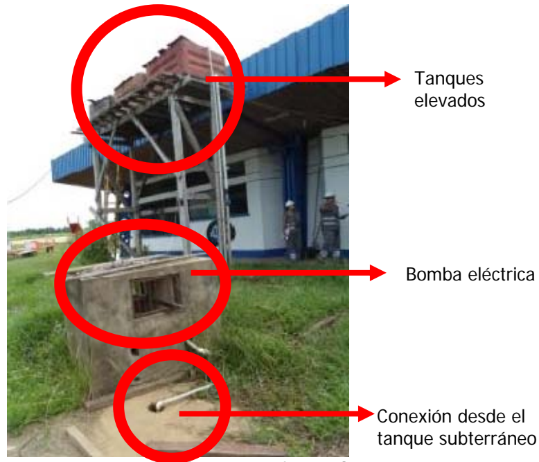
Figura 2.21: Tanques de almacenamiento de agua
