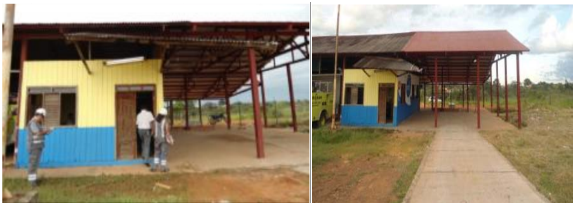
Figura 2.11: Vista frontal de oficinas de aduana y ZOFRA Cobija
