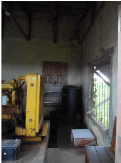
Figura 2.10: Turril metálico para almacenamiento de combustible para equipo electrógeno
