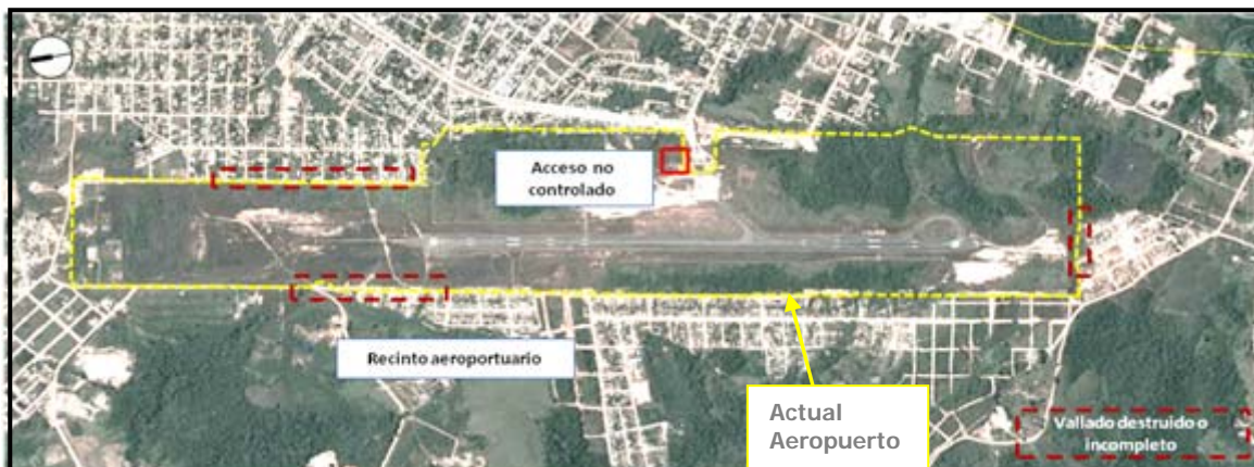
Figura 2.17: Cerco Perimetral del Aeropuerto de Cobija
