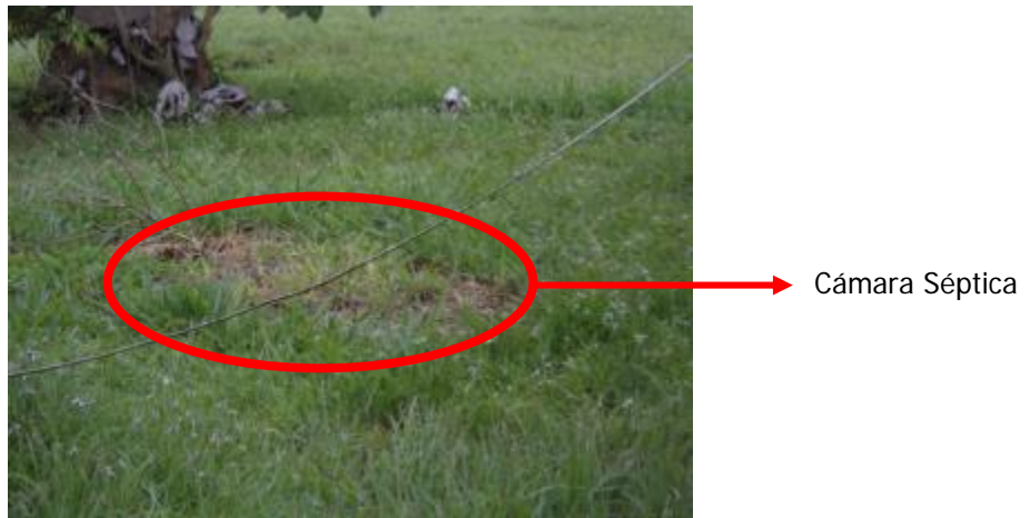
Figura 2.23: Cámara séptica del edificio de la actual terminal
