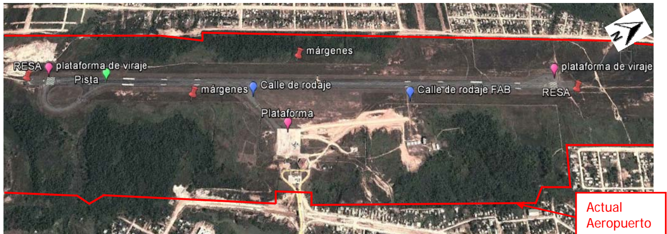
Figura 2.3: Distribución LADO AIRE del Aeropuerto Cap. Anibal Arab Fadul Fuente: SIMBIOSIS S.R.L., elaborado en base a imágenes de Google Earth, 2011.
