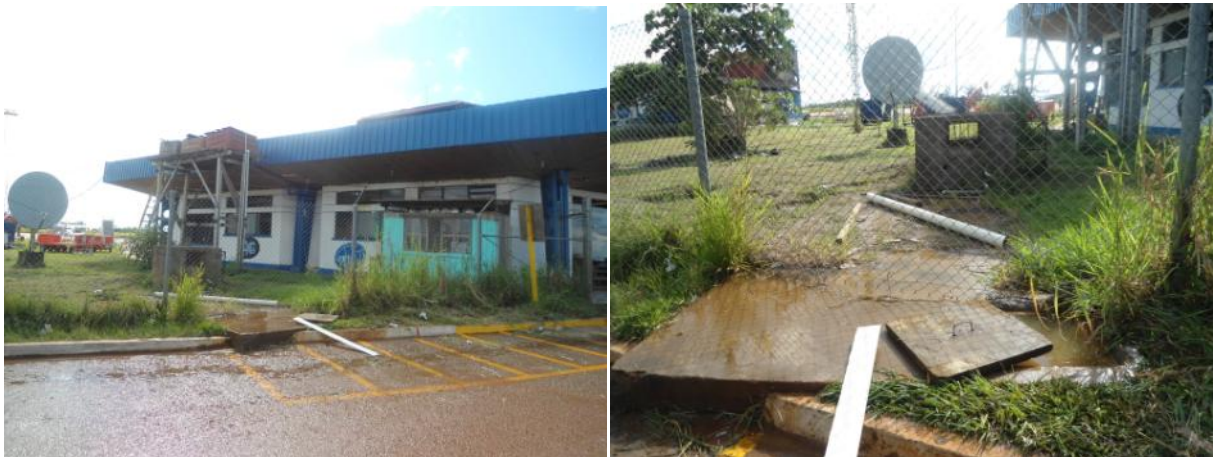
Figura 2.20: Tanque principal de almacenamiento de agua. Ubicación (izq). Tanque destapado (der)
