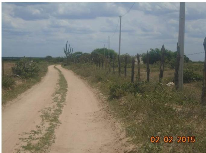
**Foto 6.113** – Via de acesso para a sede da localidade de Serra da Barrinha estruturada com revestimento primário.
