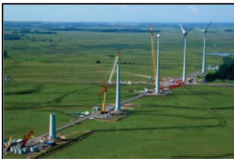
Figura 4.4 – Montagem dos Aerogeradores
