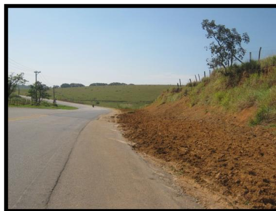
**Foto 4:** Km 114+000 - Interferências na faixa de domínio decorrentes das obras da implantação da adutora de gás natural, realizadas na região.
