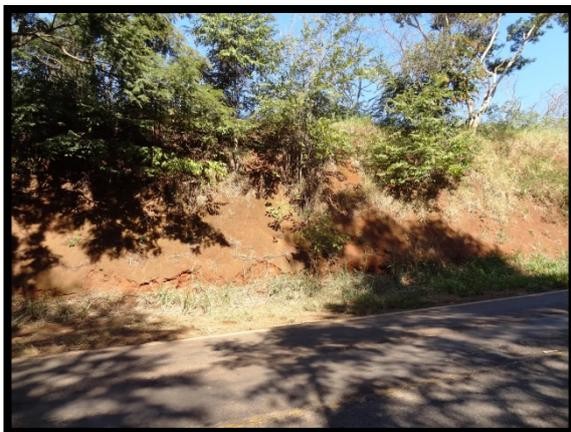
**Foto 1:** Km 641+410- LE Detalhe para deflagração do processo erosivo no talude de corte.
