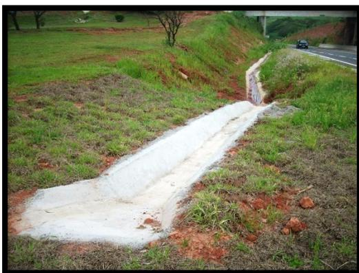
**SP – 294:** Dispositivo de drenagem superficial e cobertura vegetal no entorno para proteção do solo.
