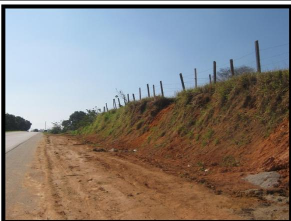
**Foto 1:** Km 114+800 Registro de Erosões e Falhas na cobertura vegetal no talude de corte, dentro da faixa de domínio.
