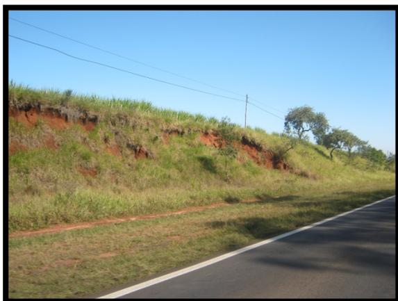
**Foto 1:** Km 10+000 - Detalhe para a deflagração de processos erosivos e deficiência da cobertura vegetal no talude de corte.
