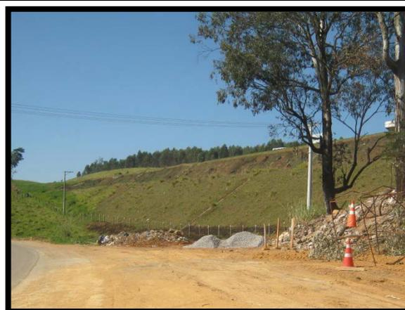
**Foto 2:** Km 114+200 Presença de Resíduos Classe IIA (Não Inertes) e IIB (Inertes) na faixa de domínio provenientes das obras de implantação da adutora de gás natural, realizadas na região
