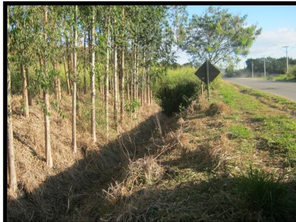
**Foto 2:** Registro do dispositivo de drenagem existente (canal a céu aberto).
