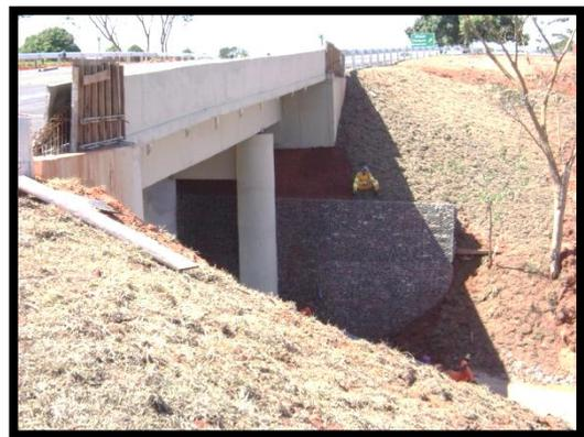
**SP – 294:** Detalhe do muro de gabião, com proteção superficial do solo com gramíneas das áreas adjacentes da OAE.
