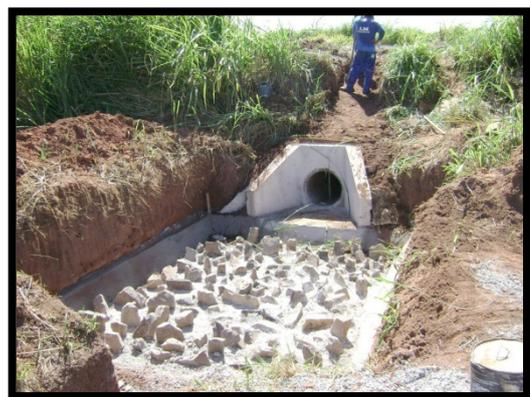
**SP – 294:** Detalhe do dissipador de energia a jusante do dispositivo de drenagem (ala de galeria).
