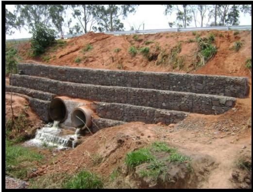
**SP – 294:** Dispositivo de contenção geotécnica, visando a proteção do recurso hídrico.
