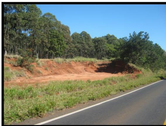
**Foto 2:** Km 14+900 - Registro de suposta área de empréstimo, não devidamente reconformada, caracterizando atualmente um passivo.
