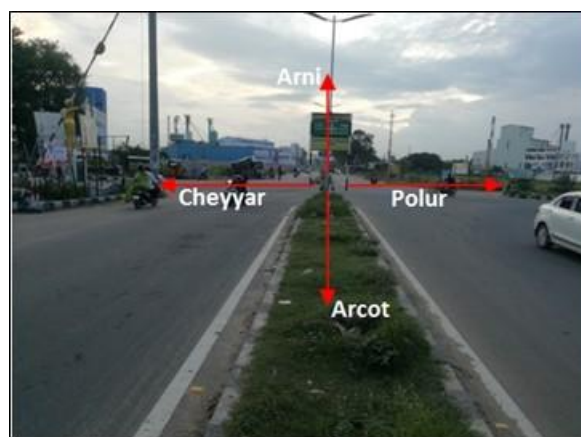
The endpoint of SH 04 (km 24/800)
