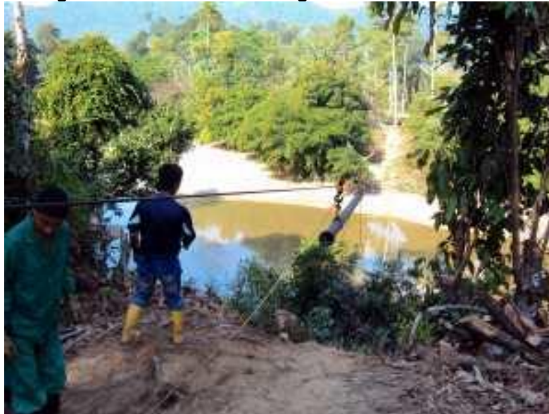
Fotografía 2-1 Acueducto Corregimiento La Fortuna
