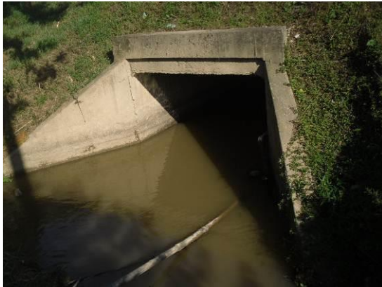
Fotografía 2-3 Cruce de red de acueducto
