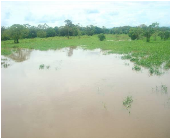
Tramo 2 – Ruta 4510 – PR 85 + 700 Zona Inundada - Vista hacia aguas arriba
