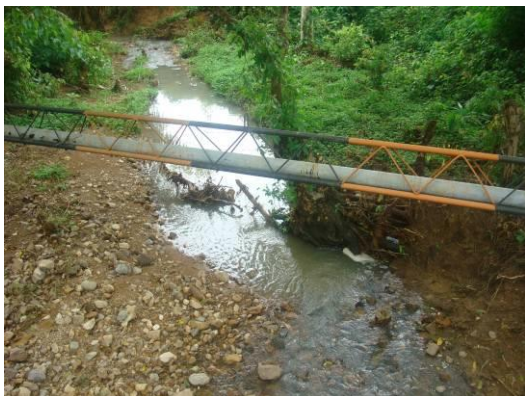
Tramo 7 - Ruta 4515 PR 34+0400 Tubería de 6" de TELECOM
