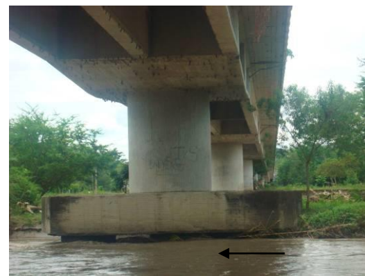
Infraestructura del puente
