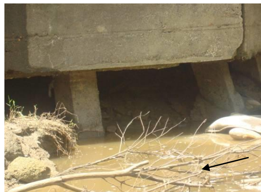
Socavación local – Estribo margen derecha
