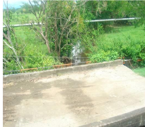
Tramo 2 - Ruta 4510 PR 99+0900 Al fondo Tubería de 12" de ECOPETROL, Tubería de 6" de TELECOM y Puente Abandonado
