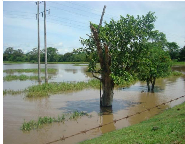
Tramo 2 – Ruta 4510 – PR 94 a PR 94+500 Zonas bajas inundadas sector dos y medio
