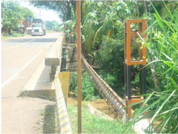
Tramo 2 - Ruta 4510 PR 93+0010 Tubería de 6" de TELECOM
