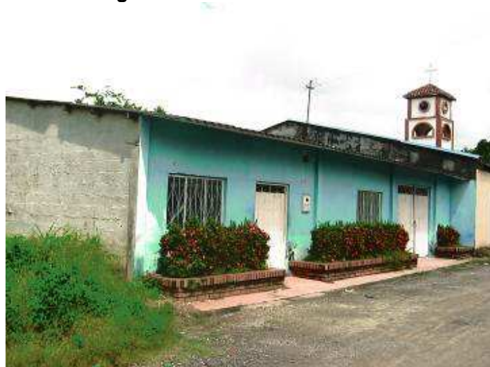
Fotografía 3-16 Puesto de salud Líbano
