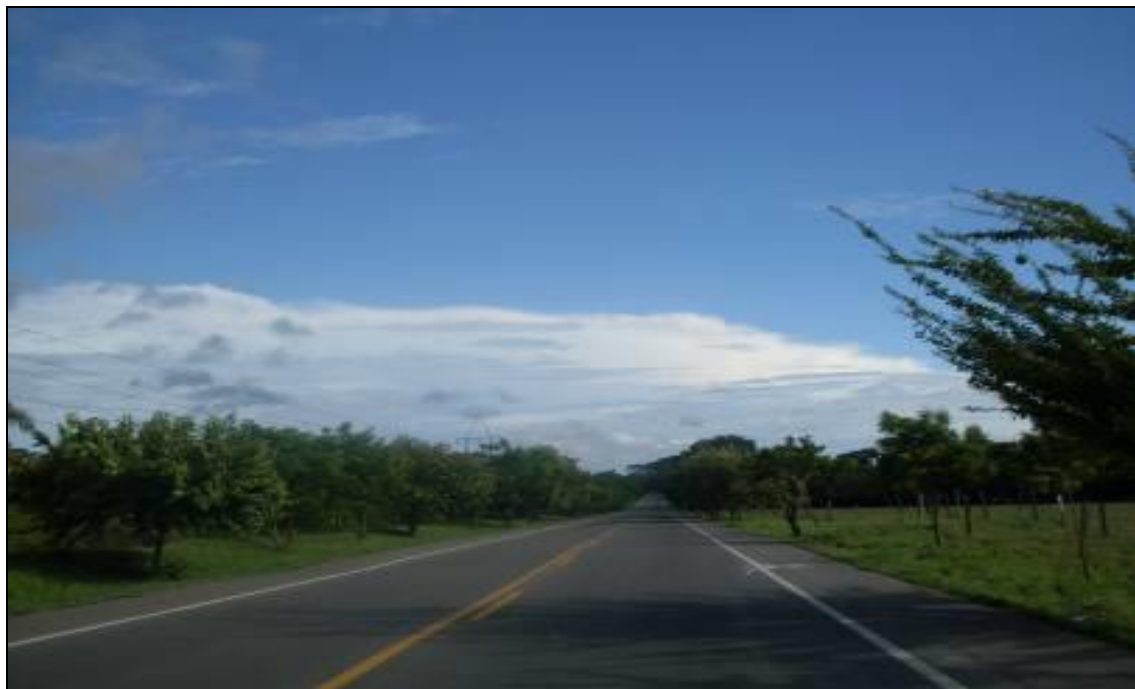
Fotografía 2-48 Estructuras de 34.5KV por el margen izquierda de la vía
