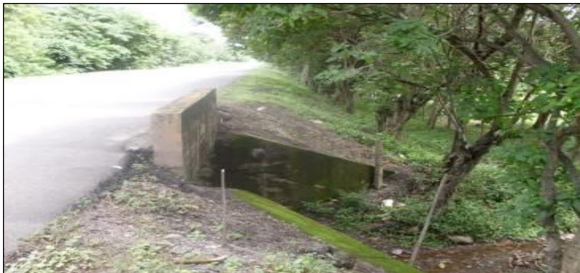
Fotografía 2-56 Drenaje de Vía
