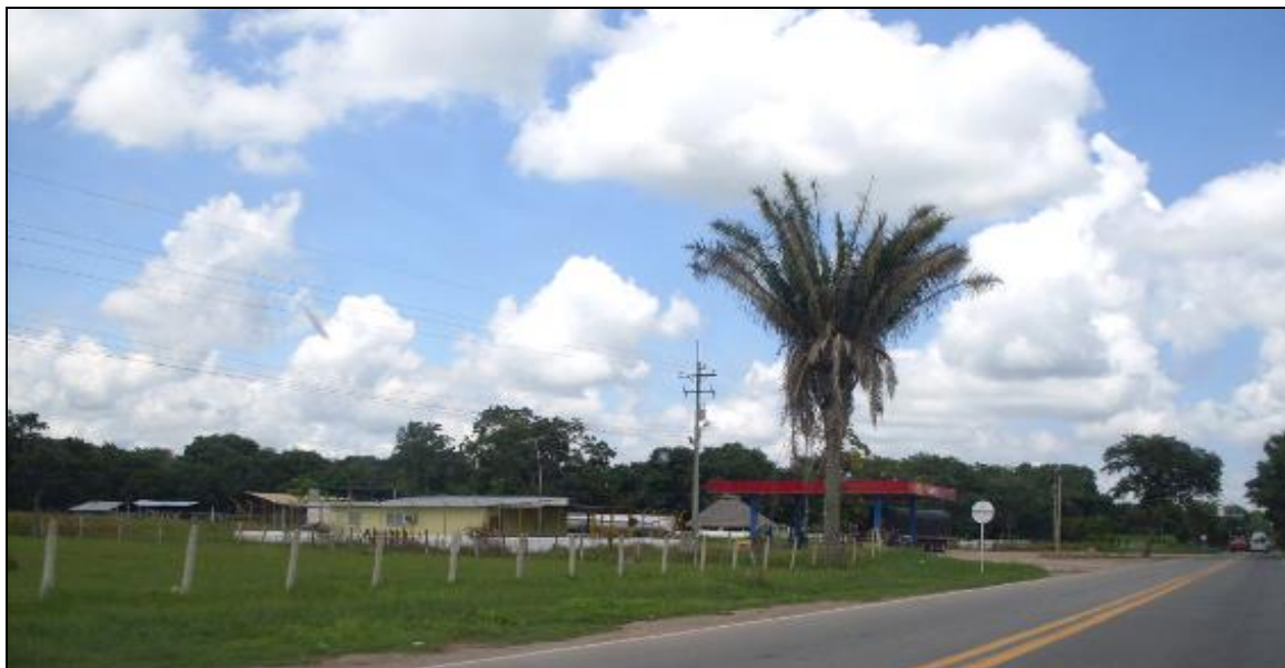
Fotografía 2-9 Estructura de Media Tensión con Circuito en Configuración Triangular con Derivación a Transformador (Margen Derecha)
