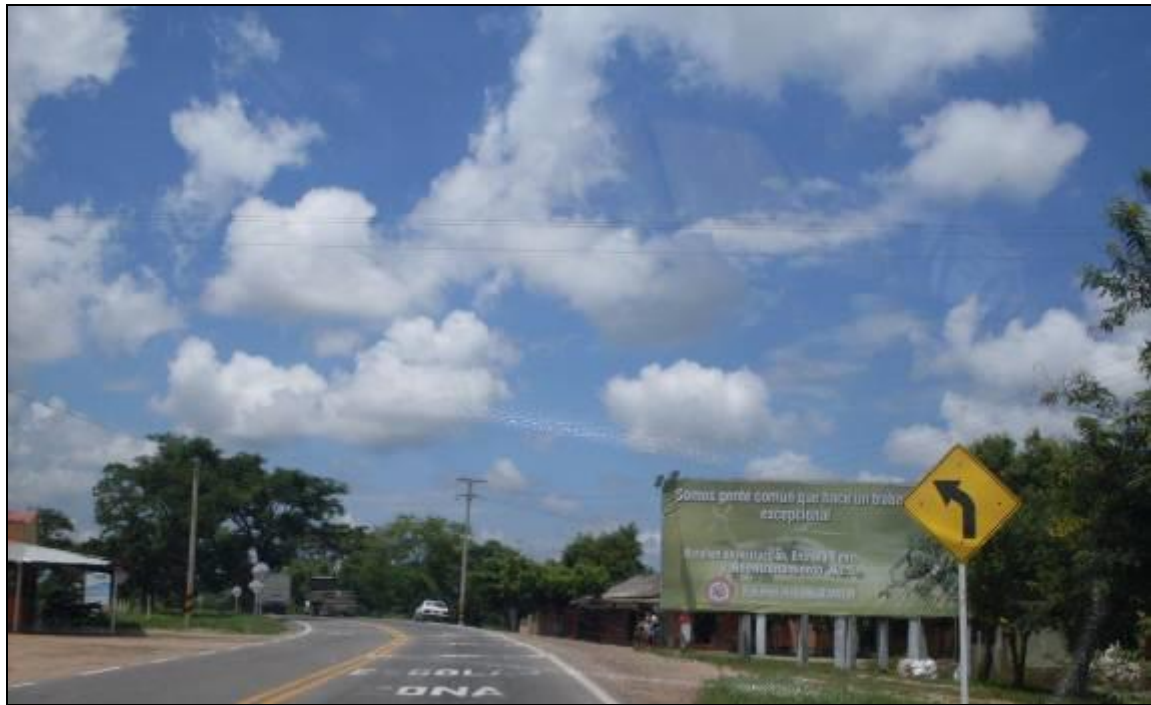
Fotografía 2-14 Cruce de Redes de Media Tensión Caserío El Juncal
