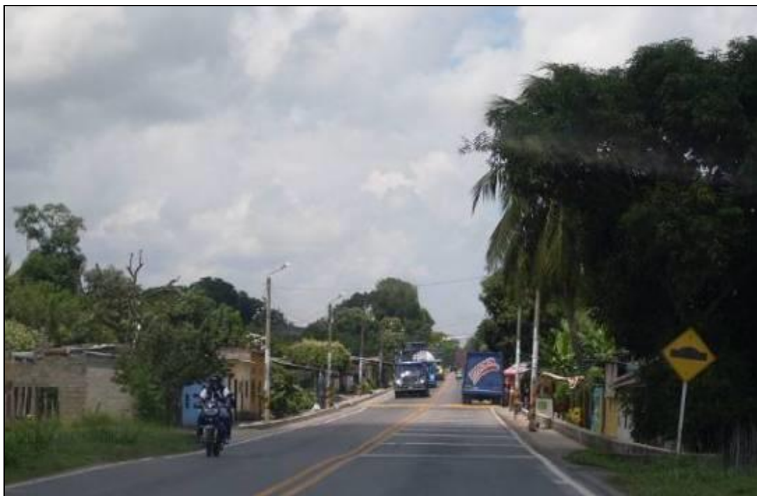
Fotografía 2-26 Infraestructura de Baja Tensión y Alumbrado Público en Entrada a San Martín
