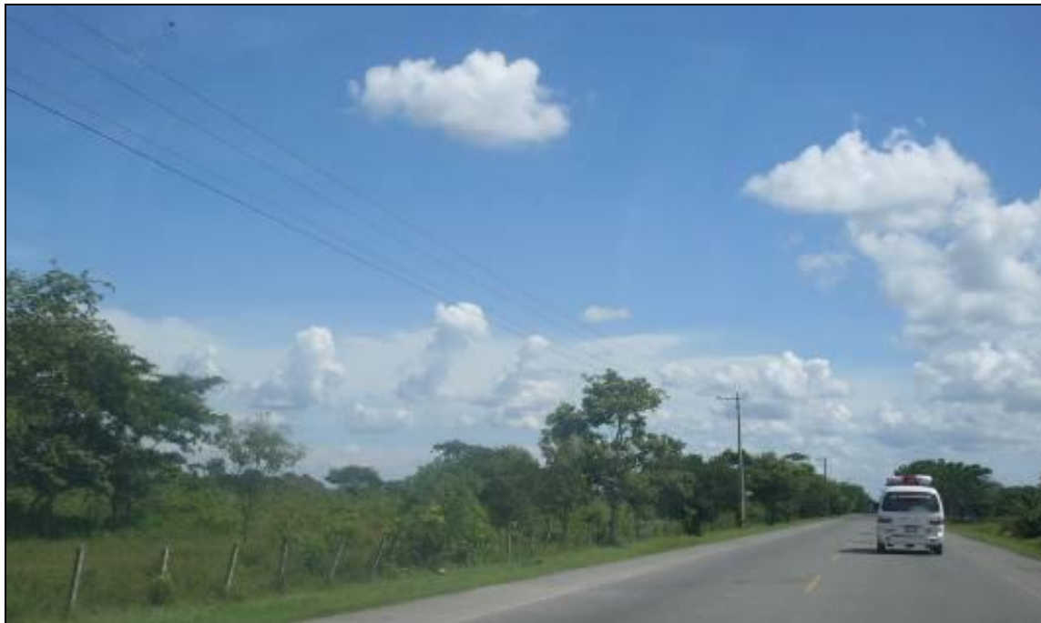
Fotografía 2-46 Estructuras con Circuito Sencillo de MT
