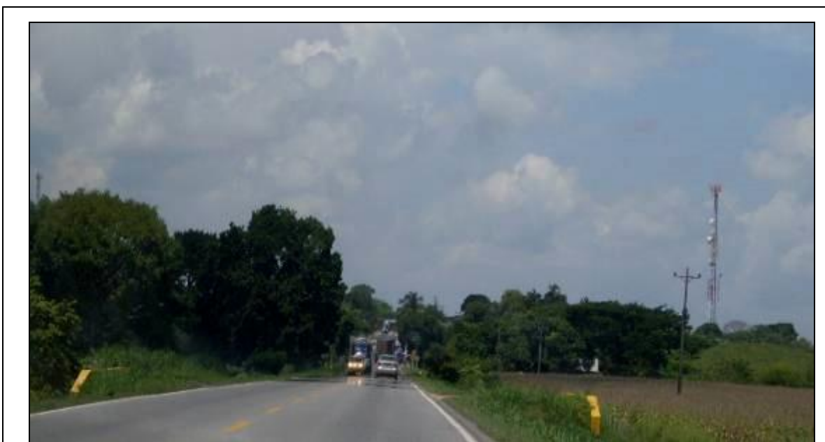
Fotografía 2-25 Infraestructura de Media Tensión y Torre de Telecomunicaciones (Margen izquierda)
