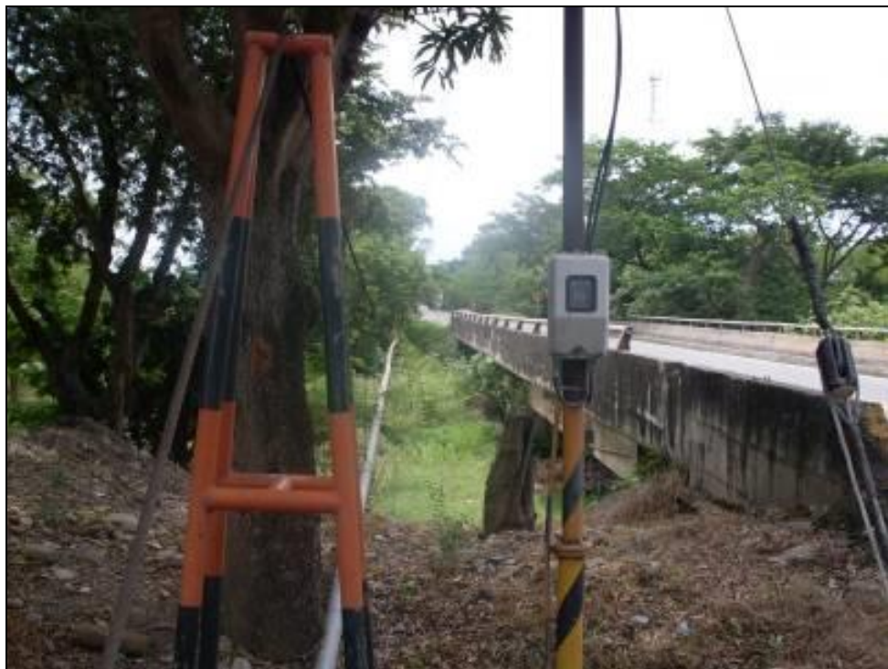
Fotografía 2-53 Estructura para paso de puente
