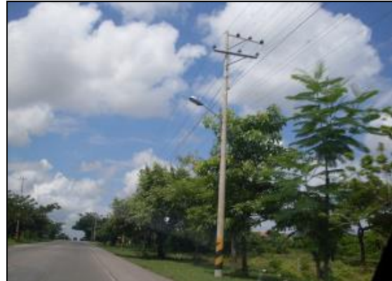
Fotografía 2-5 Estructuras de Redes de Media Tensión: Circuito Sencillo (Margen Derecha) y Circuito Doble + Alumbrado Público + Comunicaciones (Margen Izquierda)
