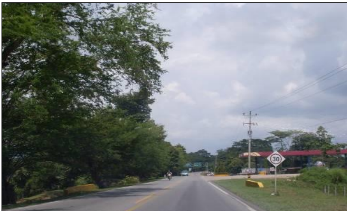
Fotografía 2-29 Infraestructura de Media Tensión con Derivación a Transformador (Margen Izquierda)
