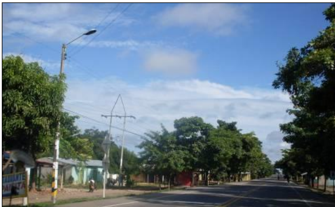
Fotografía 2-49 Estructuras de Media Tensión en casco urbano
