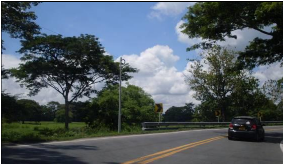
Fotografía 2-15 Infraestructura con Red de Comunicaciones y Reserva (Margen Derecha)
