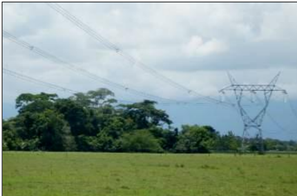
Fotografía 2-3 Cruce de Línea de Alta Tensión 500 KV Primavera-Ocaña-Copey-Bolívar
