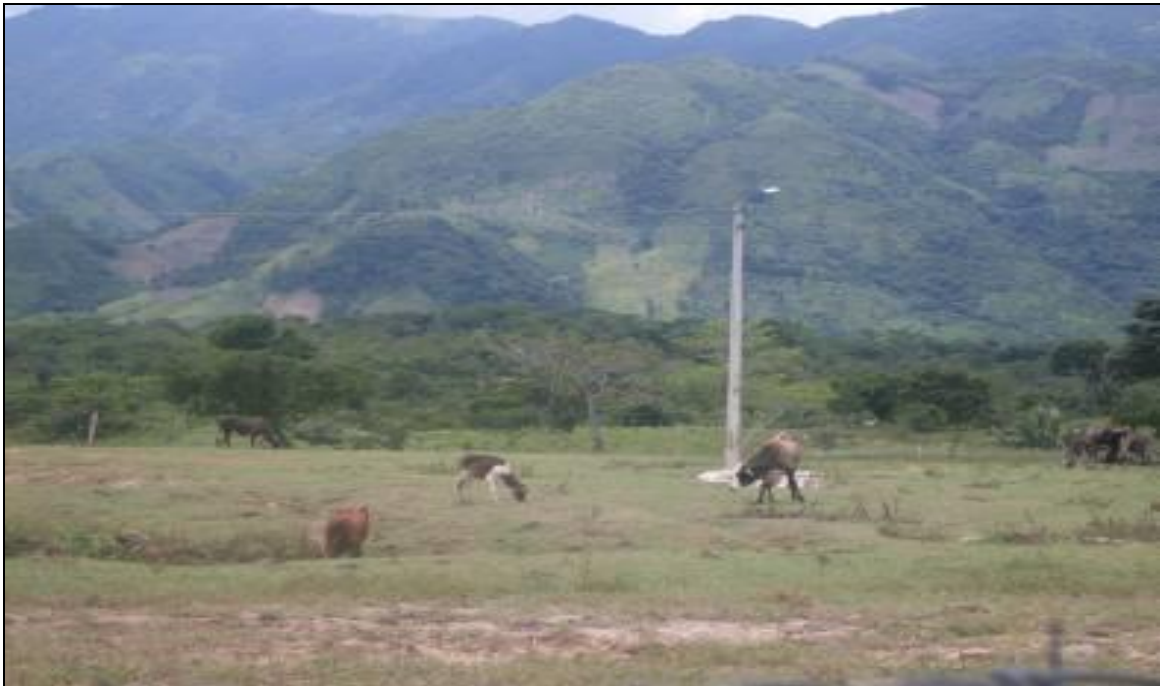
Fotografía 2-43 Estructuras con Alumbrado Público
