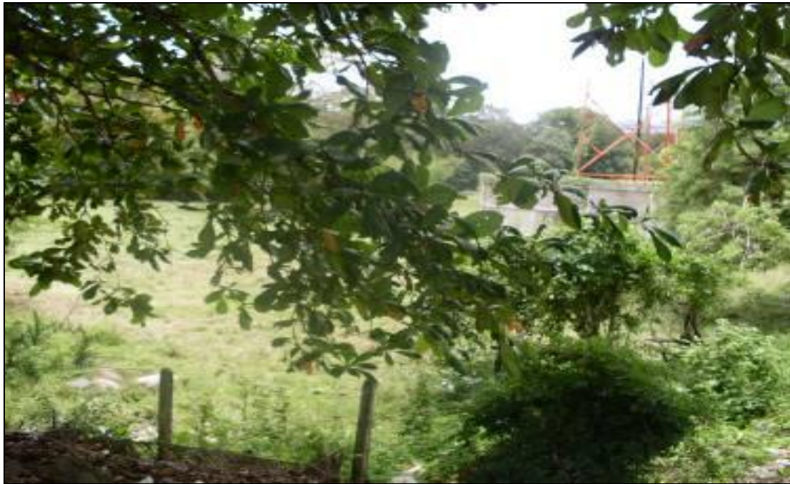
Fotografía 2-54 Antena de Telecomunicaciones
