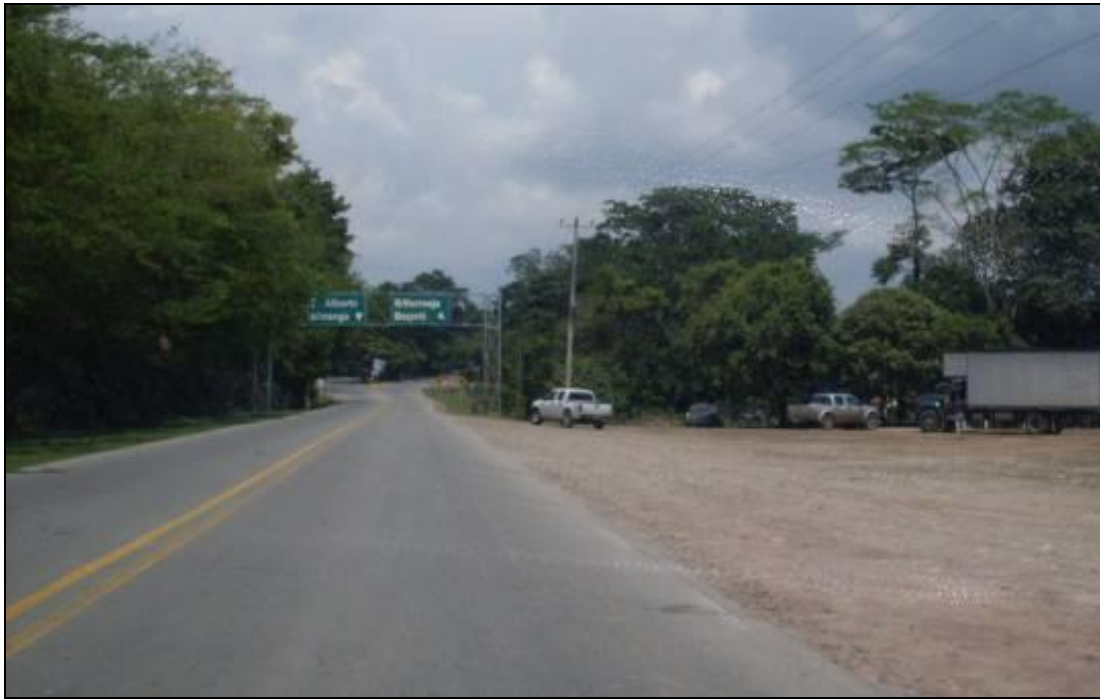
Fotografía 2-30 Infraestructura de Media Tensión en llegada a San Alberto (Margen Izquierda)
