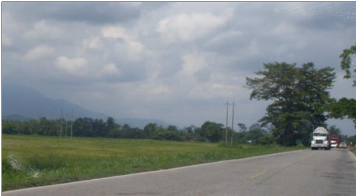
Fotografía 2-28 Infraestructura de Media Tensión en Cruce de Vía (Margen Derecha)
