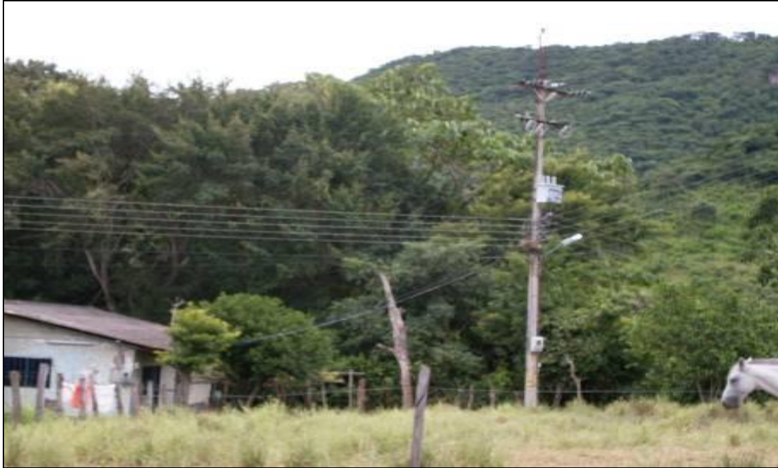
Fotografía 2-39 Estructura con Red de MT, BT y Transformador
