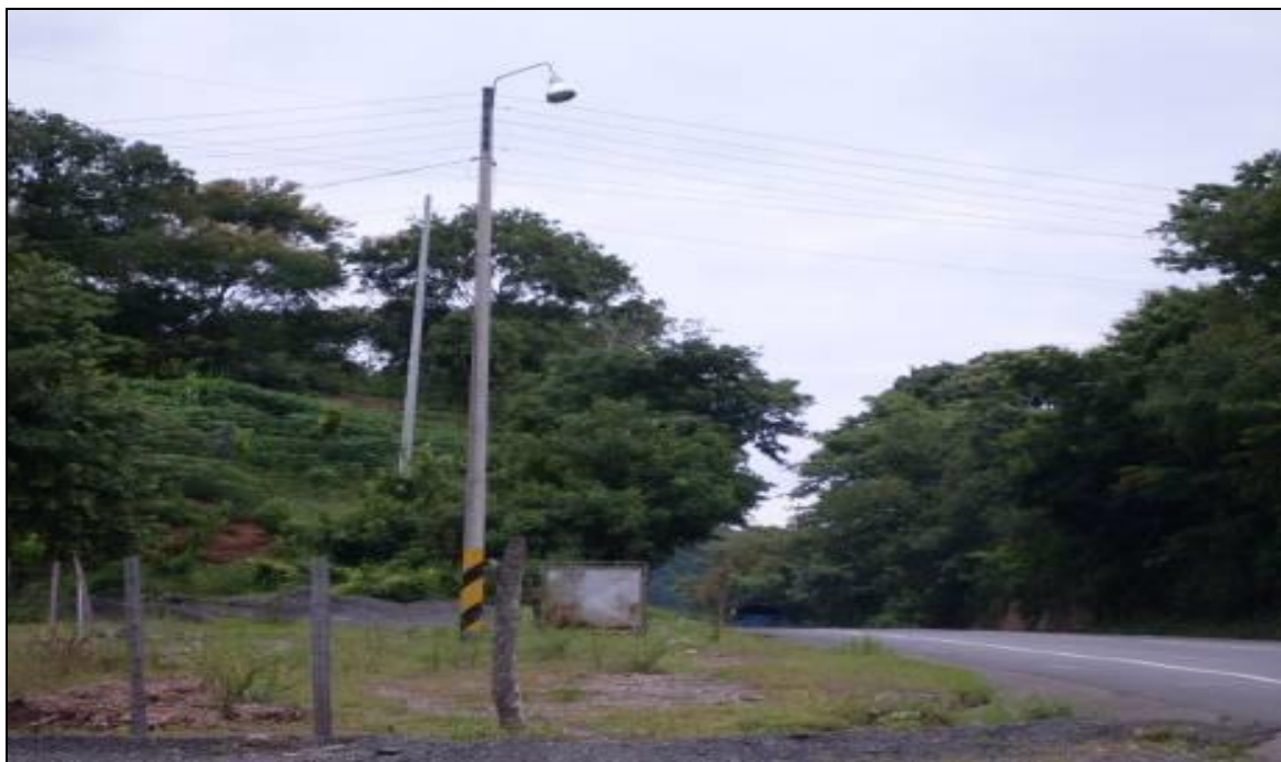
Fotografía 2-41 Estructuras con BT y Alumbrado Público
