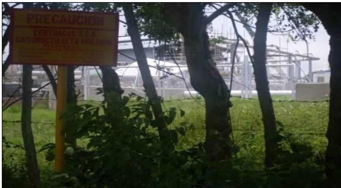
Fotografía 2-51 Estación Compresora de Gas Norean
