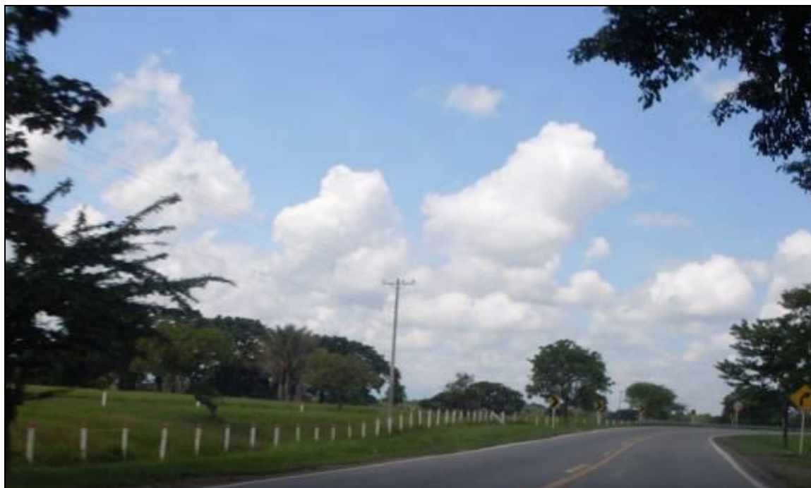
Fotografía 2-12 Estructura de Media Tensión con Circuito Sencillo (Margen Derecha
