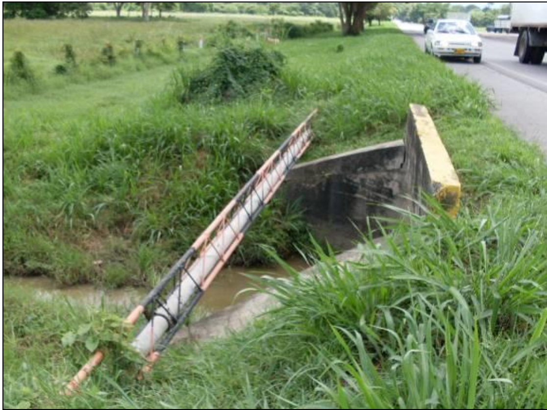
Fotografía 2-32 Estructura para Paso de Box Culvert
