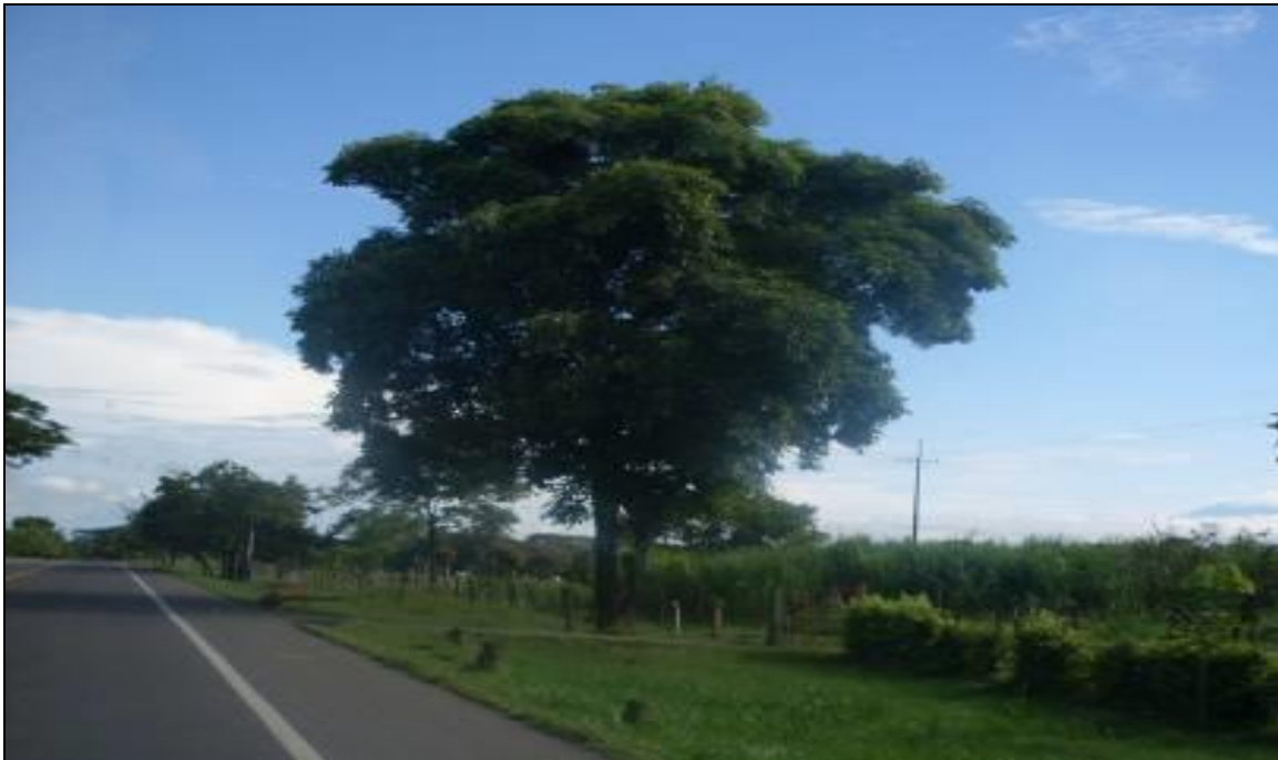
Fotografía 2-47 Estructuras de Media Tensión por el margen derecho de la vía
