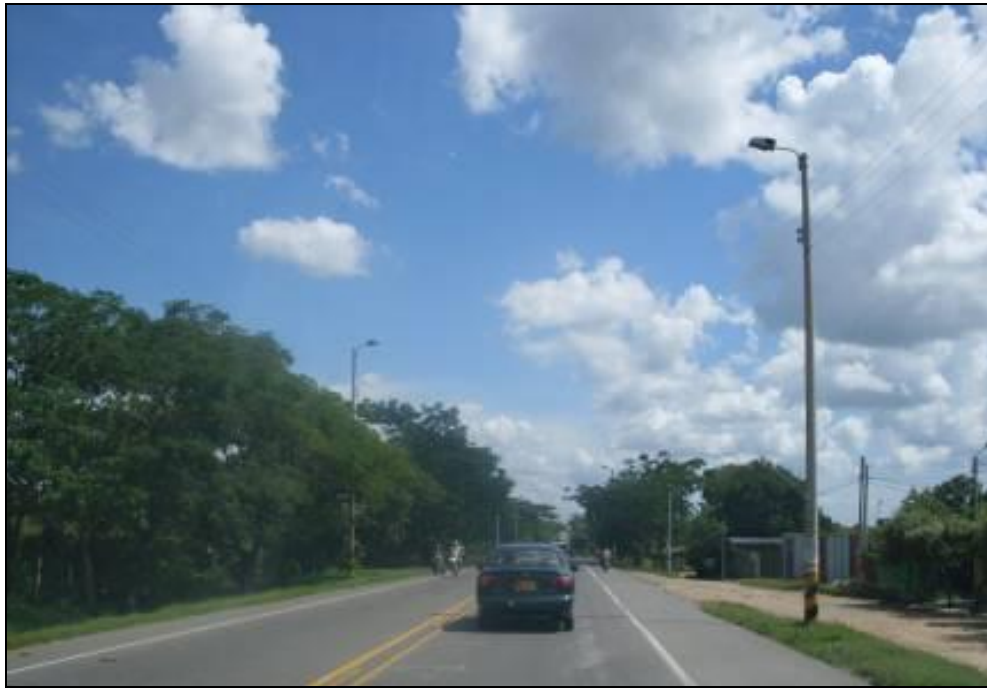
Fotografía 2-45 Estructuras con Alumbrado Público
