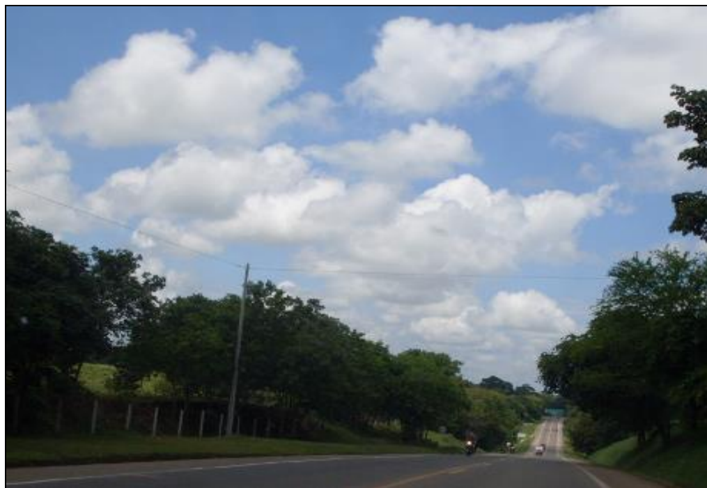
Fotografía 2-7 Poste con Redes de Comunicaciones (Margen Derecha)
