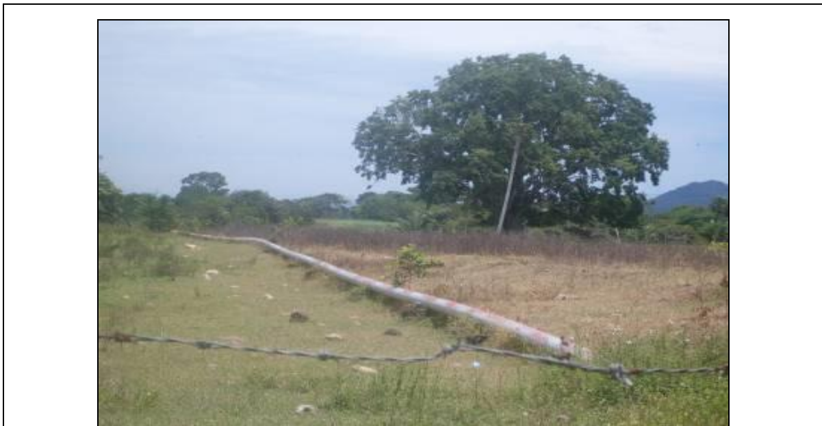
Fotografía 2-50 Infraestructura para Transporte de Combustible
