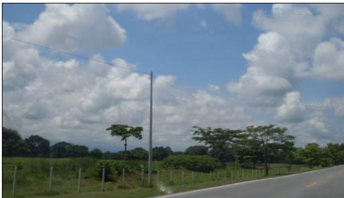
Fotografía 2-19 Infraestructura de Terceros, Red de Comunicaciones (Margen Derecha)
