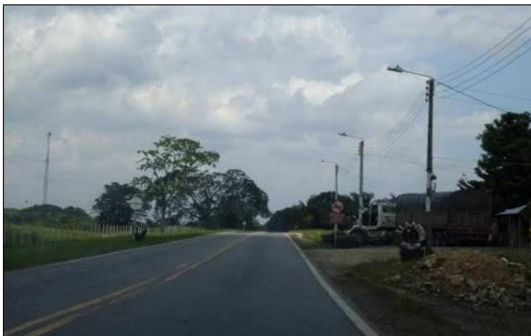
Fotografía 2-27 Infraestructura de Baja Tensión y Alumbrado Público
