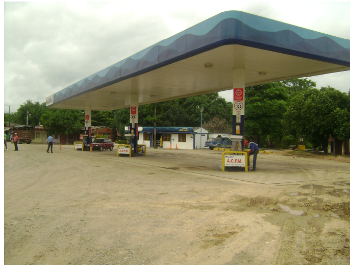
Fotografía 3-38 Predio de la estación de servicio que presenta afectación parcial
