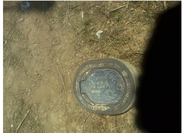
Fotografía 3-57 Urbanización Alto Prado – Bolsillo II, instalación de redes de acueducto
