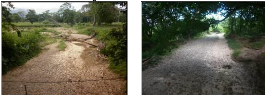
Fotografía 3-8: Quebrada San Pedro
