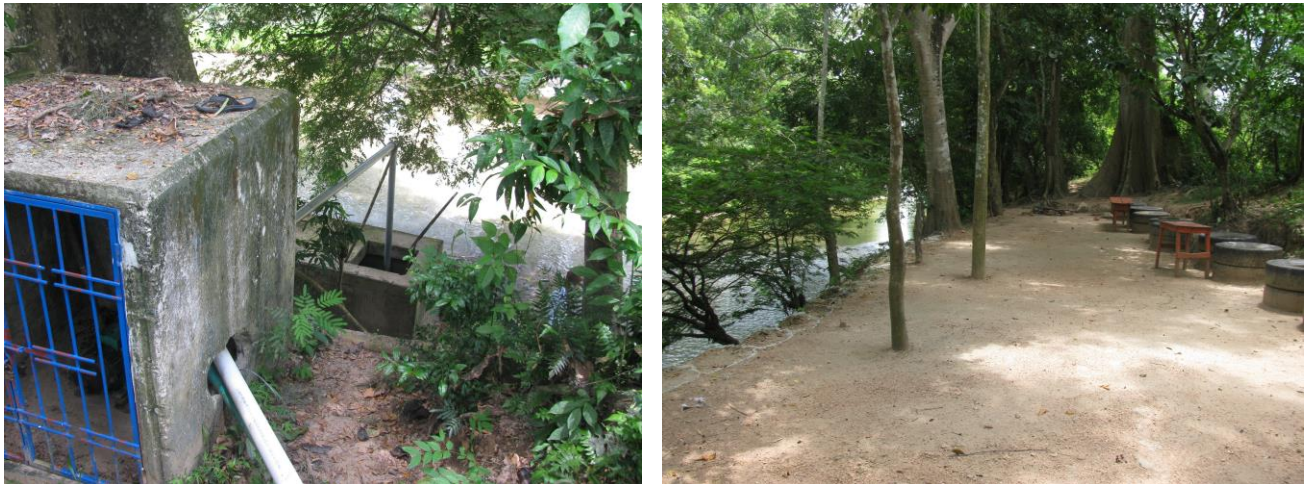
Fotografía 3-1 Quebrada La Floresta Bocatoma y zona del balneario
