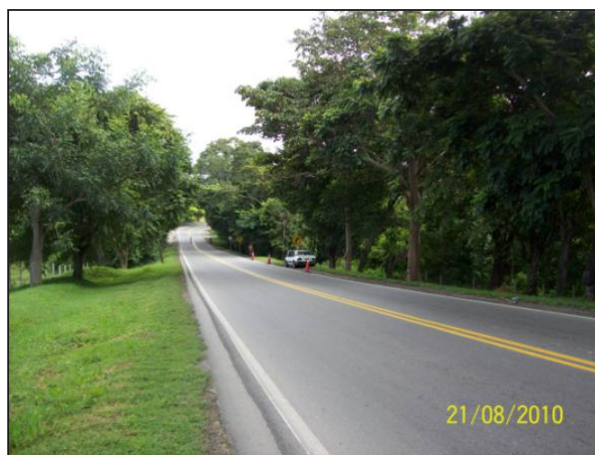
Fotografía 3-2 Detalle de acercamiento con el sitio de empalme noroccidental (a la izquierda de la foto, al fondo en la curva)
