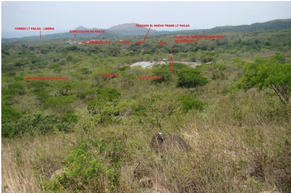
Foto 1. Vista panorámica del trazado del nuevo tramo la línea de transmisión de conexión a la subestación Pailas
