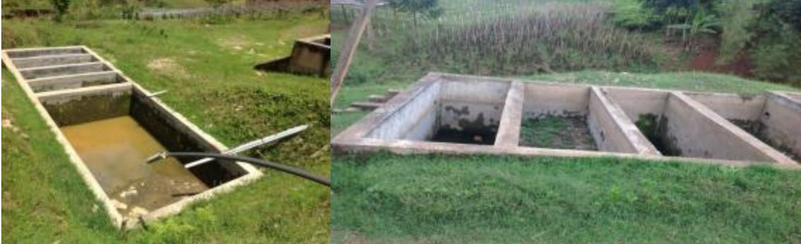
*Photo 5&6: Bac de prétraitement des eaux usées a Kabarore et Kinyovu*
