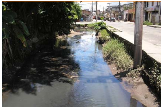
Assoreamento do canal. Água com aspecto bastante crítico.
