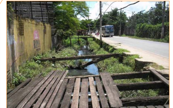
Passagens improvisadas. Água com aspecto crítico.
