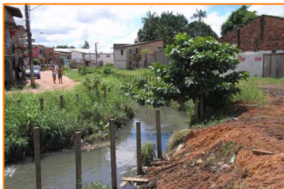
Inexistência de mata ciliar e solo exposto junto ao canal.
