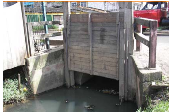
Comporta situada na transição dos canais da Avenida Bernardo Sayão e Rua dos Timbras. Água com aspecto bastante crítico.
