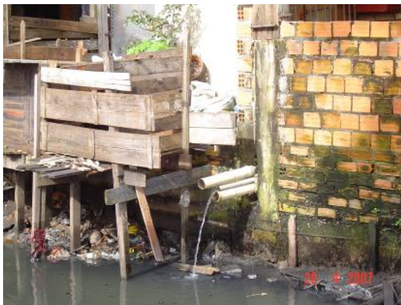
Foto 57: Moradia às margens do Canal da Dr. Moraes. Em evidência o lançamento de efluentes domésticos direto no canal
