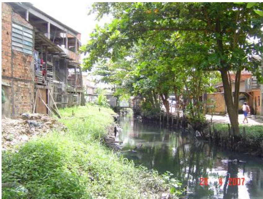
Foto 55: Canal da Quintino, mostrando a pouca vegetação das margens plantada pelos moradores e moradias implantadas sobre as margens
