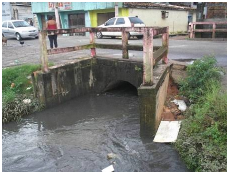
Foto 7: Bueiro situado no encontro dos canais de drenagem da Avenida Bernardo Sayão e Rua dos Timbiras. Horário da foto: 17:00h do dia 21/03/2007.
