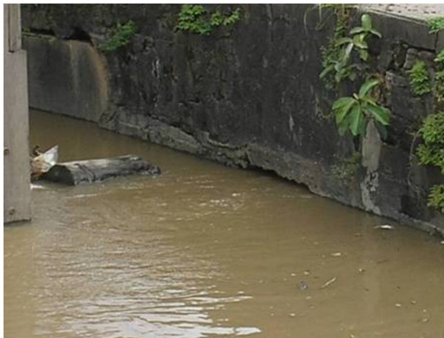
Foto 12: Comporta situada no canal artificial da Avenida Bernardo Sayão, próximo à Rua Veiga Cabral. Horário da foto: 13:00h do dia 21/03/2007.
