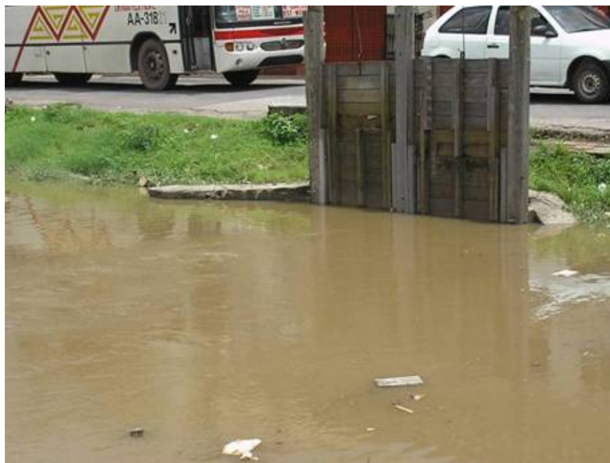
Foto 19: Comporta situada no canal artificial da Avenida Bernardo Sayão esquina com Rua Caripunas. Horário da foto: 14:10h do dia 21/03/2007.
