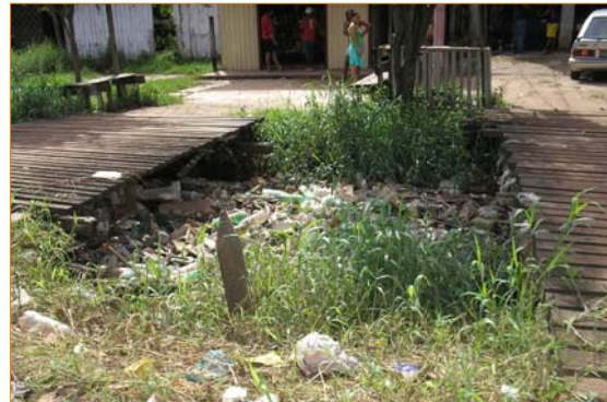
Quantidade excessiva de de resíduos obstruindo o canal.
