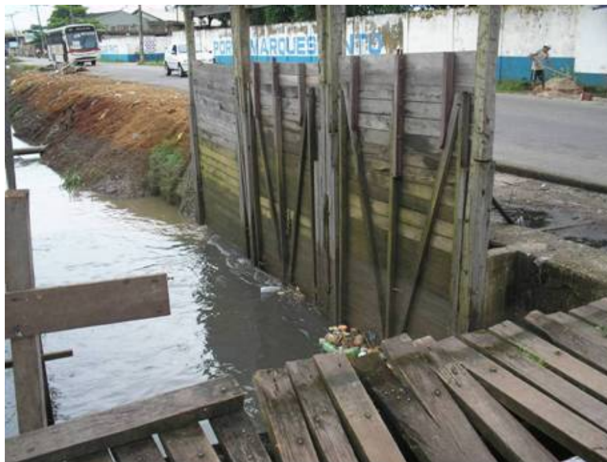
Foto 24: Comporta situada no encontro dos canais de drenagem da Avenida Bernardo Sayão e da Travessa Quintino Bocaiúva. Horário da foto: 17:00h do dia 21/03/2007.
