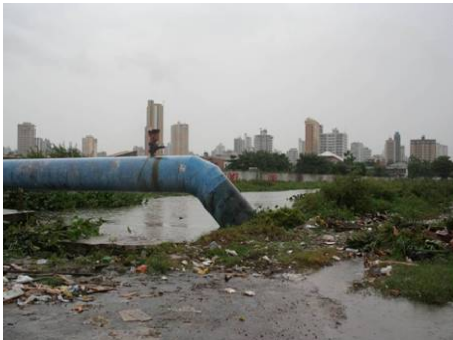
Foto 44: Canal da Travessa Quintino Bocaiúva esquina com Rua Engenheiro Fernando Guilhon – Vista de montante.
