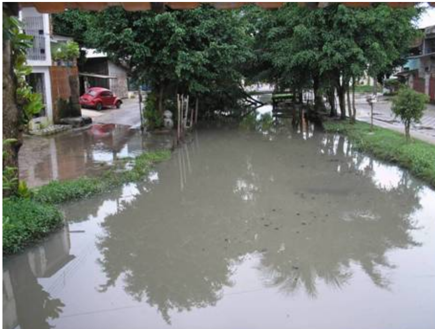
Foto 22: Canal da Travessa 14 de Março esquina com Rua Caripunas. Horário da foto: 16:30h do dia 21/03/2007.
