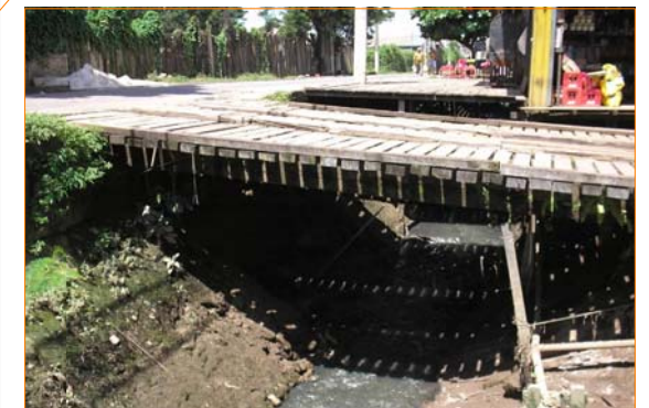
Ocupações avançam sobre o leito do canal. Água com aspecto crítico.
