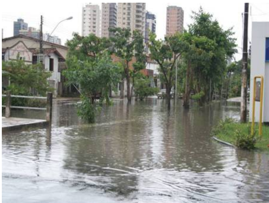
Foto 37: Canal da Travessa 14 de Março esquina com Rua dos Pariquis – Vista de montante.
