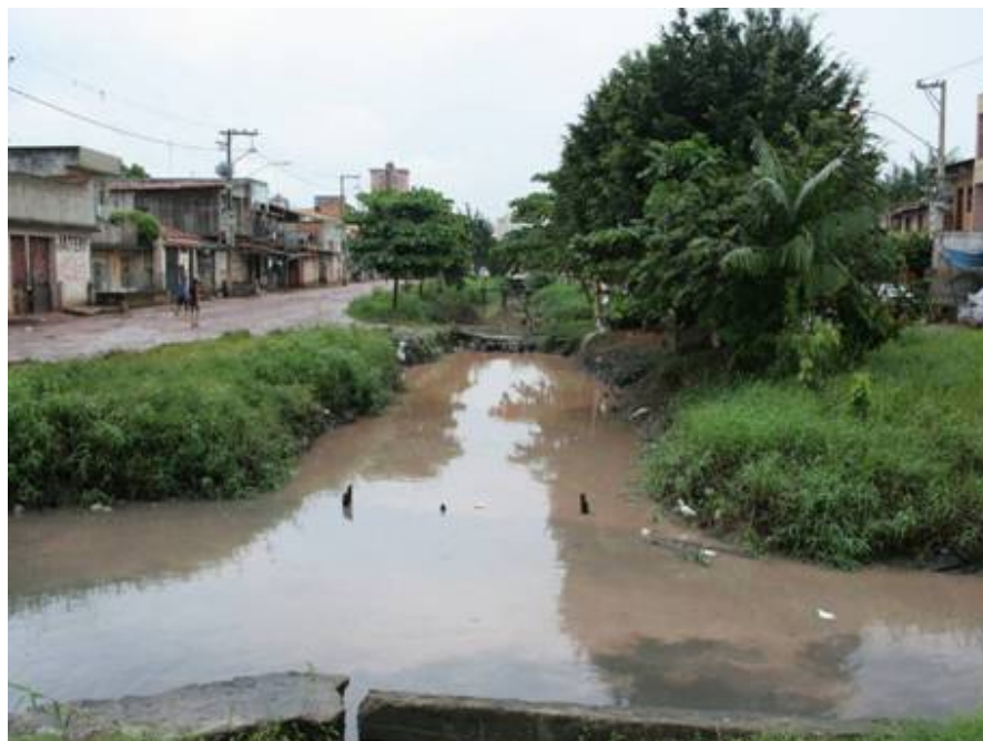
Foto 32: Canal da Rua Caripunas esquina com Avenida Bernardo Sayão.
