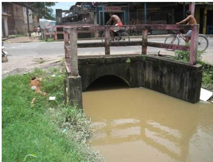
Foto 5: Bueiro situado no encontro dos canais de drenagem da Avenida Bernardo Sayão e Rua dos Timbiras. Horário da foto: 13:30h do dia 21/03/2007.
