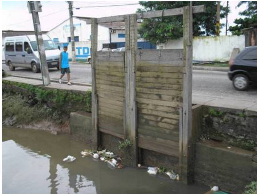
Foto 28: Comporta situada no encontro dos canais de drenagem da Travessa 3 de Maio e da Avenida Bernardo Sayão. Horário da foto: 17:10h do dia 21/03/2007.
