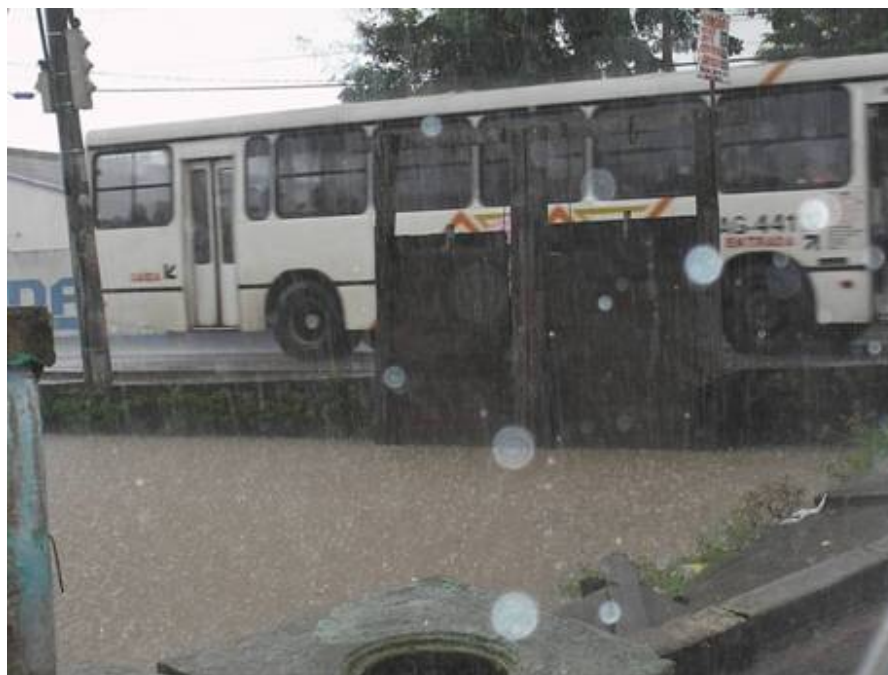
Foto 27: Comporta situada no encontro dos canais de drenagem da Travessa 3 de Maio e da Avenida Bernardo Sayão. Horário da foto: 14:40h do dia 21/03/2007.
