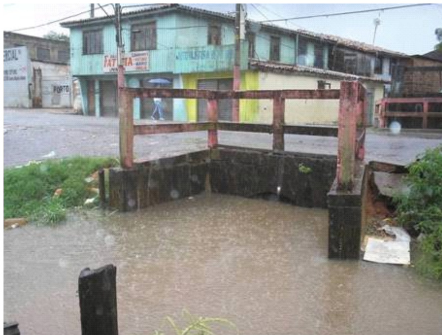
Foto 6: Bueiro situado no encontro dos canais de drenagem da Avenida Bernardo Sayão e Rua dos Timbiras. Horário da foto: 15:10h do dia 21/03/2007.
