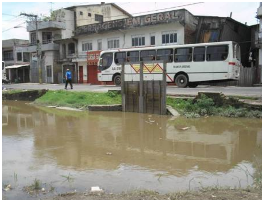
Foto 18: Comporta situada no canal artificial da Avenida Bernardo Sayão esquina com Rua Caripunas. Horário da foto: 13:30h do dia 21/03/2007.
