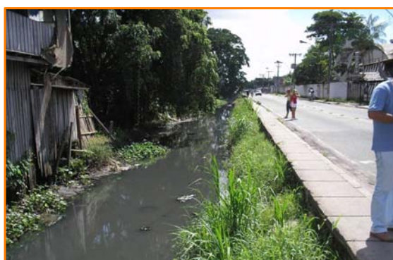
Proximidade das construções ao canal. Água com aspecto bastante crítico.
