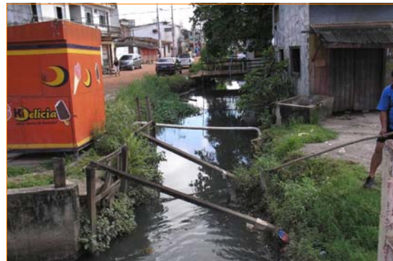
Confluência dos canais da Bernardo Sayão com a Timbras. Água com aspecto bastante crítico.
