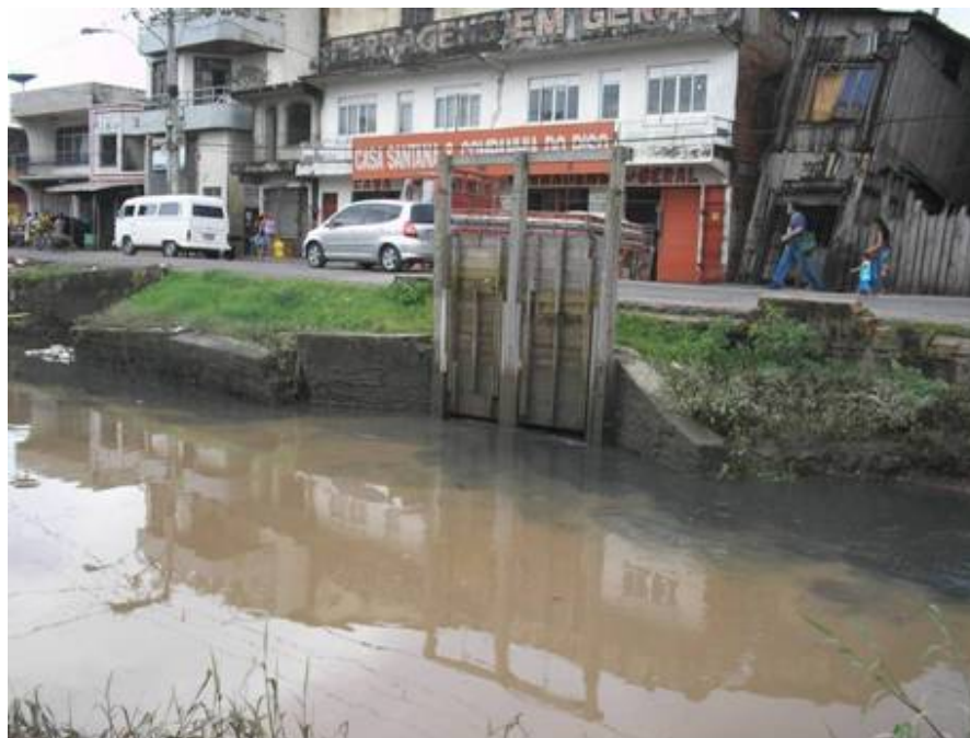
Foto 21: Comporta situada no canal artificial da Avenida Bernardo Sayão esquina com Rua Caripunas. Horário da foto: 17:00h do dia 21/03/2007.
