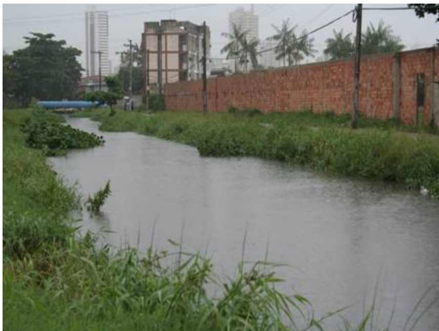
Foto 47: Canal da Travessa Quintino Bocaiúva esquina com Travessa Apinagés.
