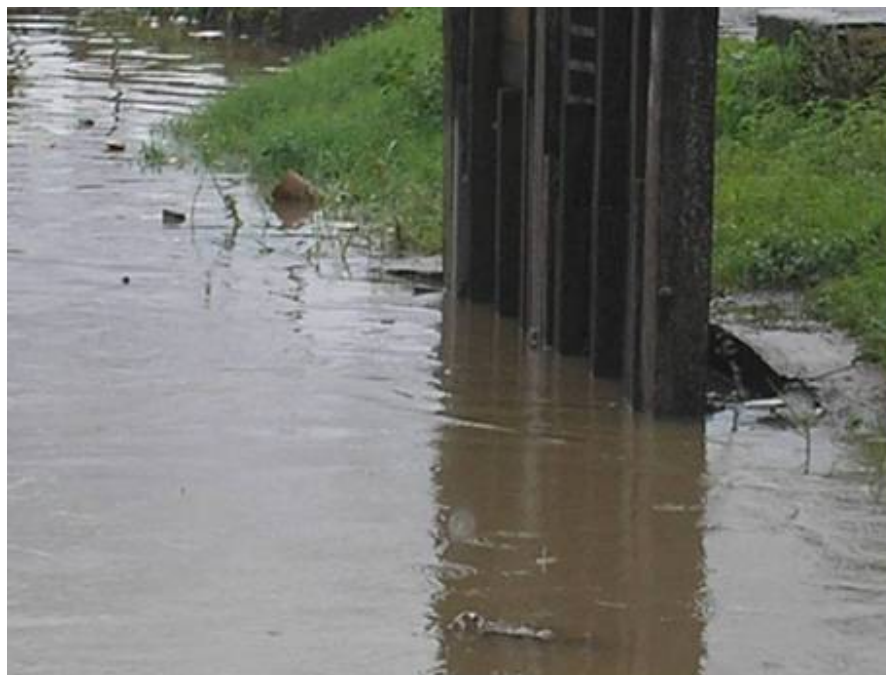
Foto 20: Comporta situada no canal artificial da Avenida Bernardo Sayão esquina com Rua Caripunas. Horário da foto: 15:10h do dia 21/03/2007.
