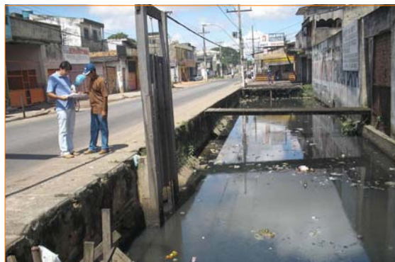
Passagens improvisadas para permitir o acesso às residências. Disposição irregular de resíduos. Água com aspecto bastante crítico.
