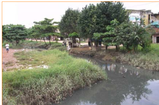
Confluência dos canais da Bernardo Sayão com a Caripunas. Disposição irregular de resíduos. Água apresentando alto grau de contaminação.
