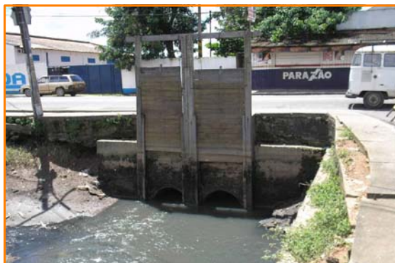
Comporta situada no encontro dos canais da Travessa 3 de Maio e da Avenida Bernardo Sayão
