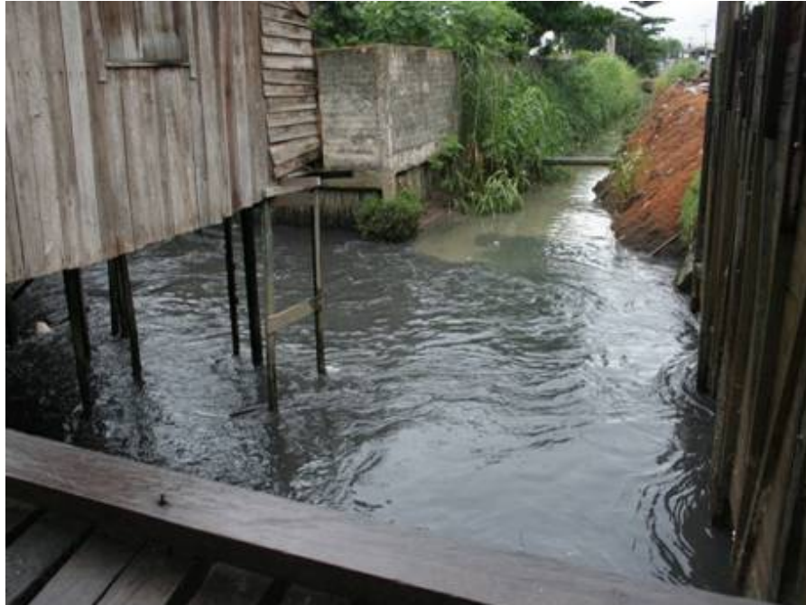
Foto 51: Canal da Travessa Quintino Bocaiúva esquina com Avenida Bernardo Sayão.
