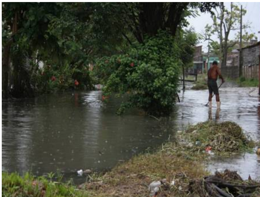
Foto 45: Canal da Travessa Quintino Bocaiúva esquina com Rua Engenheiro Fernando Guilhon – Vista de jusante.
