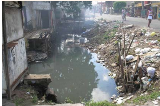
Ocupação residencial avança sobre o leito do canal. Disposição irregular de resíduos. Água apresentando alto grau de contaminação.
