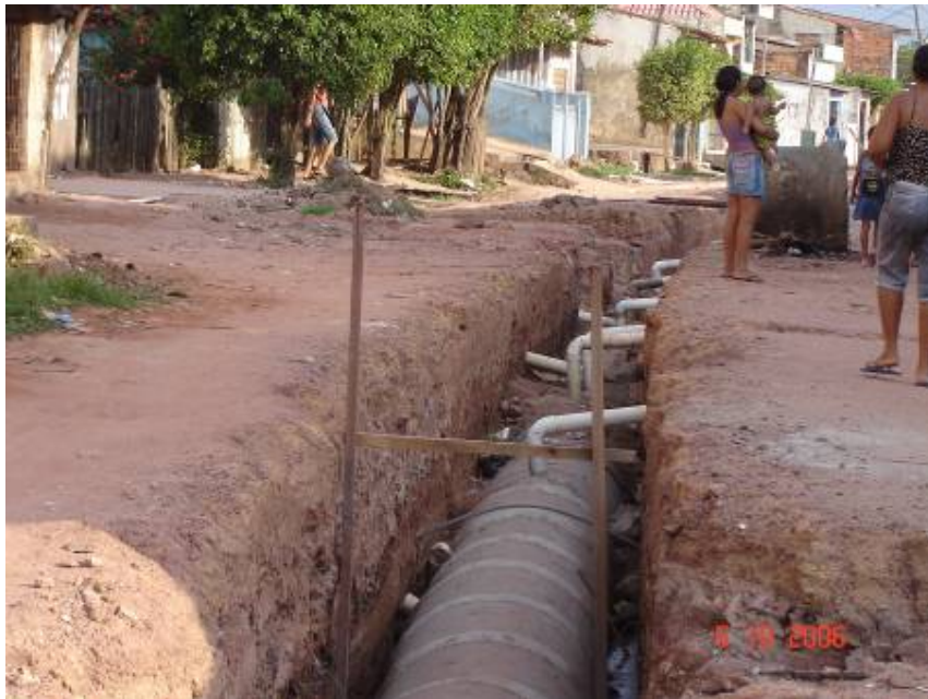
Figura 23: Ligações de esgotos na rede de microdrenagem em implantação
