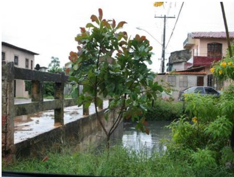
Foto 49: Canal da Travessa Quintino Bocaiúva esquina com Travessa Honório José dos Santos – Vista de montante.
