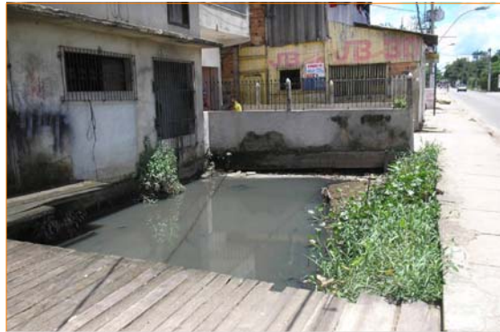
Ocupação residencial avança sobre o leito do canal. Disposição irregular de resíduos. Água com aspecto bastante crítico.
