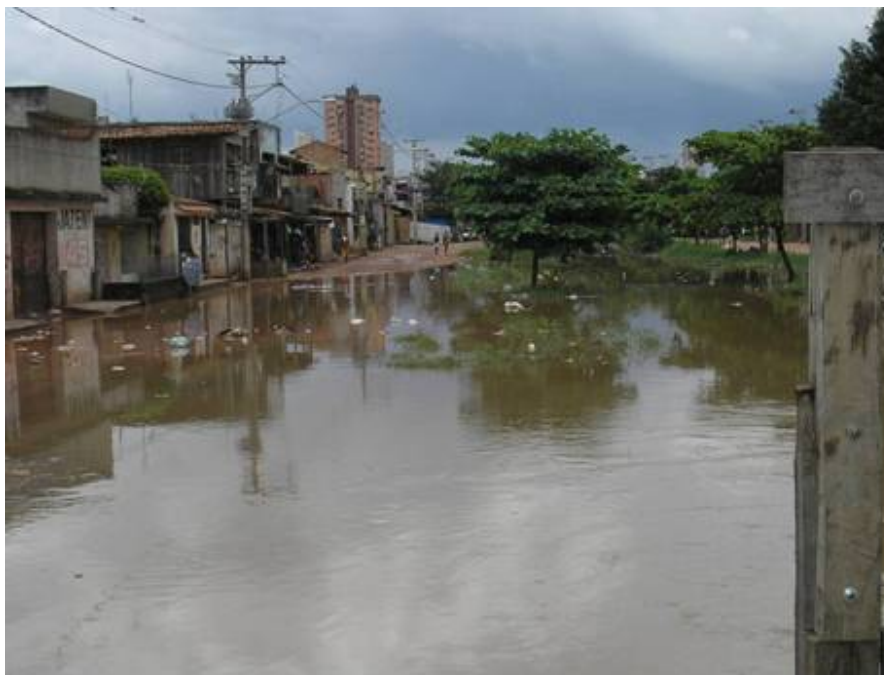
Foto 16: Canal da Rua Caripunas esquina com a Avenida Bernardo Sayão. Horário da foto: 14:10h do dia 21/03/2007.
