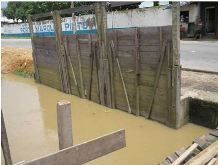
Foto 23: Comporta situada no encontro dos canais de drenagem da Avenida Bernardo Sayão e da Travessa Quintino Bocaiúva. Horário da foto: 14:00h do dia 21/03/2007.
