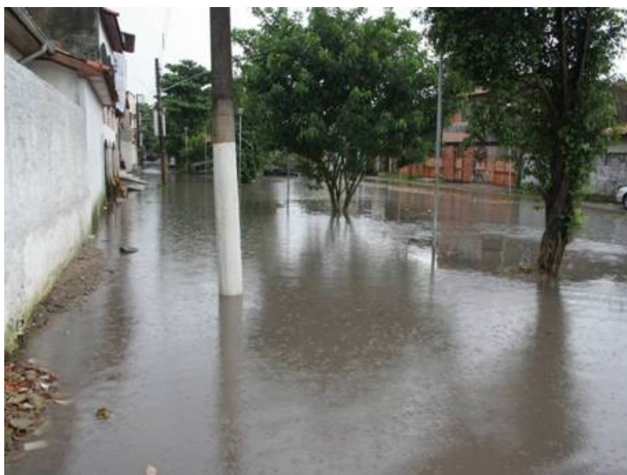
Foto 38: Canal da Travessa 14 de Março esquina com Rua dos Pariquis – Vista de jusante.
