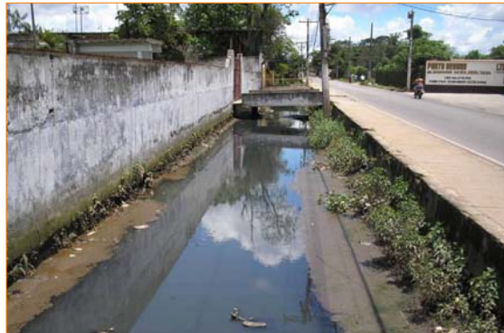
Disposição irregular de resíduos. Água com aspecto bastante crítico.
