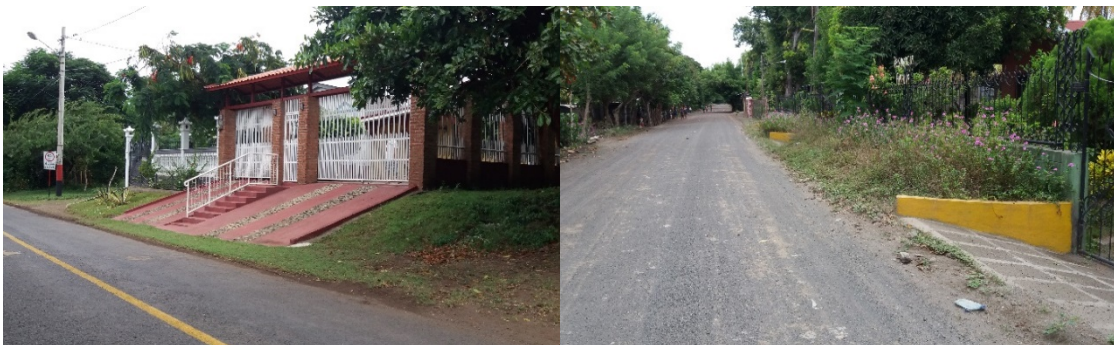
Ilustración 4: Accesos afectados por estar en el espacio del derecho de vía.
