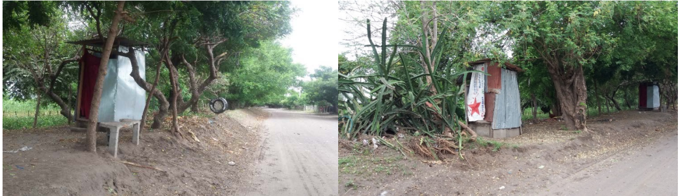
Ilustración 5: Letrinas ubicadas en el derecho de vía que serán afectadas durante la obra.
