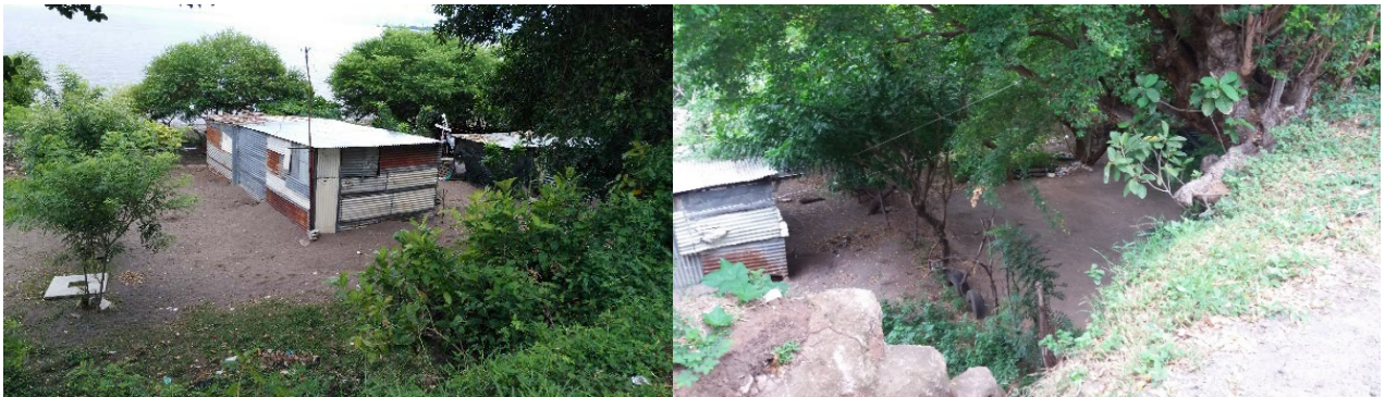
Ilustración 3: Sector Mira lagos. Viviendas en el sector Costero, por debajo del talud de relleno
