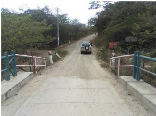
Ilustración No. 2: Inicio del tramo
