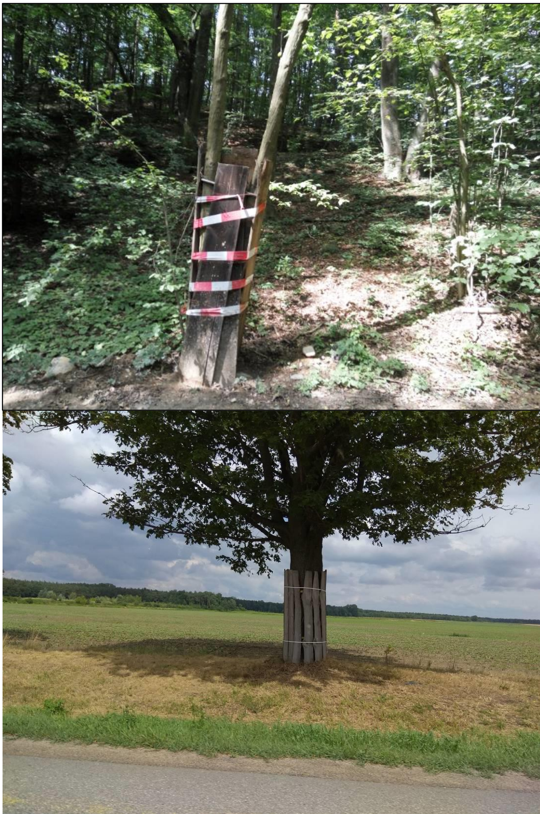
Fotografia 19 Przykładowy sposób ochrony pnia drzewa przed uszkodzeniami mechanicznymi
