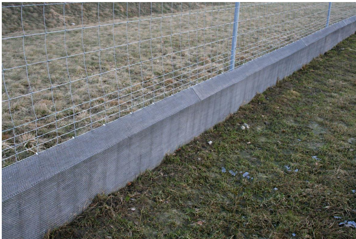
Fotografia 26 Przykład ogrodzenia ochronno-naprowadzającego z siatki stalowej
