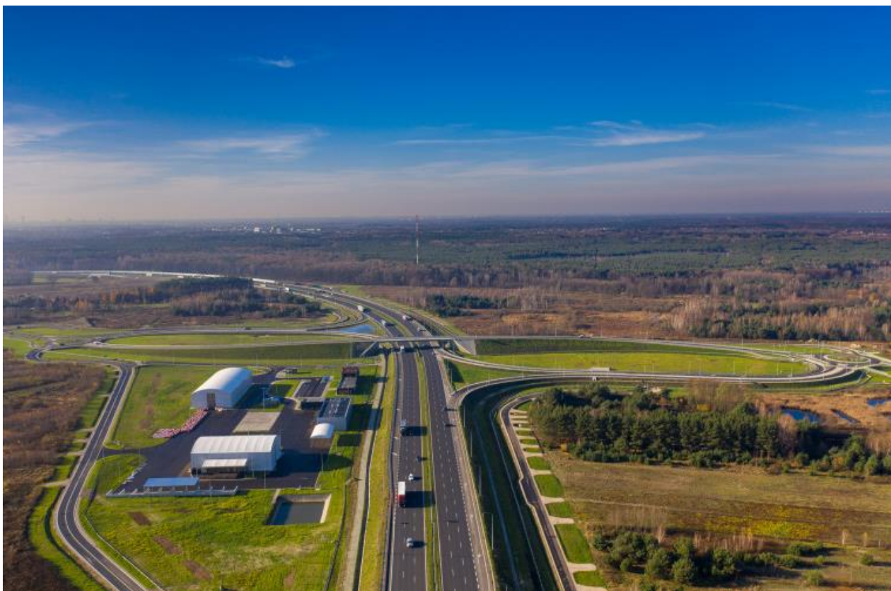
Fotografia 5 Droga ekspresowa S8 Marki – Radzymin z obwodem utrzymania drogi (OUD) jako element krajobrazu (źródło: GDDKIA)
