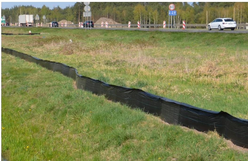
Fotografia 22 Przykład wykonania tymczasowych wygradzeń dla płazów
