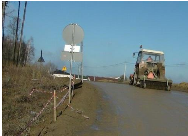
Fotografia 2 Czyszczenie dróg dojazdowych
