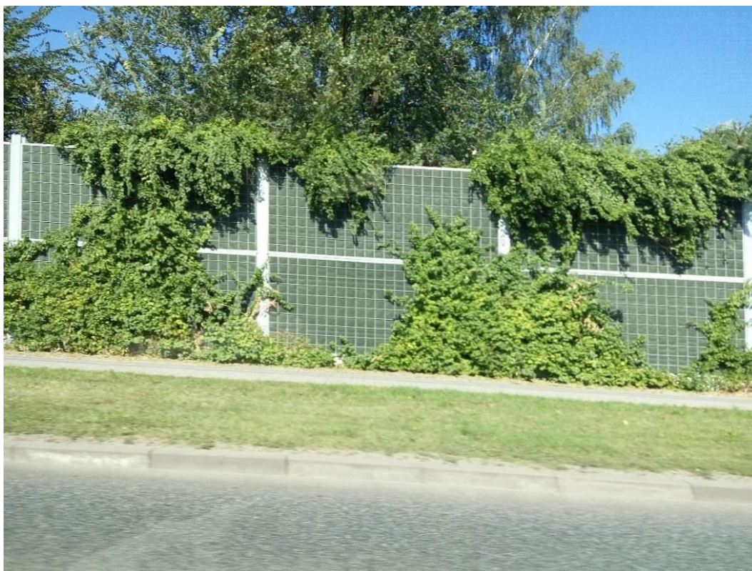
Fotografia 7 Ekran akustyczny pochłaniający obrosnięty pnączami (droga ekspresowa S7)
