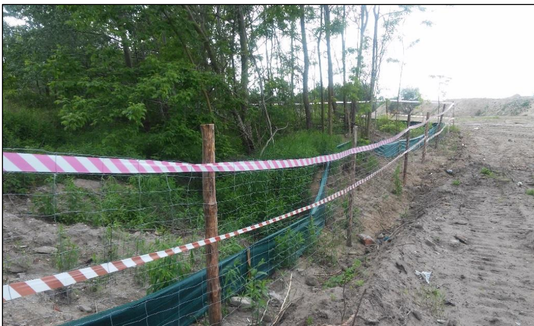
Fotografia 21 Przykład wykonania tymczasowych wygradzeń dla płazów
