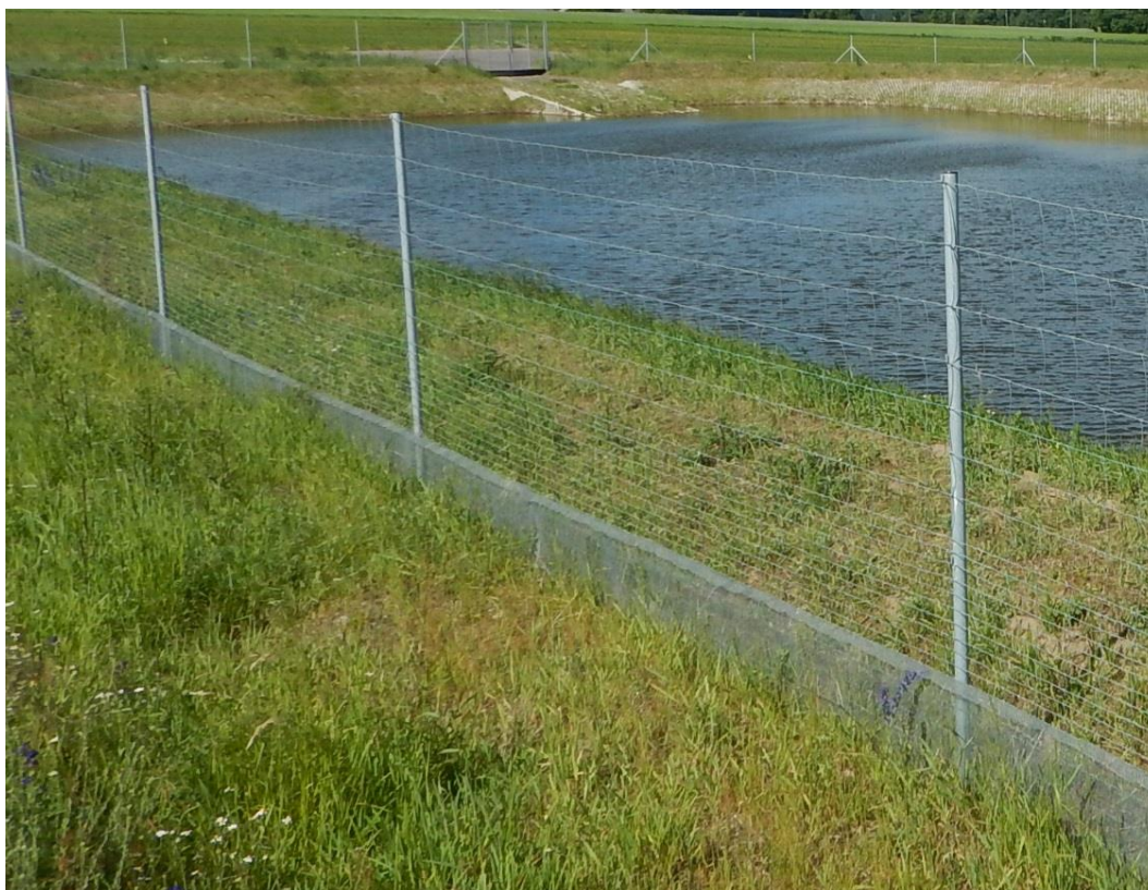
Fotografia 20 Przykład wykonania siatki ochronno-naprowadzającej dla płazów
