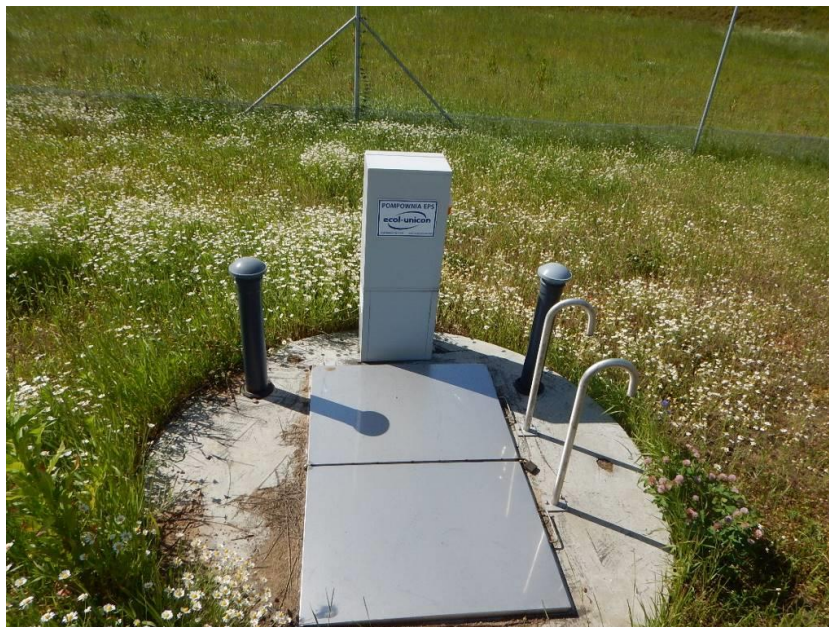
Fotografia 3 Przykład wykonania przepompowni (obwodnica Szczuczyna)
