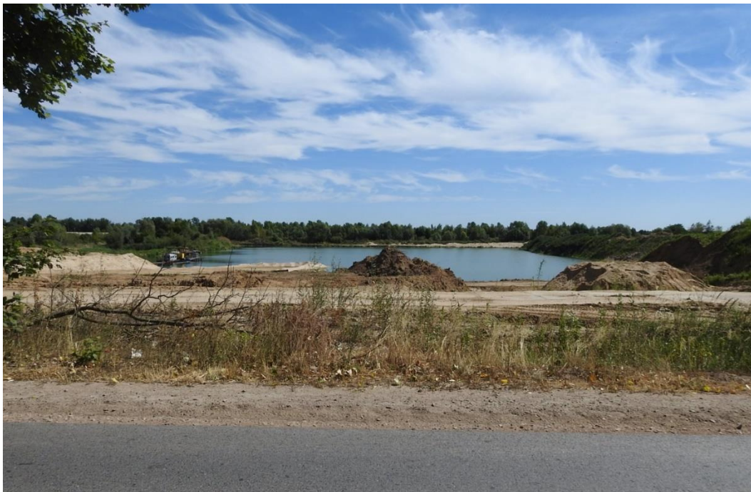
Fotografia 16 Jeden ze zbiorników – po stronie lewej widoczny refuler przerzucający urobek
