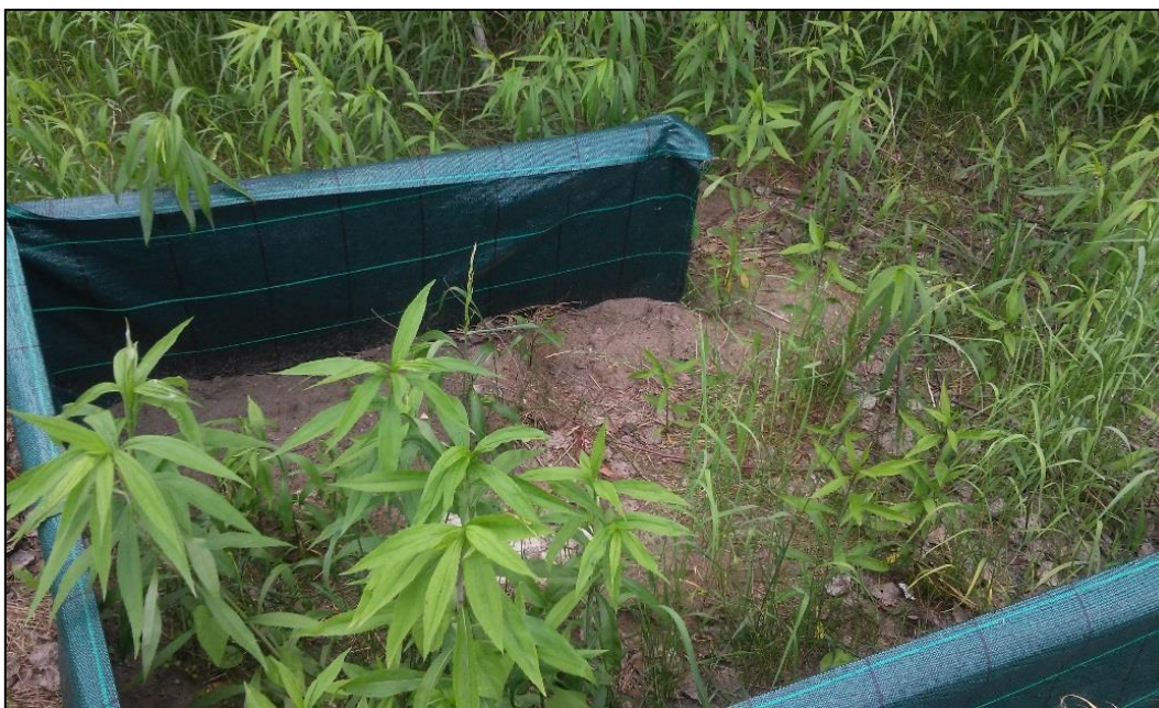
Fotografia 23 Przykład wykonania U-kształtne zakończenie płotka tymczasowego
