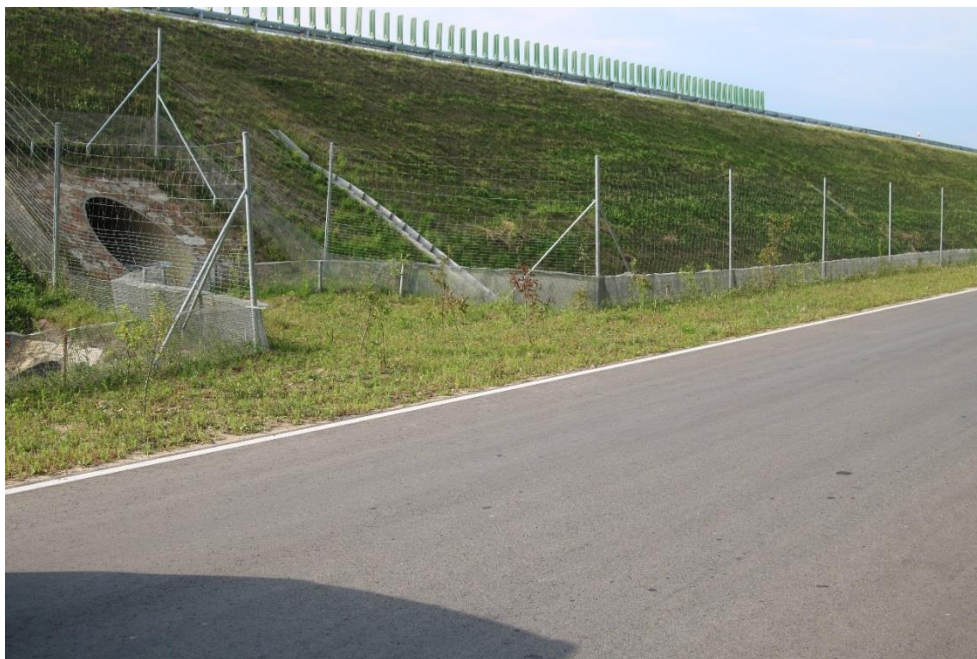
Fotografia 24 Przykład wykonania przejścia po powierzchni drogi dojazdowej – droga ekspresowa S7 Radom - Szydłowiec
