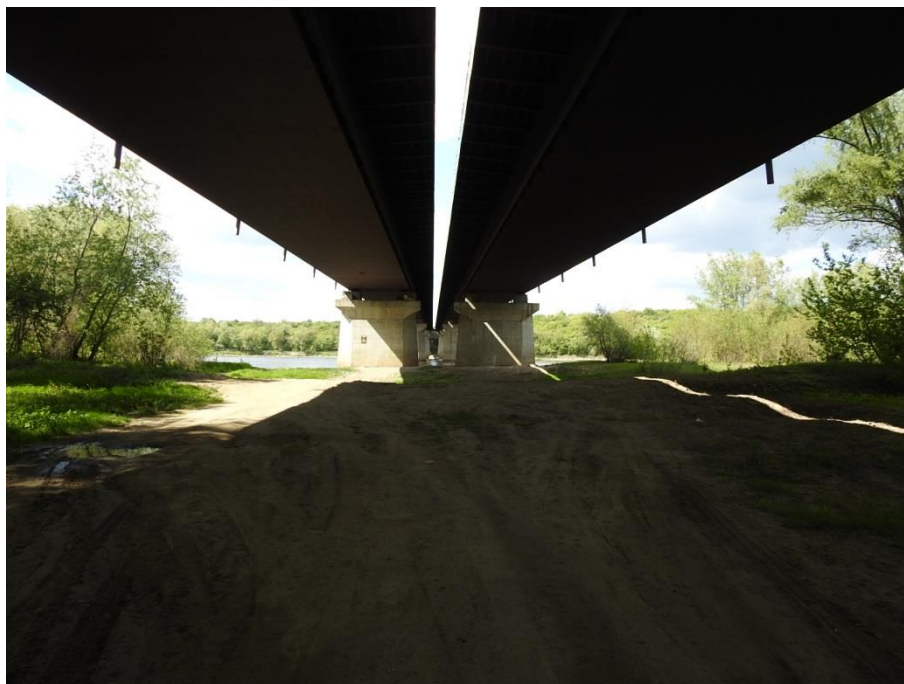
Fot. 4-20 Most na Wiśle – zapewnia swobodną migrację ssakom
