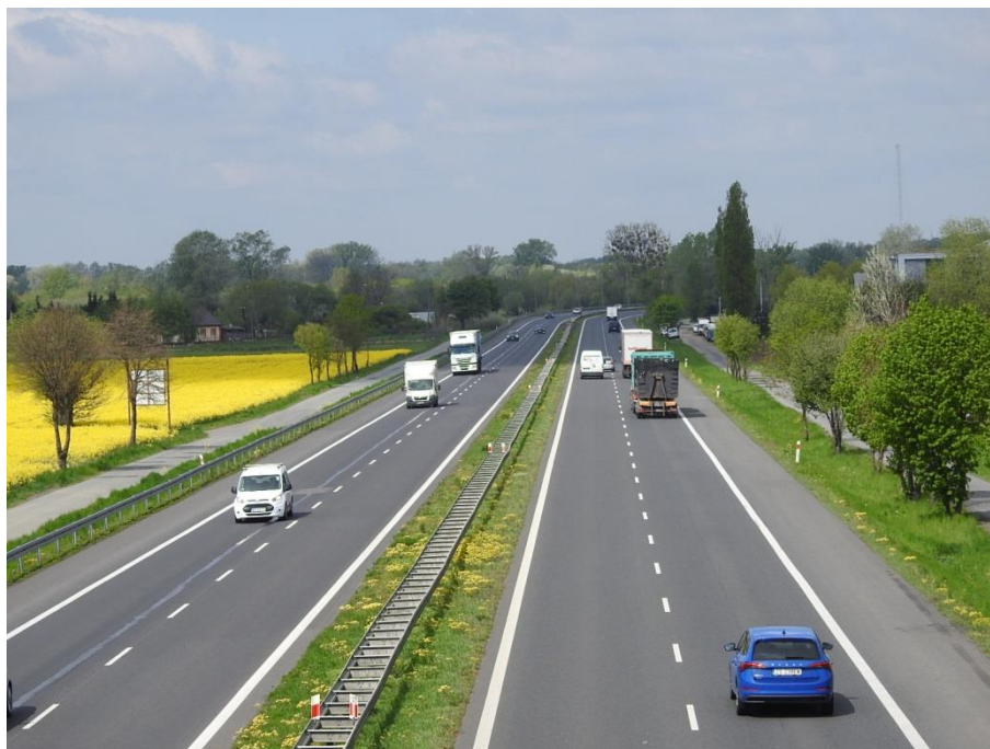
Fot. 4-19 Otoczenie istniejącej DK 7 widoczna zabudowa
