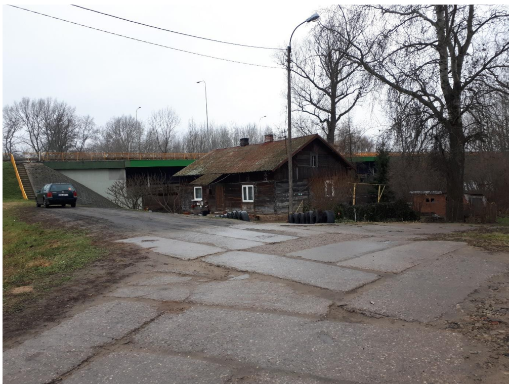
Fot. 4-6 Wał wiślany i budynek zlokalizowany w międzywalu
