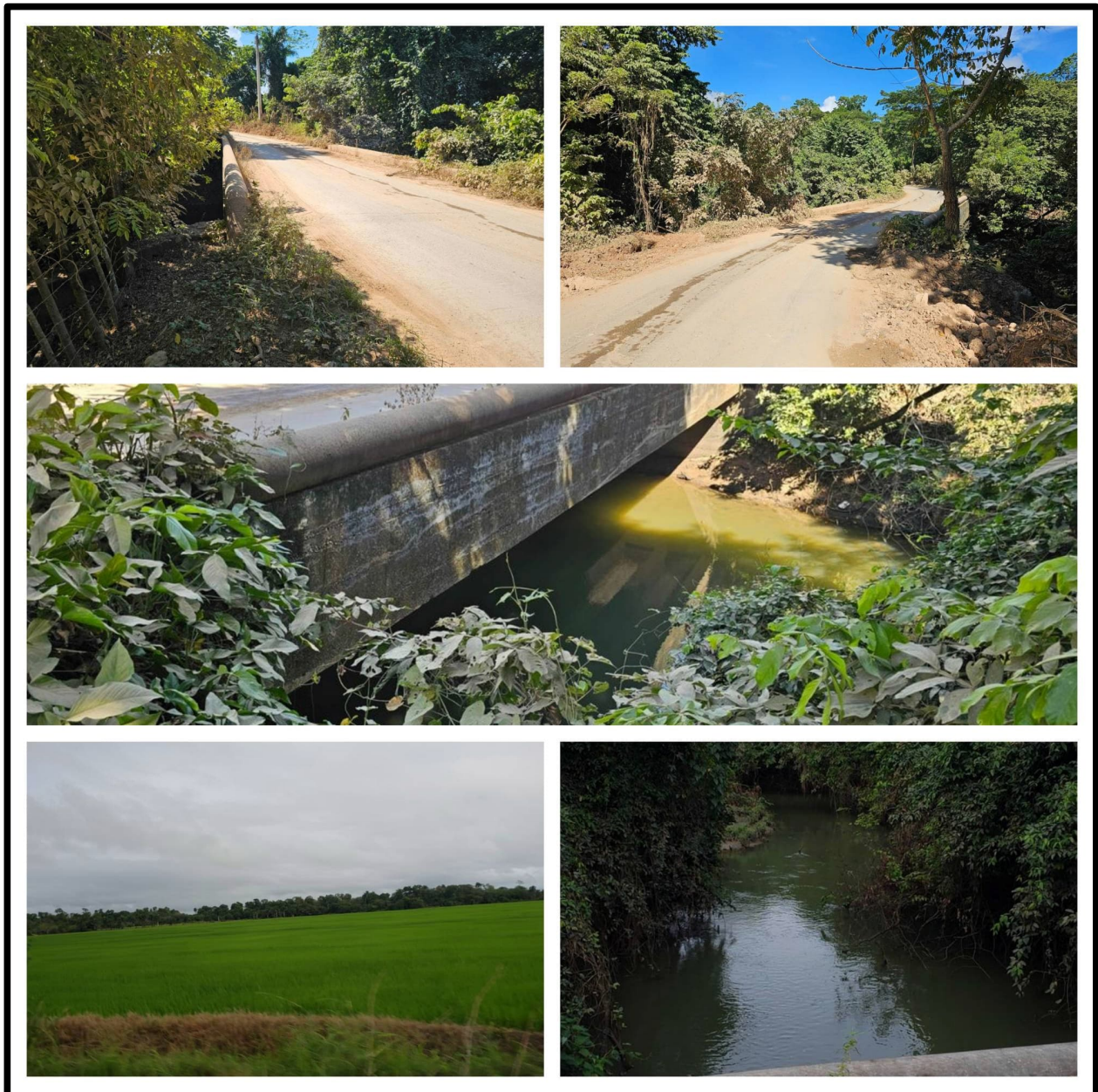
Figura 4.245: Entorno del cauce del río Payabo
