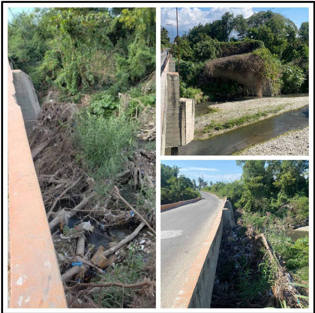
Figura 4.222: Acumulación de restos durante las crecidas del río Jura en el P-0184
