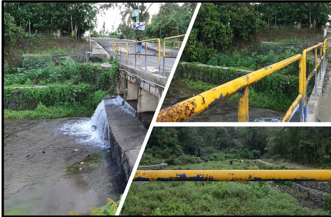
Figura 4.49: Entorno transformado del puente P-086.
