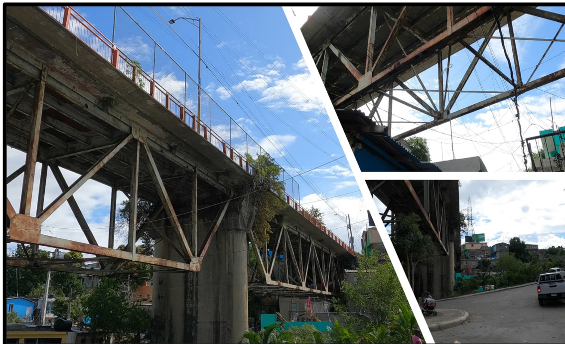
Figura 4.43: Detalles de los entornos muy transformados del puente P-070.
