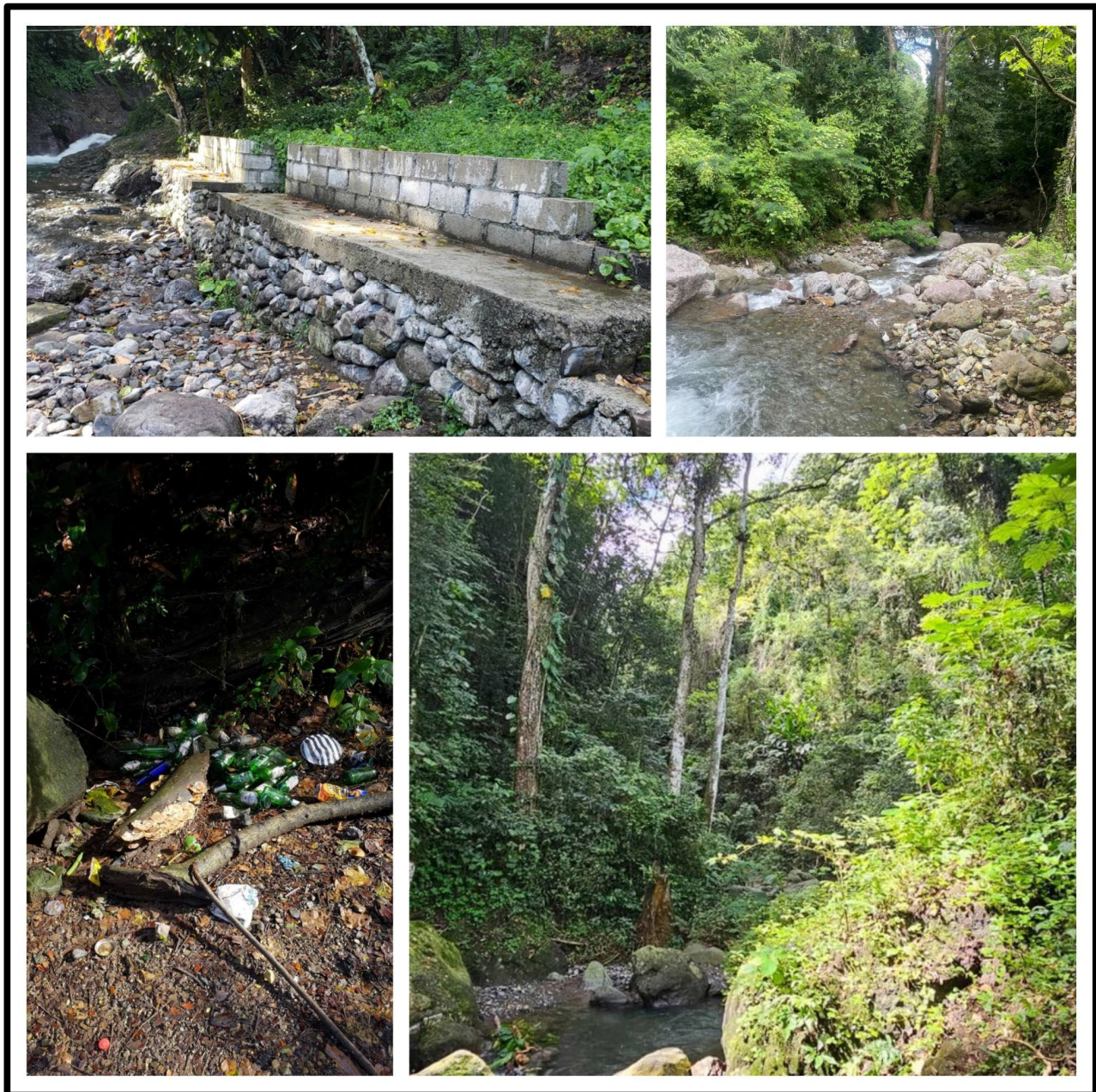
Figura 4.293: Valle del río Piedra
