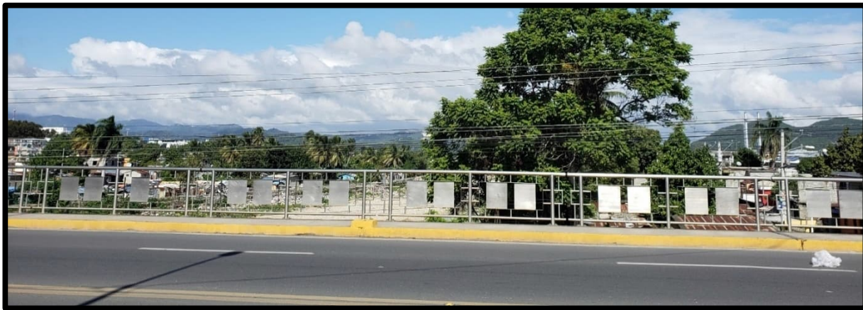
Figura 4.341: Tendido eléctrico en el P-0058
