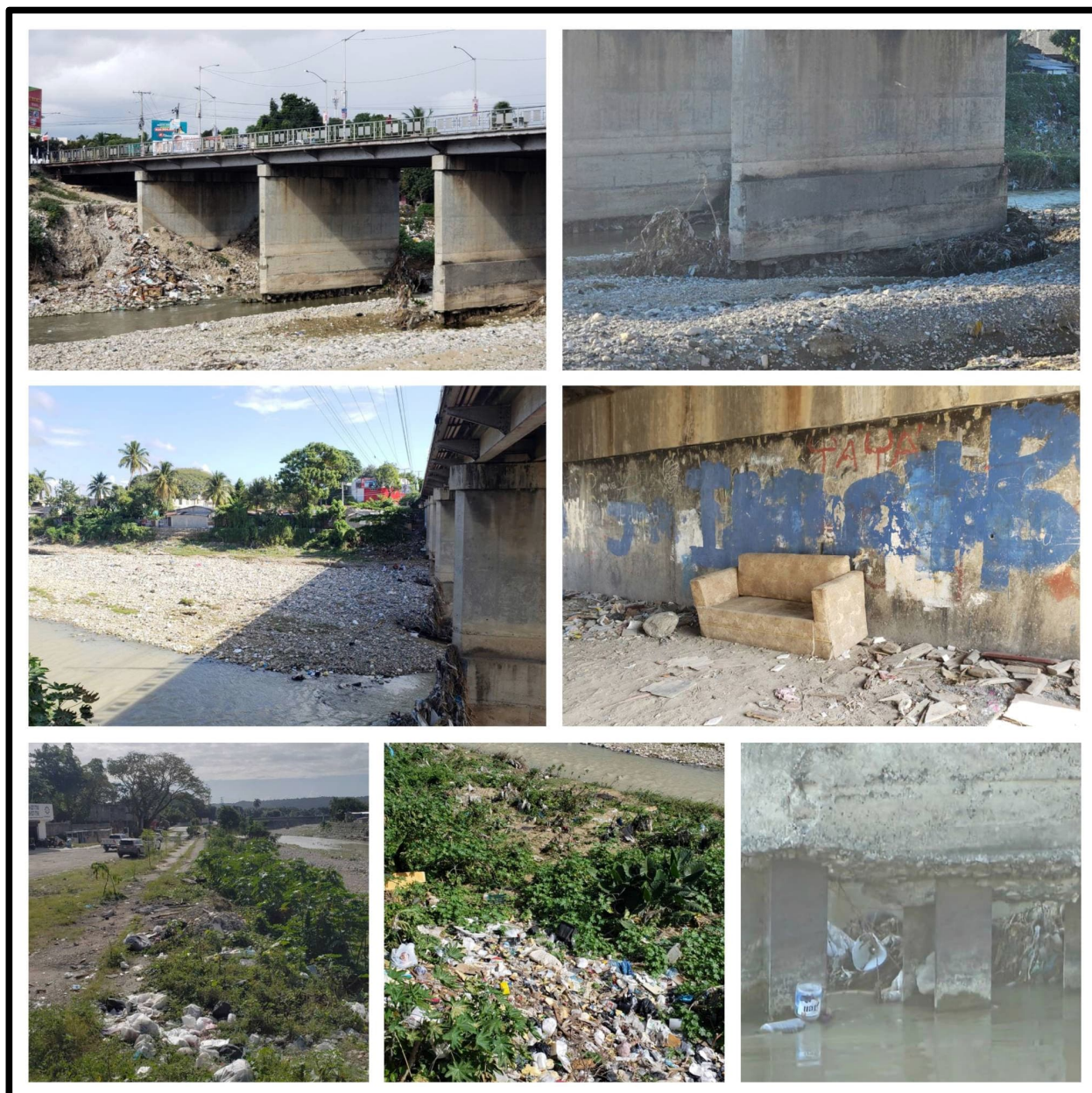
Figura 4.339: Estado del río Yubazo en P-0058
