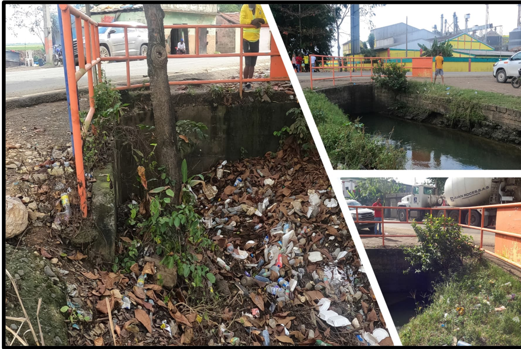
Figura 4.58: Entorno del puente P-1024.
