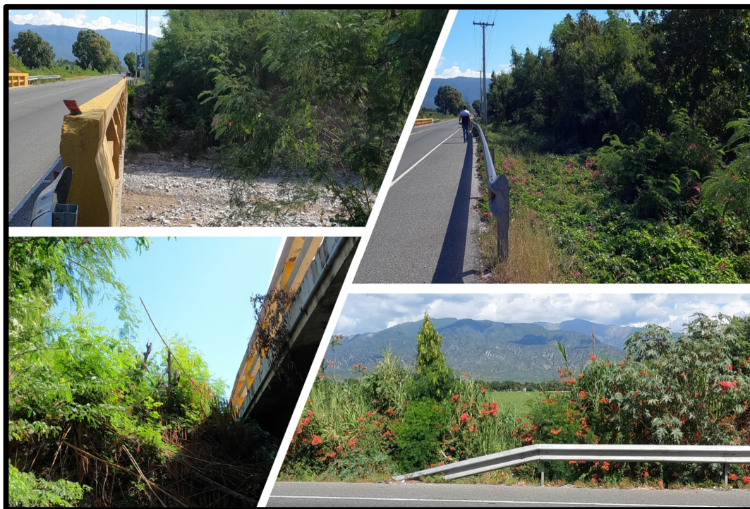
Figura 4.67: Entorno del puente P-046
