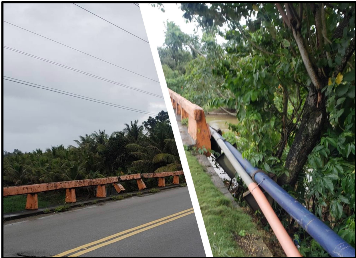
Figura 4.255: Interferencias con redes de servicios en P-0047
