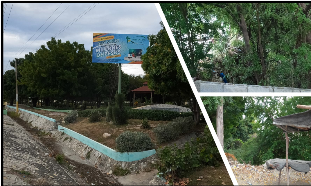
Figura 4.62: Relictos de vegetación del puente P-188.
