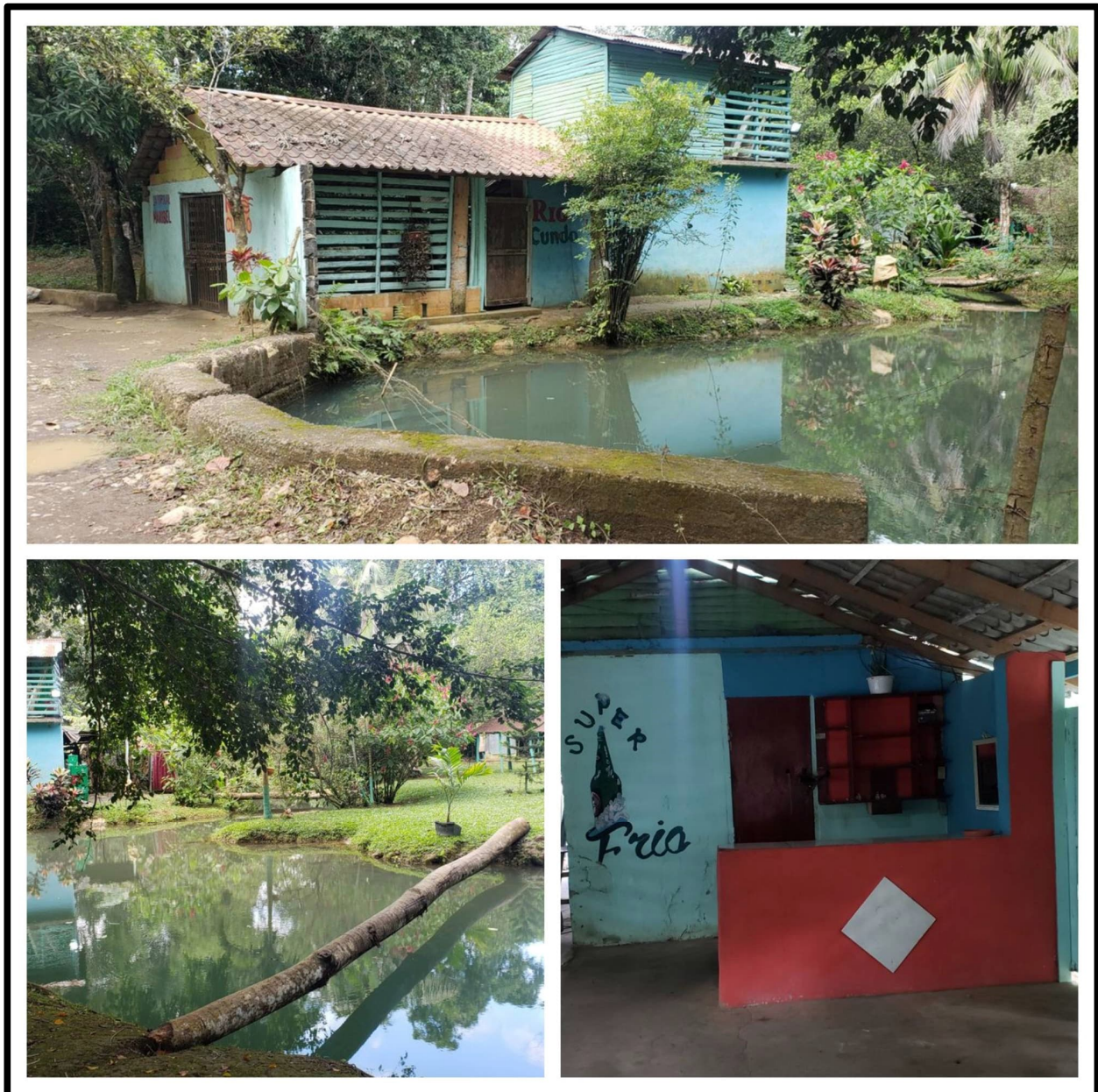
Figura 4.311: Bañerío informal colindante al puente
