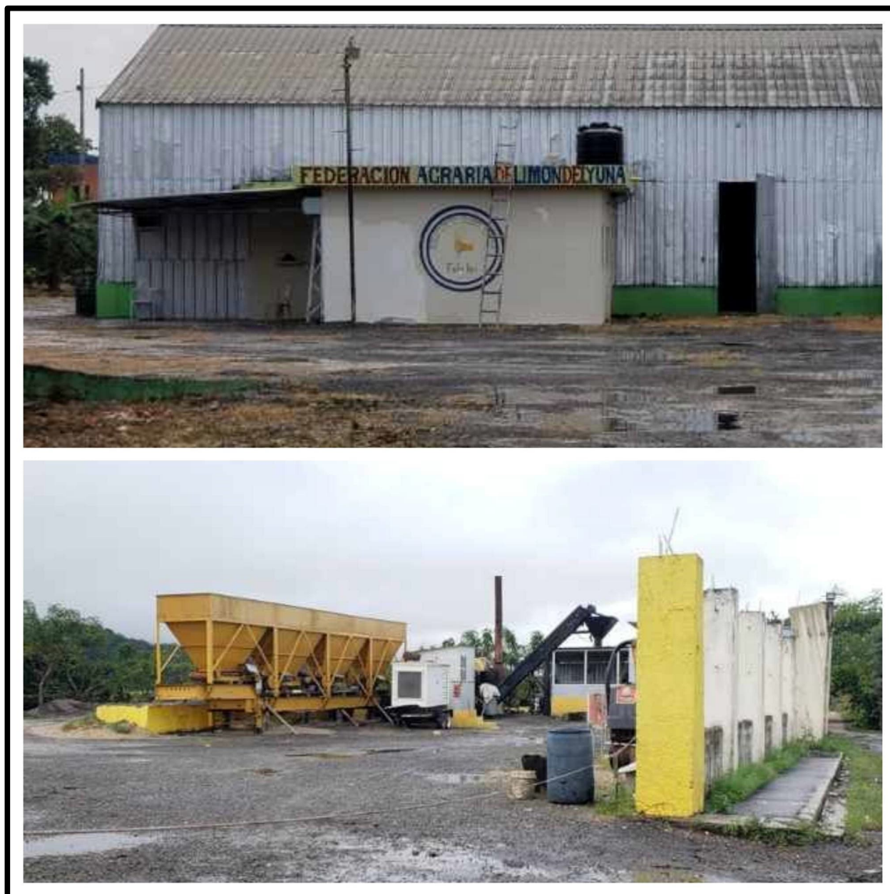
Figura 4.237: Establecimientos próximos al P-0917
