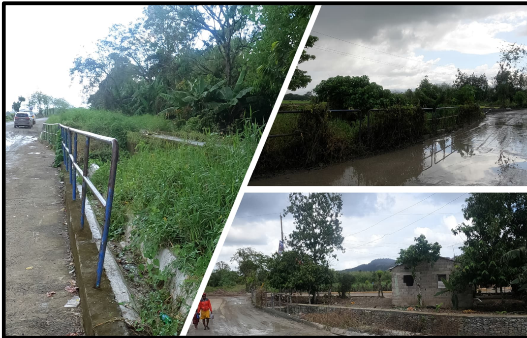
Figura 4.46: Entorno transformado del puente P-085.
