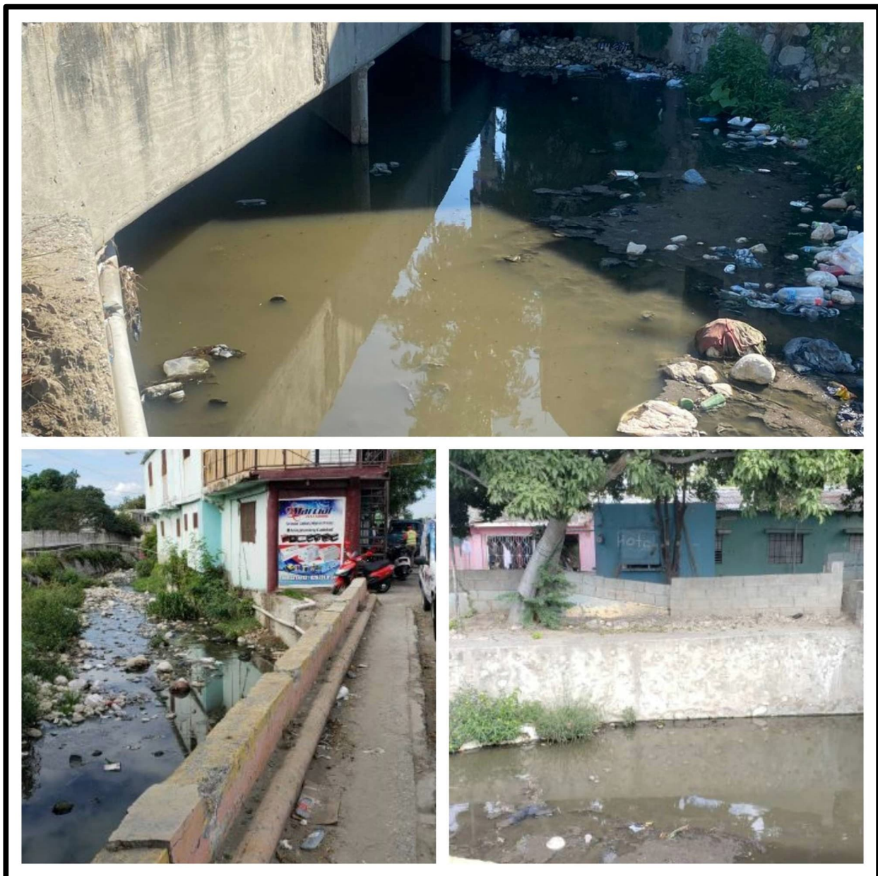
Figura 4.231: Signos de degradación ambiental en el entorno del P-0926
