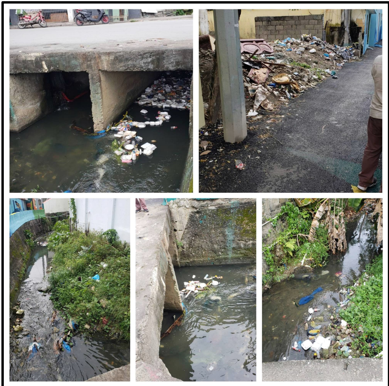
Figura 4.266: Signos de degradación en el entorno del P-1067
