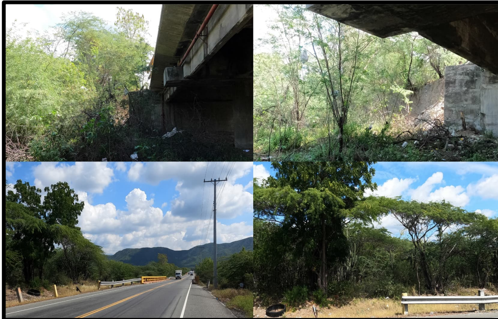
Figura 4.64: Entorno del puente P-008.
