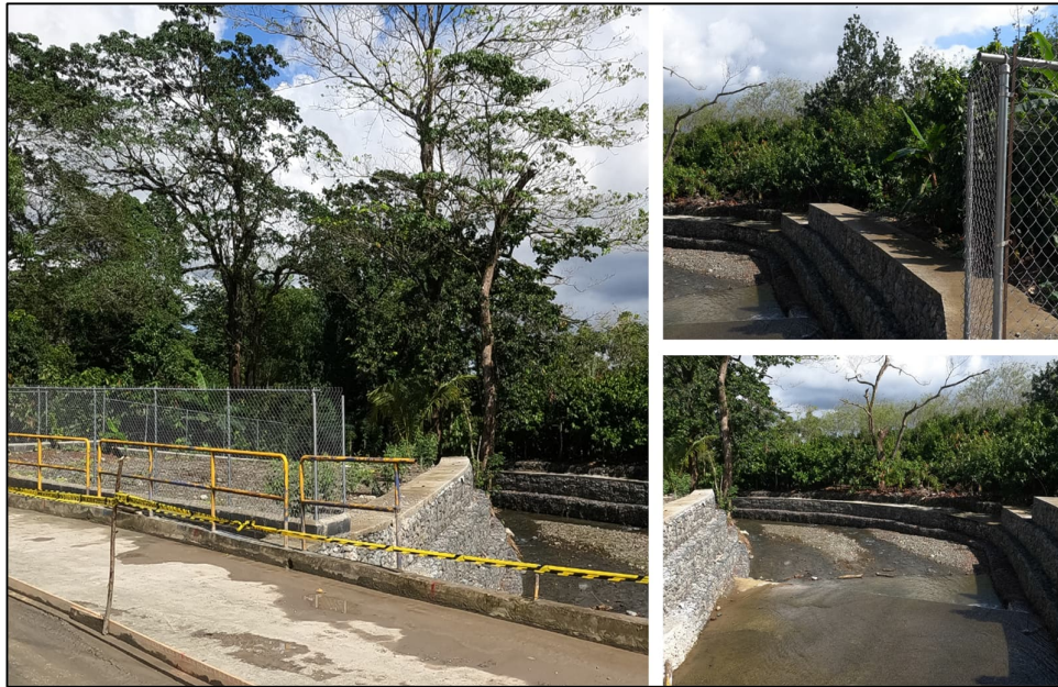
Figura 4.52: Entorno del puente P-087.
