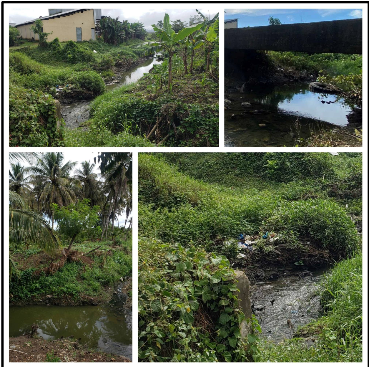
Figura 4.242: Signos de degradación y presencia de vegetación en el P-0918
