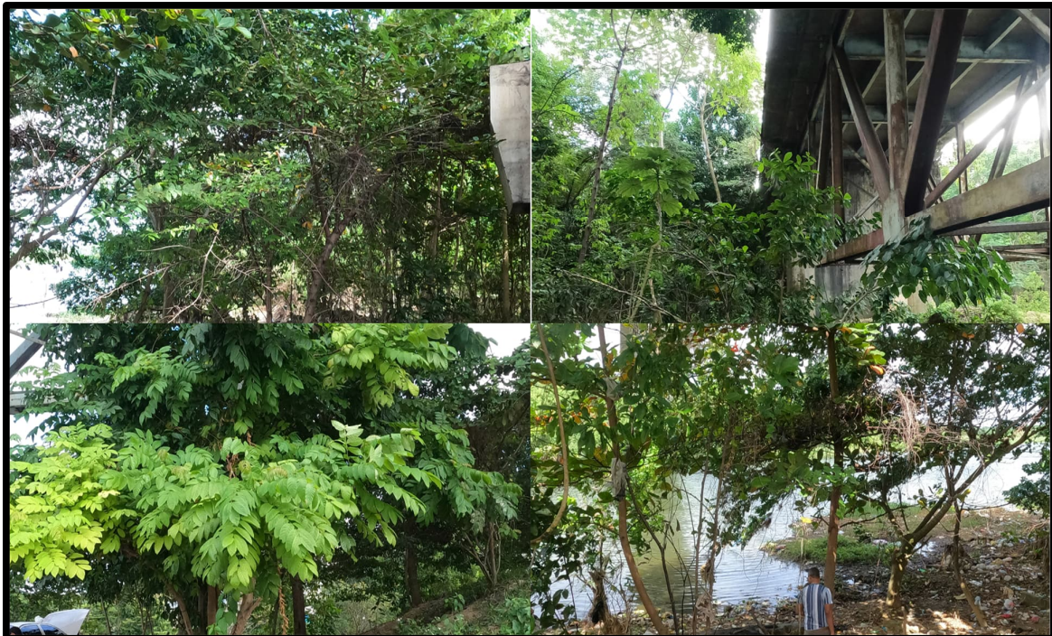
Figura 4.44: Detalle de la composición de flora generalista y transformada del puente P-070.
