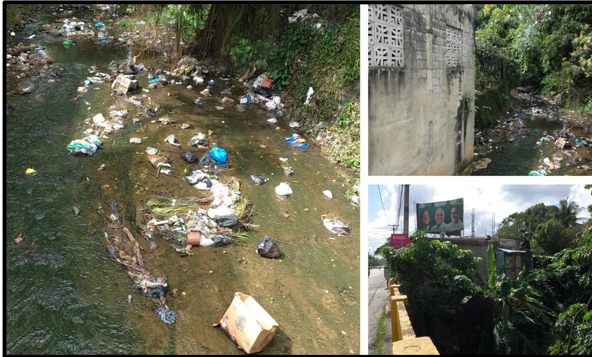
Figura 4.40: Detalles del entorno altamente transformado del puente P-068.
