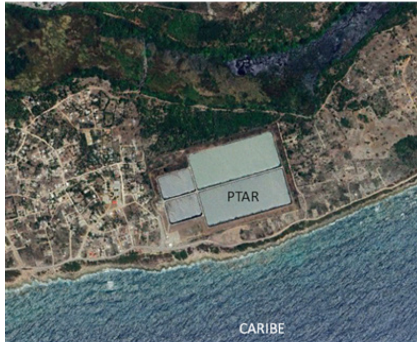
Figura 27. - Ubicación de la PTAR de SPM.
