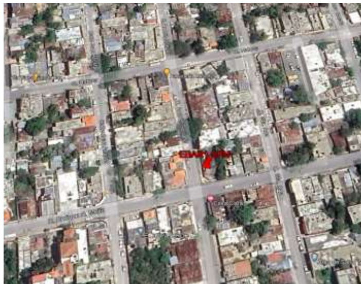
Imagen No. 17. Vista satelital del área de la EBAR 01 - Existente Fuente.: Google Earth
