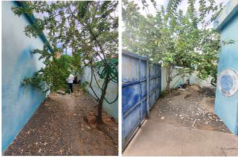
Imagen No. 62. Estación de bombeo EBAR 3 - Existente
