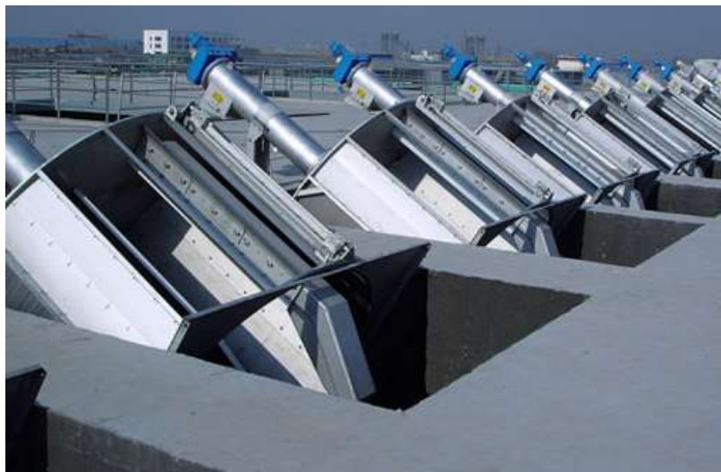
Imagen No. 12. Tamices Rotativos. Ejemplo de una instalación de tamices rotativos
