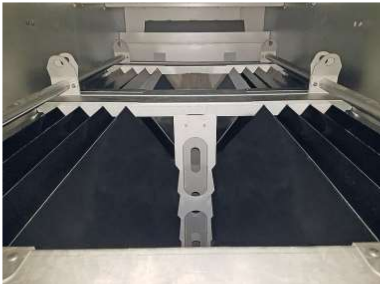
Figura 11 – Desarenador Lamelar
