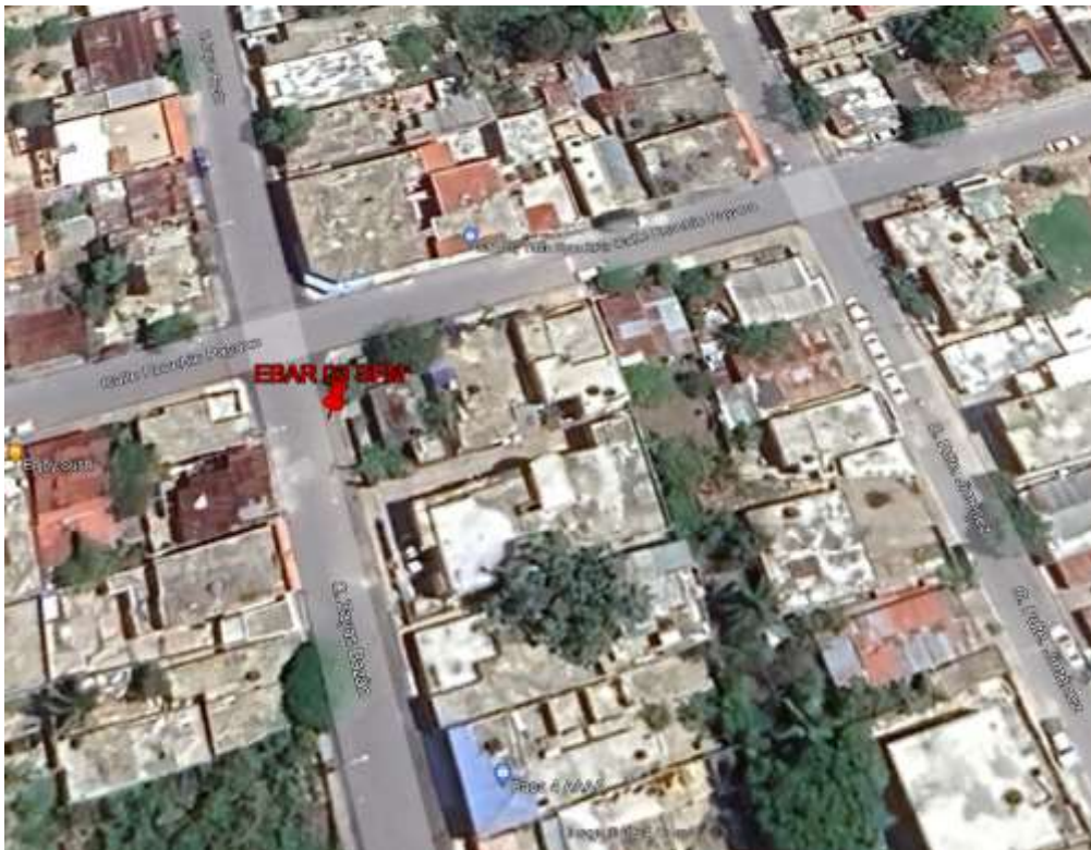
Imagen No. 19. Vista satelital del área de la EBAR 03 -Existente Fuente.: Google Earth
