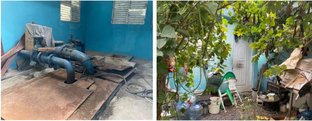
Imagen No. 27. Estación de Bombeo No. 3 - Existente
