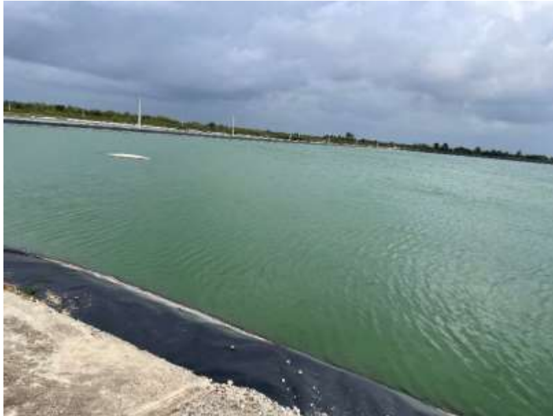
Imagen No. 31. Área de la PTAR actualmente
