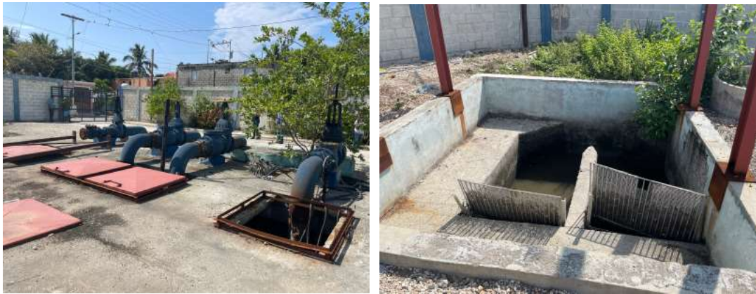
Imagen No. 28. Estación de bombeo No. 4 - Existente
