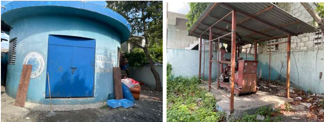
Imagen No. 26. Estación de bombeo No. 1 - Existente
