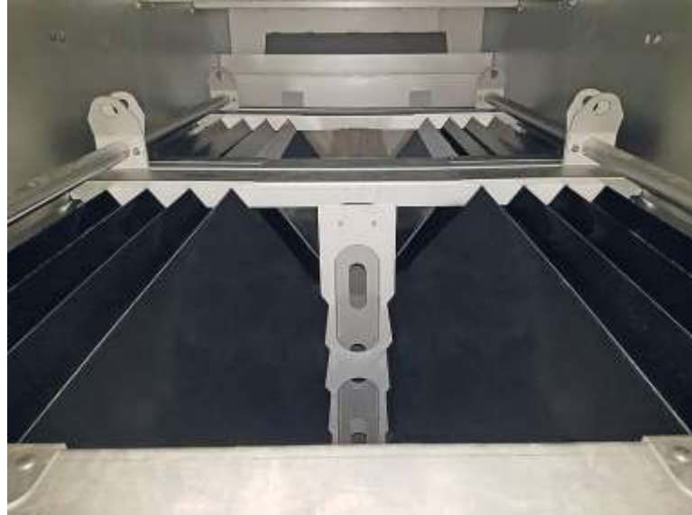
Imagen No. 11. Desarenador Lamelar. Ejemplo de una instalación con desarenador aireado en canal, con lamelas, del fabricante Huber
