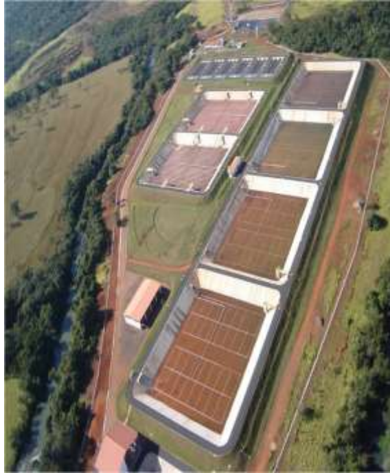
Imagen No. 5. Planta de tratamiento de Uberaba, en la modalidad DPMC
