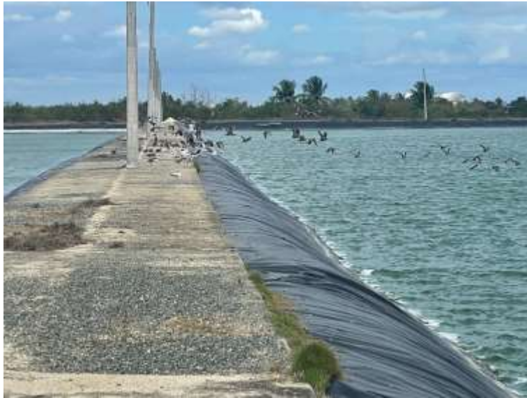
Imagen No. 36. Área del sistema de tratamiento existente
