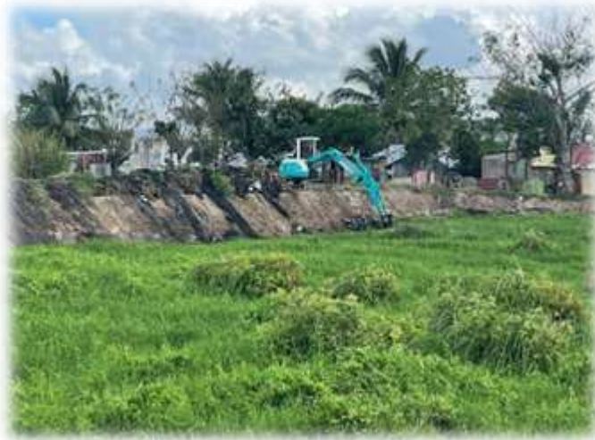
Imagen No. 28. Área de la PTAR actualmente
