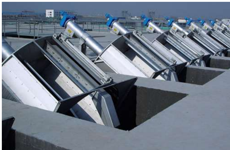
Imagen No. 9. Tamices rotativos Fuente.: (Dieter Neder, 2024)
