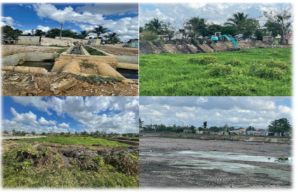
Se identificó que el tramo "CM Benito González 024" (actual CM Benito González 021) cruza un canal con gran profundidad (> 5.00m). Punto de observación en el proyecto.
