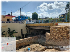
Se identificó que el tramo "CM Benito González 024" (actual CM Benito González 021) cruza un canal con gran profundidad (> 5.00m). Punto de observación en el proyecto.
