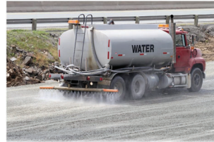
Reguío de los caminos no pavimentados
