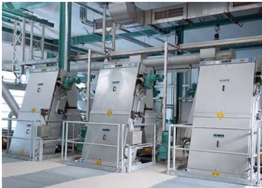
Imagen No. 7. Rejillas de barras mecanizada Fuente.: (Dieter Neder, 2024)
