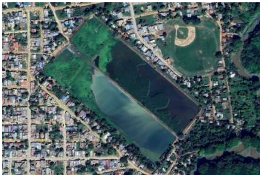
Figura 4- Condición actual de la planta de tratamiento existente en el área urbana de Higüey
