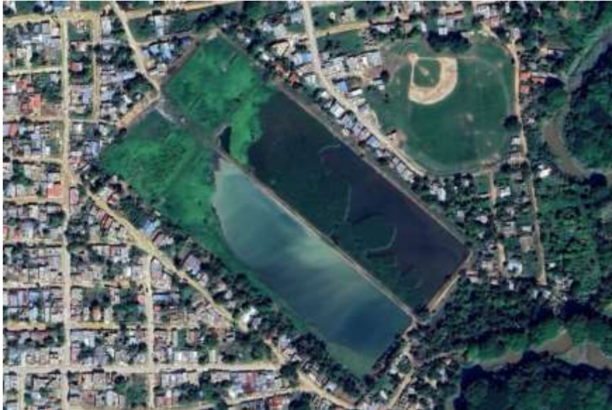
Imagen No. 4. Condición actual de la planta de tratamiento existente en el área urbana de Higüey Fuente.: (Dieter Neder, 2024)
