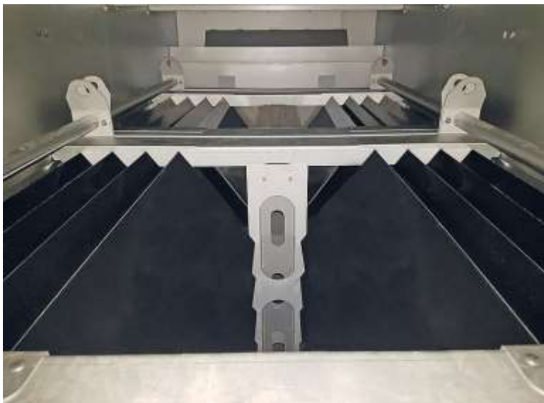
Figura 7 – Desarenador Lamelar
