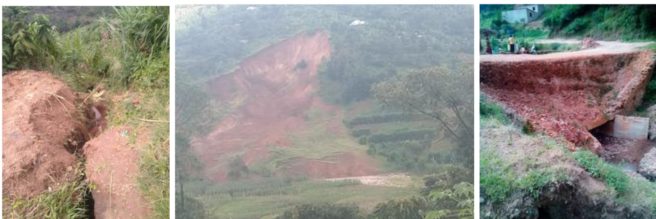
Planche 3: Ravin et glissement à Isare (Karunga et Sagara) + route Astrida menacée (Kanyosha)
