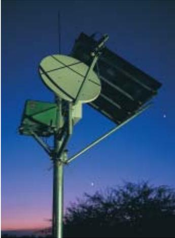
**Figura N° 4.o** Estación rural VSAT en África
