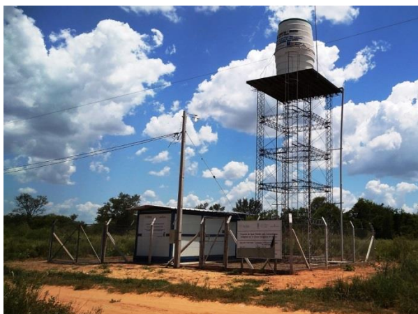
Estación de distribución de agua en 12 de Junio
