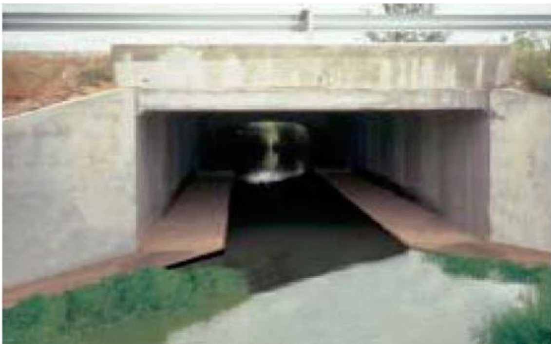
Foto 14 – Drenaje Adaptado para Paso de Fauna. Nótese la Conexión de las Plataformas con las Rampas de Acceso
