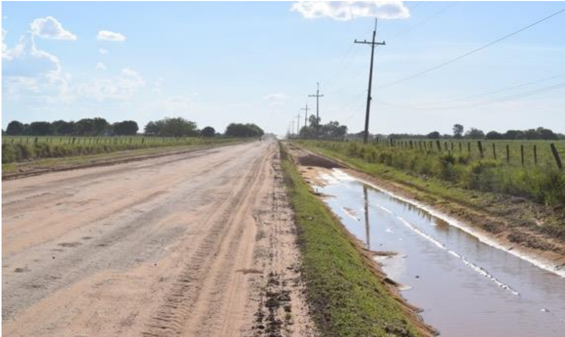
Foto 03 – Obras de Mantenimiento de la Vía
