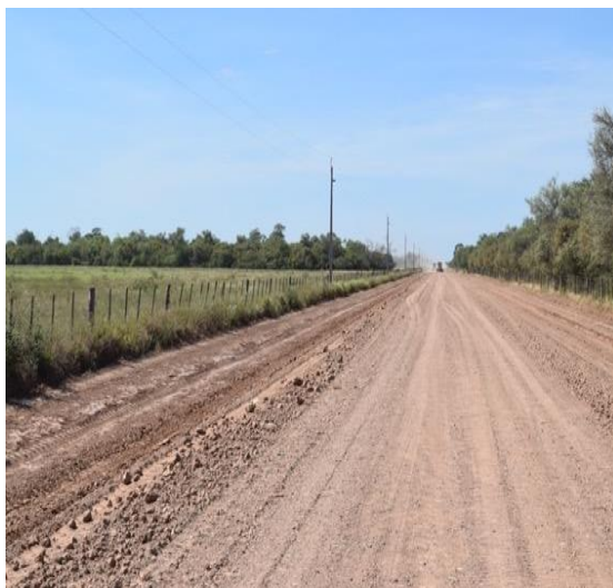
Camino en Reparación Próximo al Cruce Lolita
