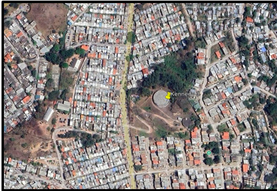
Figura 72 – Vista aérea Kenndey 3. Fuente: Google Earth (2026).
