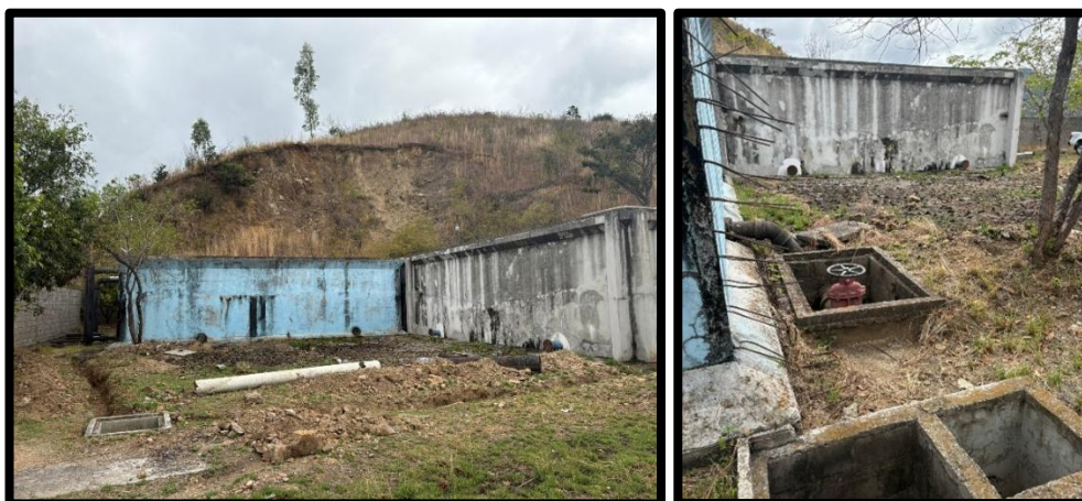
Figura 59 – Tanques existentes El Molinón. Fuente: relevamiento (2026).
