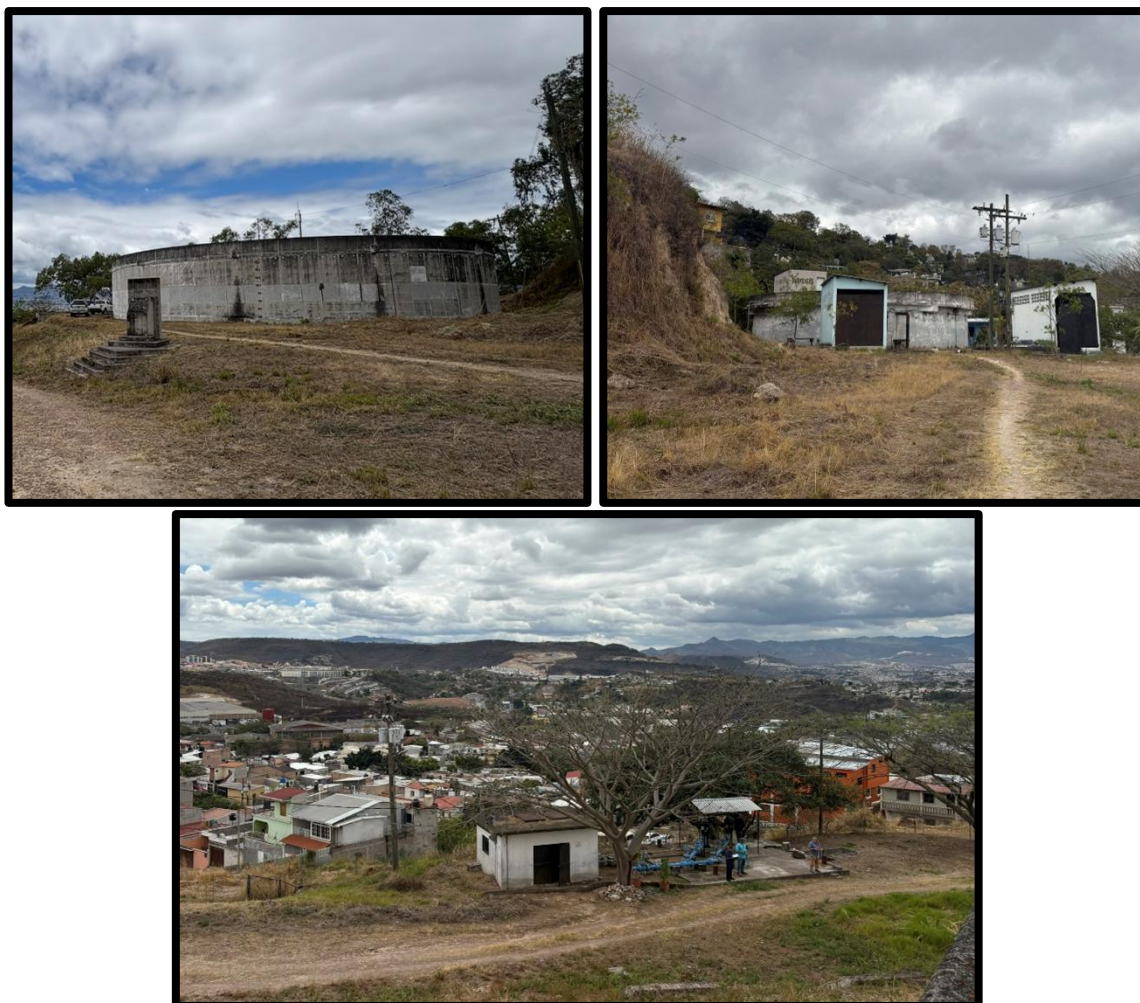
Figura 74 – Tanque principal, secundario y estación de bombeo en sistema tanque Kennedy 3. Fuente: relevamiento (2026).
