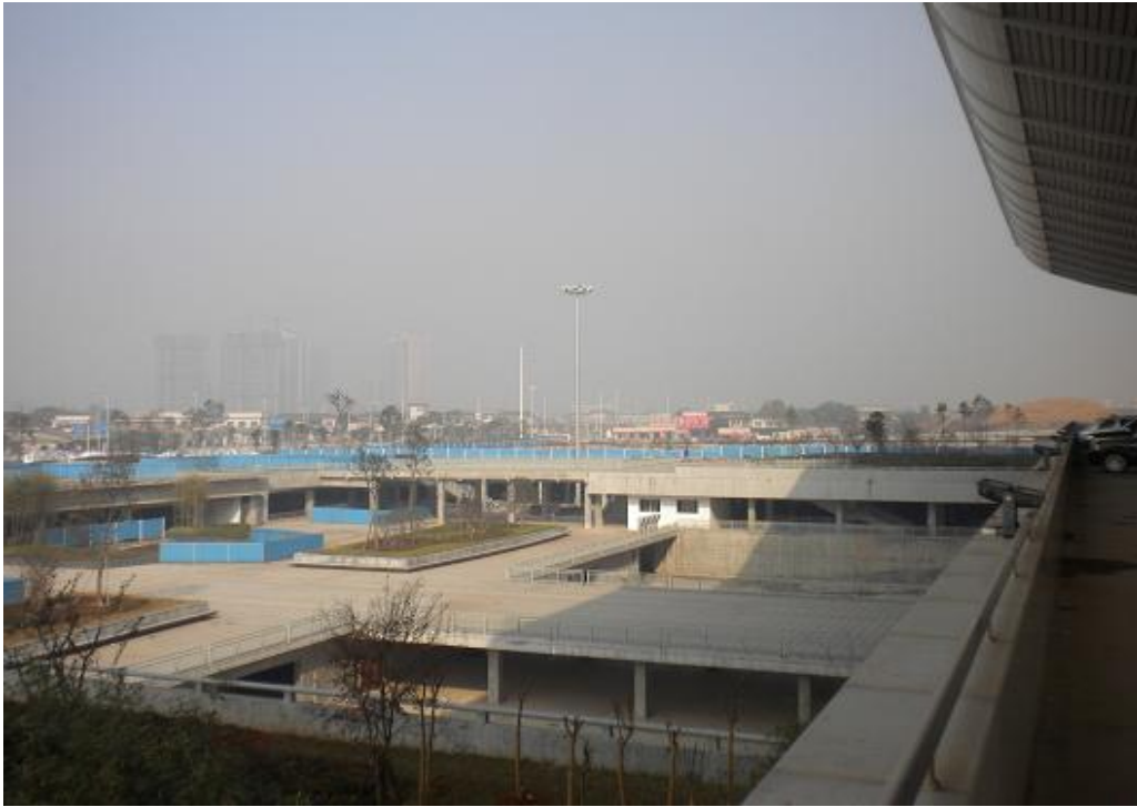
图 2-7 工程施工现场
