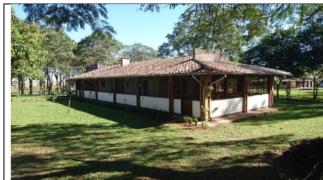
Fig. 64: Edificación con instalaciones para reuniones y oficinas.
