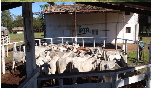
Fig. 68: Mangas de Madera fijos, Estado regular que requiere mantenimiento.
