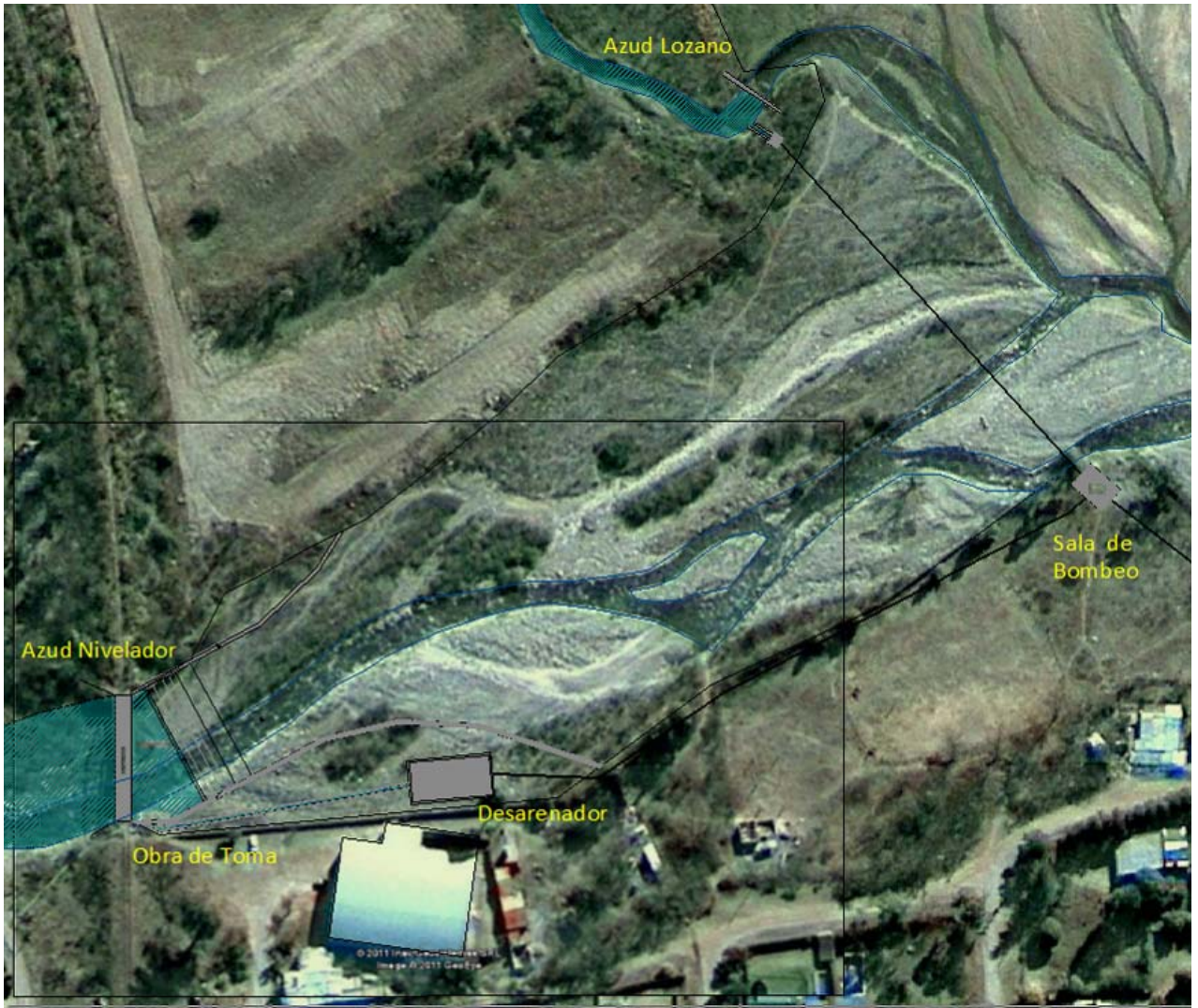
Figura 5 Ubicación de obras de captación y conducción hasta la planta Alto Reyes.
