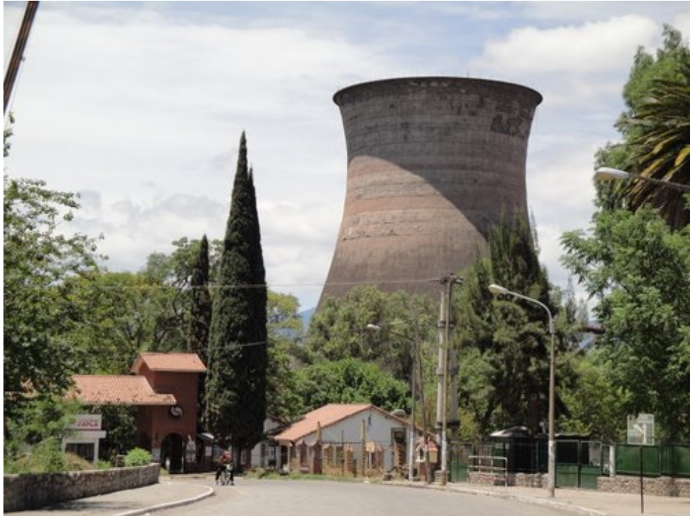
Figura 28 Torre de Enfriamiento Altos Hornos Zapla
