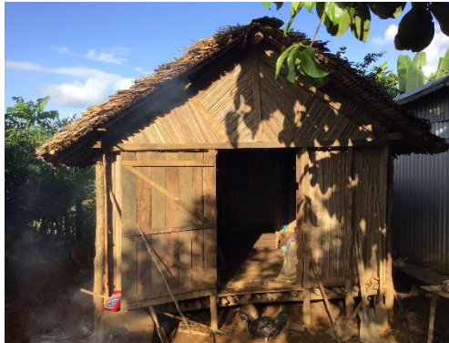
Figure 9 : les maisons en bois local avec la toiture en feuille de ravinala
