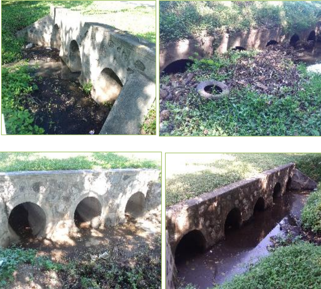
Figura N° 10 obras de drenaje principales que atraviesan el proyecto
