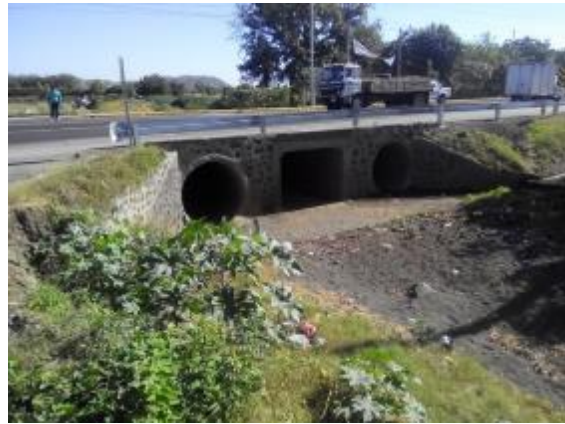
Foto 1 Puente de Saratoga.
