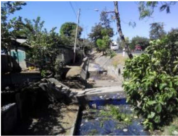
Foto 4 Presencia de cunetones y canalizaciones de drenaje.
