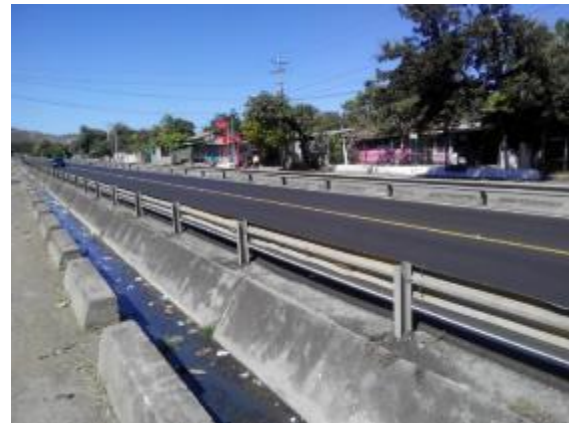
Foto 4 Presencia de cunetones y canalizaciones de drenaje.
