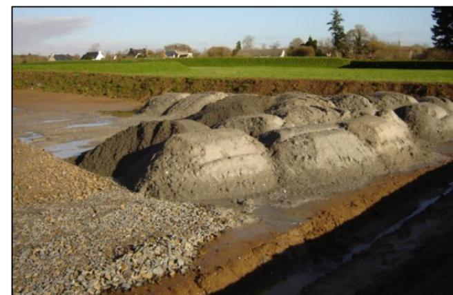
**Illustration 45 : Aménagement d'un dépôt de dragage par paliers**
